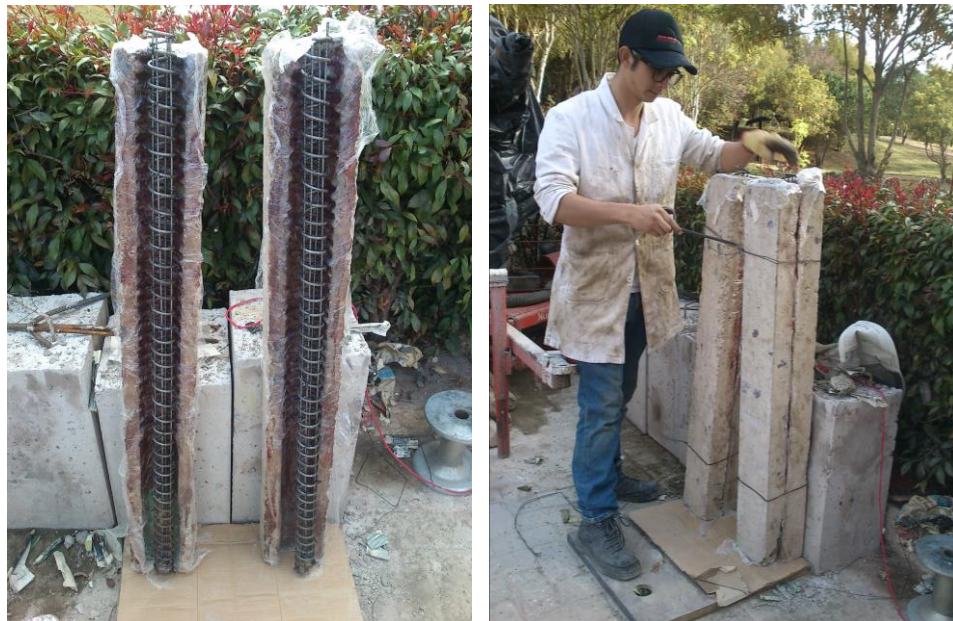
Figura 37. Espirales de refuerzo y moldes preparados para fundir el concreto.
