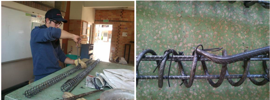
Figura 34. Armado de la espiral del refuerzo y acero longitudinal.
