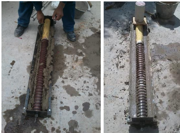
Figura 30. Vaciado de concreto dentro de la formaleta metálica para los moldes.
