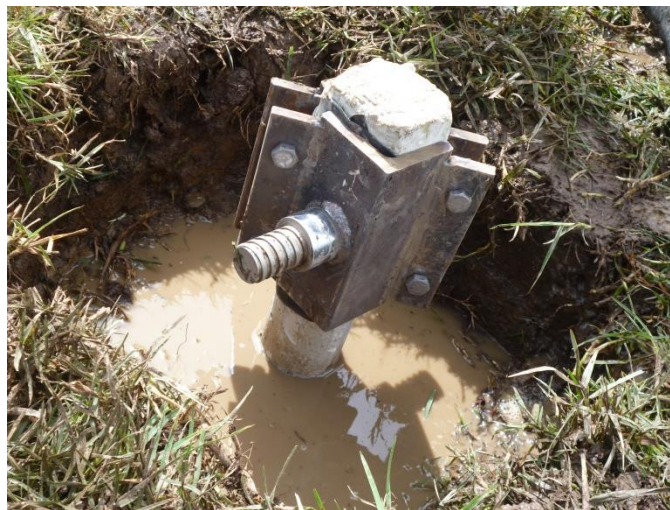
Figura 50. Dispositivo utilizado para la instalación de los micropilotes.
