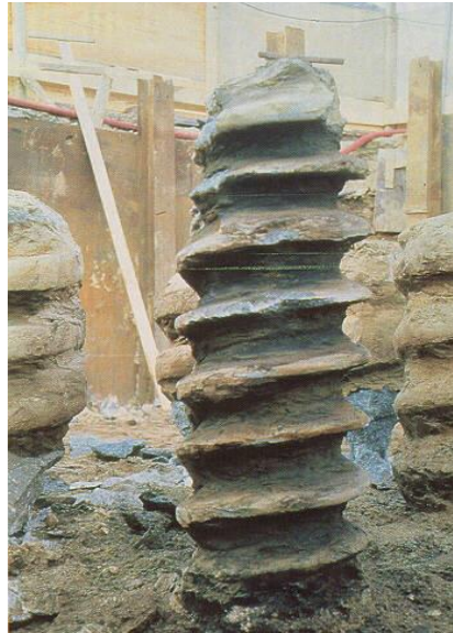
Figura 10. Fuste de un pilote tipo "Atlas".
