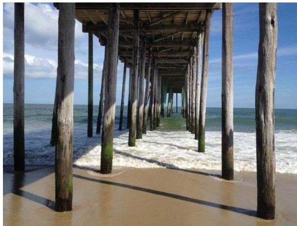
Figura 4. Muelle sostenido sobre pilotes de madera.
