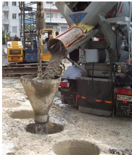
Figura 6. Vertimiento de concreto en la excavación de un pilote.
