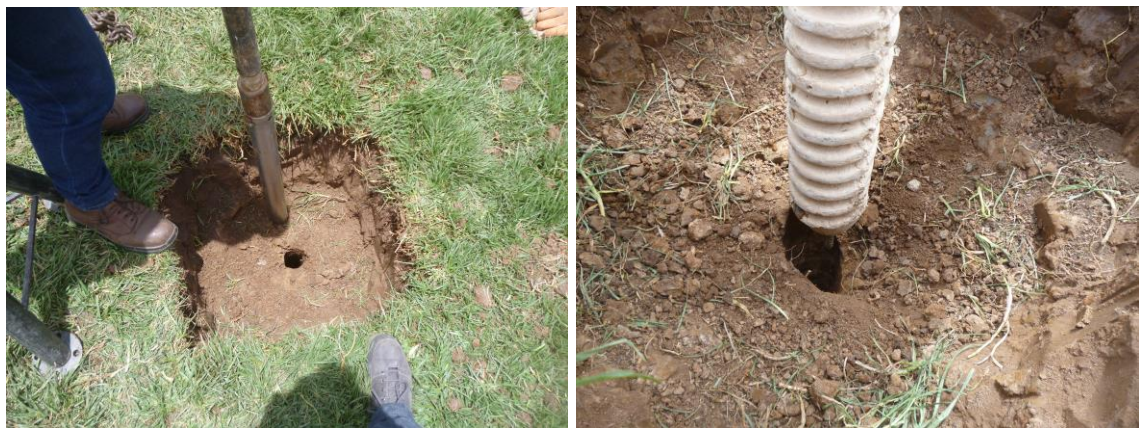
Figura 59. Estado del terreno en la instalación de los primeros micropilotes fabricados.
