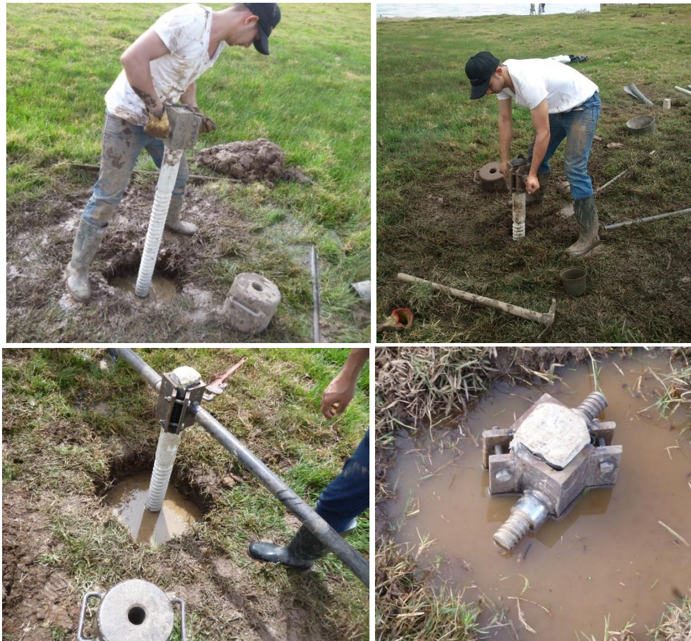
Figura 51. Instalación de los pilotes roscados.
