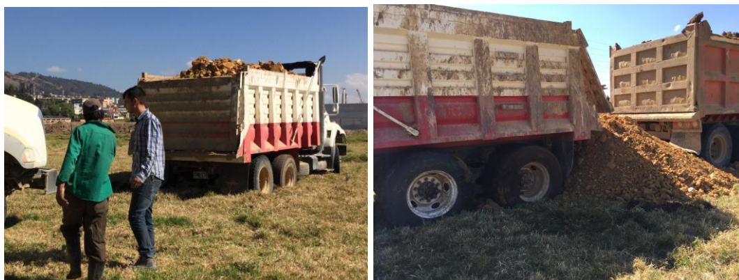
Figura 54. Doble troque cargada utilizada como contrapeso.
