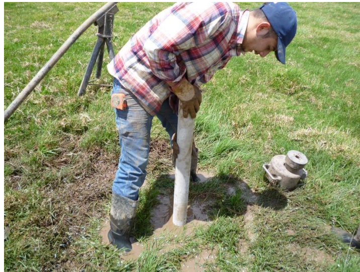
Figura 52. Instalación de los pilotes lisos.
