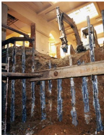
Figura 12. Recalce de una cimentación dentro de una edificación existente.
