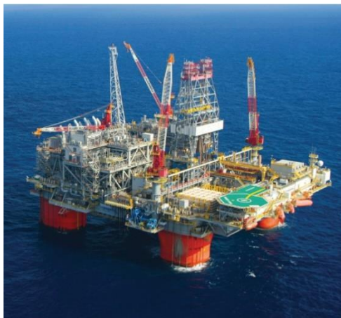
Figura 2. Estación petrolera apoyada sobre pilotes en medio del océano.
