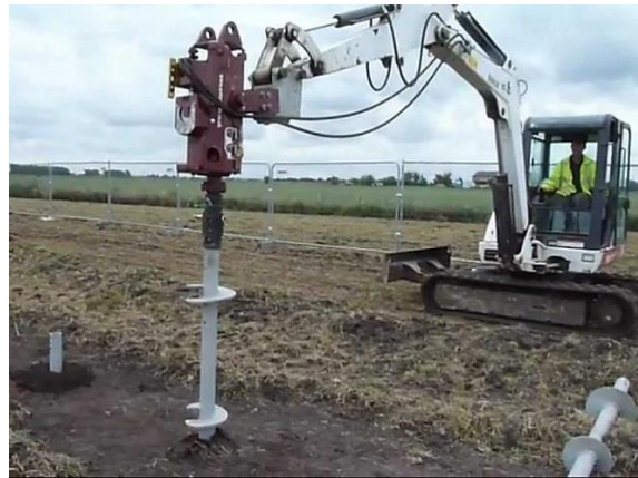
Figura 9. Instalación de un pilote de desplazamiento por medio de rotación.
