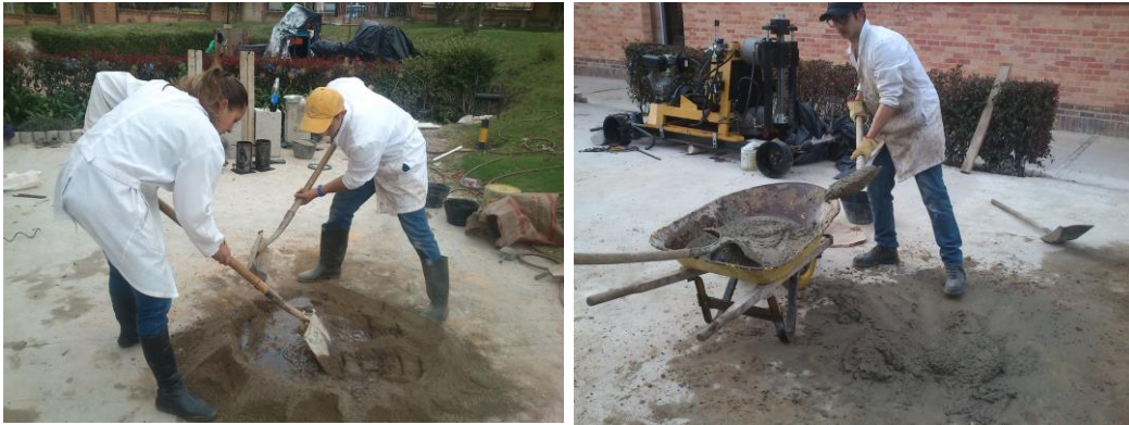
Figura 38. Elaboración de la mezcla de concreto.
