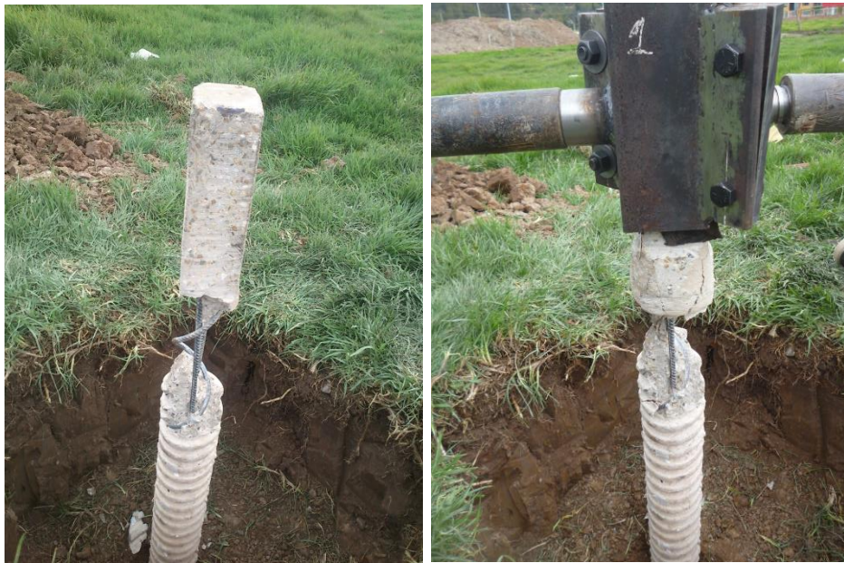
Figura 53. Falla estructural en un micropilote roscado.
