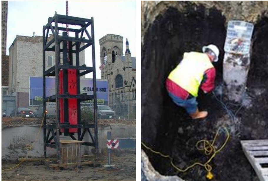
Figura 16. Ejecución de una prueba de carga dinámica a un pilote.
