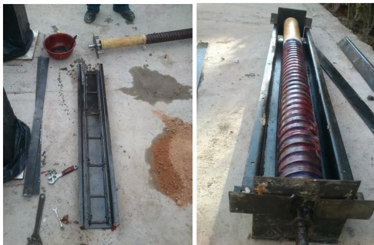
Figura 29. Ubicación de la armadura de refuerzo y del modelo en acero dentro de la formaleta metálica.
