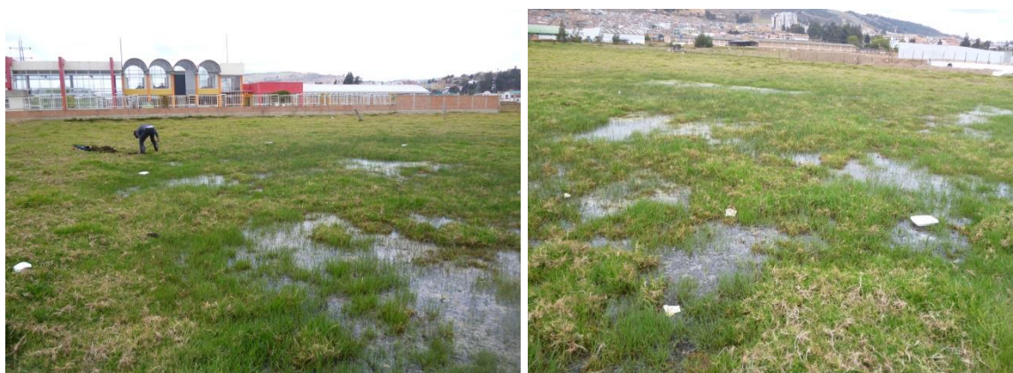
Figura 48. Estado del lote en el momento de instalación de los pilotes.
