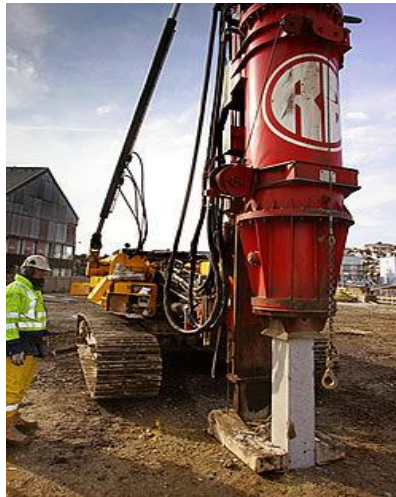
Figura 8. Hincado de un pilote de concreto.
