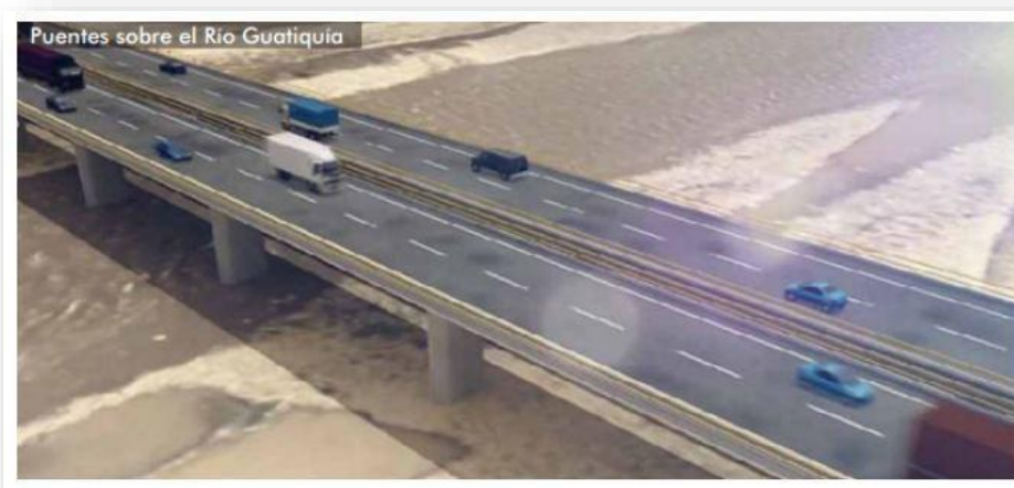
Figura 34 Puente sobre el río guatiquia.
