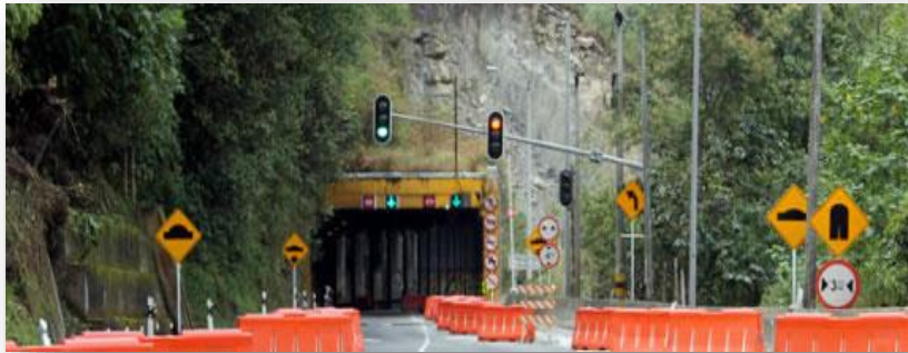
Figura 23 Túnel quebrada blanca.
