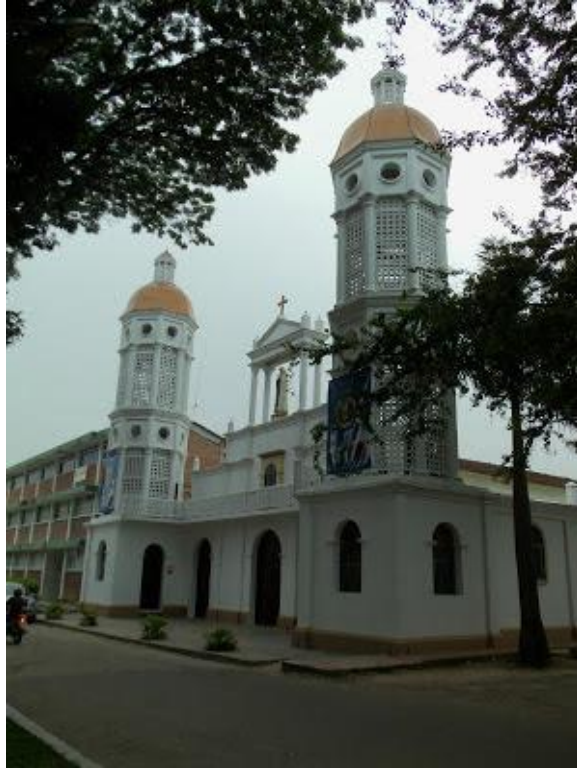
Figura 14. Iglesia Fátima. Fotografía tomada por autor. 2017.
