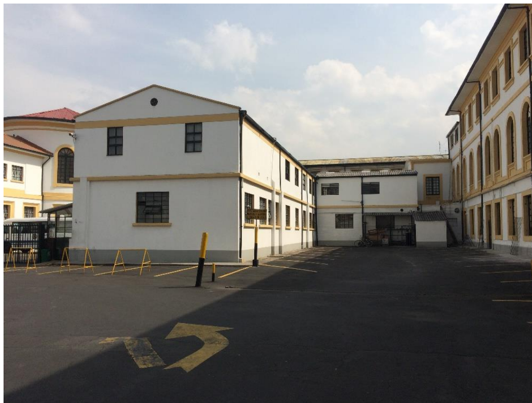
Ilustración N°8-7: Pabellón de Pediatría del Hospital San José (No pertenece a la categoría B.I.C). Fuente: Autor
