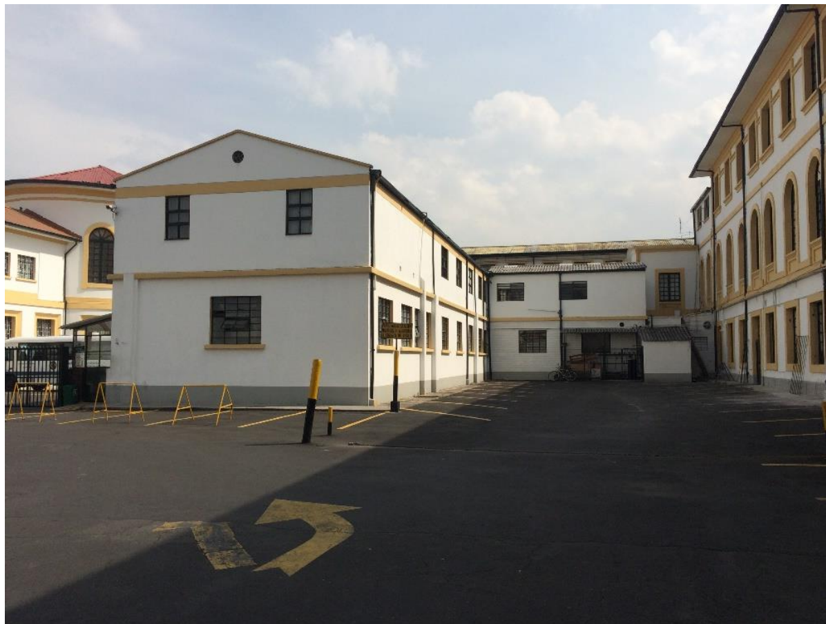
Ilustración N° 10-1: Fachada patrimonial a recuperar Pabellón Guillermo Gómez (Lado derecho de la foto). Fuente: Autor.
