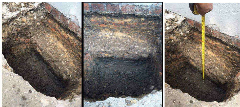
Ilustración N° 8-15: Apique realizado para extracción de ladrillo para ensayos de laboratorio- Tipo de suelo y cimentación encontrada. Fuente: Autor.
