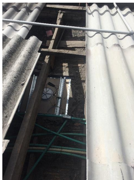
Ilustración N°8-26: Perforaciones realizadas para instalación de ductos. Fuente: Autor
