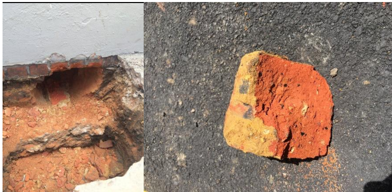
Ilustración N°8-17: Ladrillo de arcilla cocida extraído para ensayo. Fuente: Autor.
