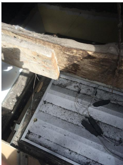
Ilustración N°8-27: Sección de la cercha en madera cortadas para instalación de ductos.
