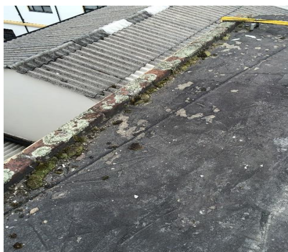
Ilustración N°8-30: Unión de la placa de cubierta y el muro, se encuentran lesiones de tipo biológico. Fuente: Autor
