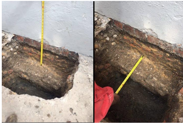
Ilustración N°8-16: Medición de la cimentación encontrada. Fuente: Autor.
