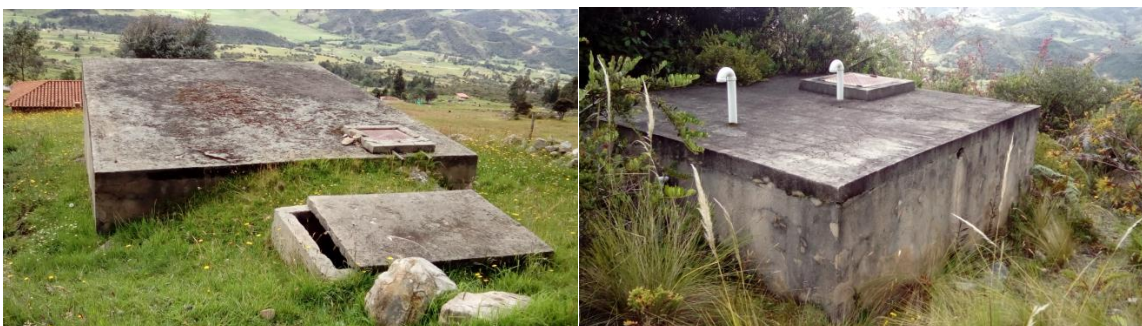
Fotografía 9 Tanques de almacenamiento acueducto Guancha, municipio Chiquiza - Boyaca. Fuente: El Autor (2016).
