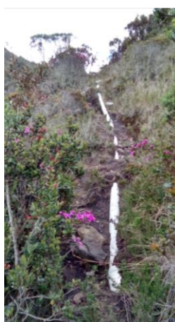
Fotografía 4 Red aducción acueducto Cazadero, municipio Chiquiza - Boyaca. Fuente: El Autor (2016)
