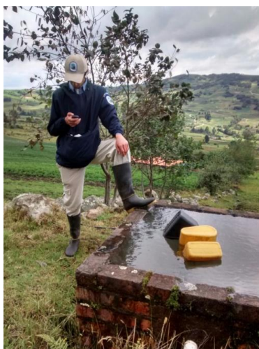
Fotografía 6 Cámara de quiebre – Cazadero, municipio Chiquiza - Boyaca. Fuente: El Autor (2016)
