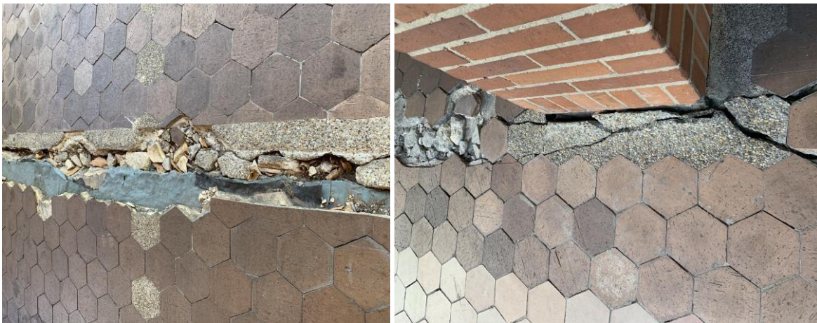
Figura 14. Placa de contra-piso en área de Parquaderos / Fuente: Propia.
