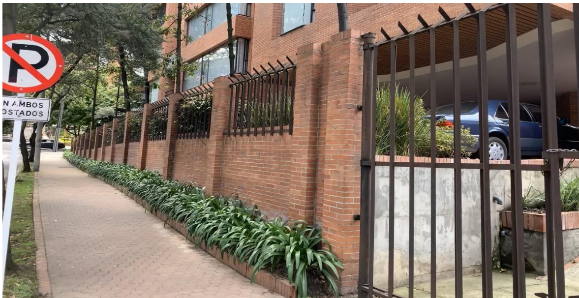
Figura 8. Cerramiento edificio residencial Bosques de la Cabrera / Fuente: Propia.
