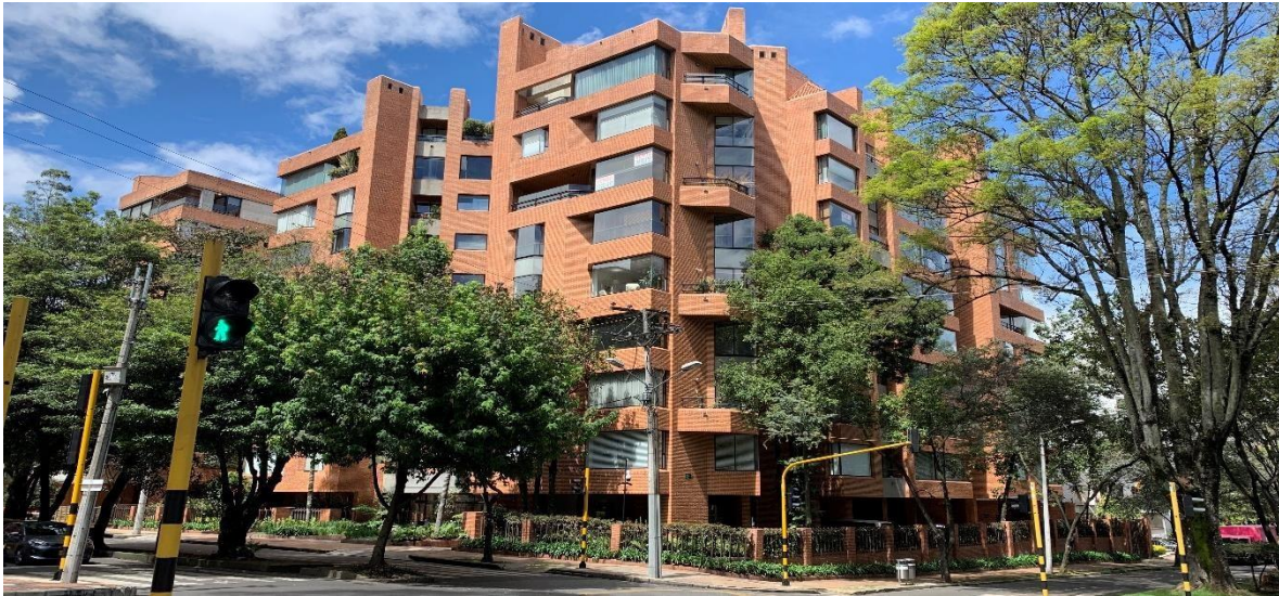
Figura 7. Edificio residencial Bosques de la Cabrera / Fuente: Propia.
