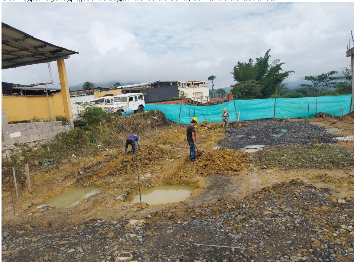
Figura 30. Registro fotográfico de seguimiento de obra, cerramiento del área.
