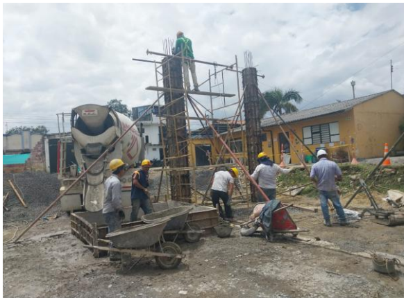
FUNDIDA DE COLUMNAS MODULO 3
