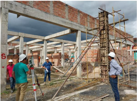
REVISION DE ALINEAMIENTOS VERTICALES Y HORIZONTALES DE COLUMNAS
