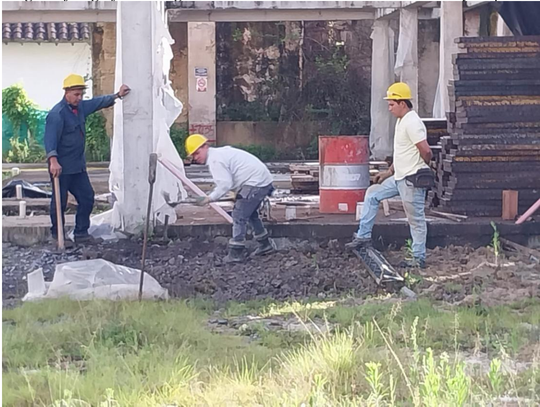
Figura 24. Registro fotográfico de seguimiento de obra, actividad mantenimiento y limpieza.
