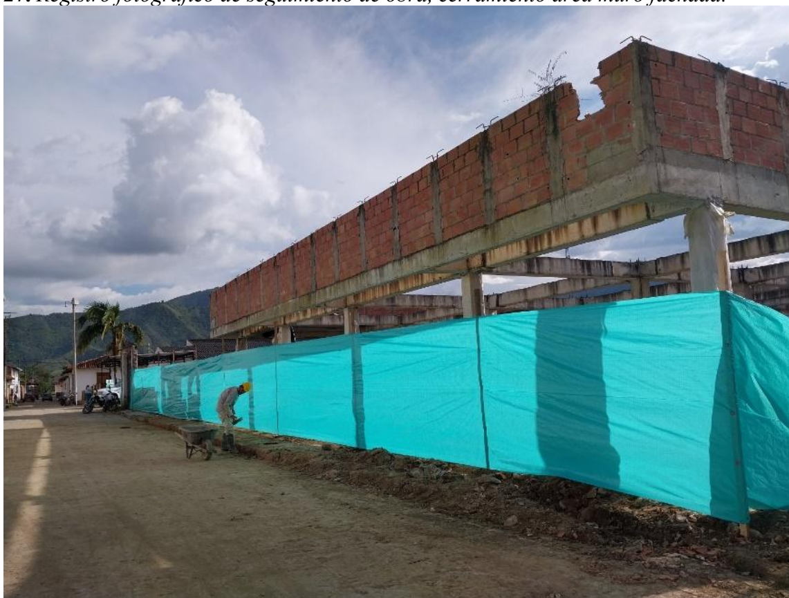
Figura 27. Registro fotográfico de seguimiento de obra, cerramiento área muro fachada.
