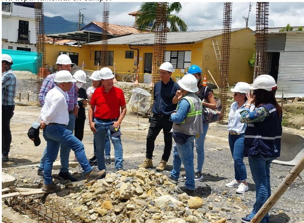
Figura 26. Registro fotográfico de seguimiento de obra, visita de obra mesa de moralización contraloría departamental en campo.
