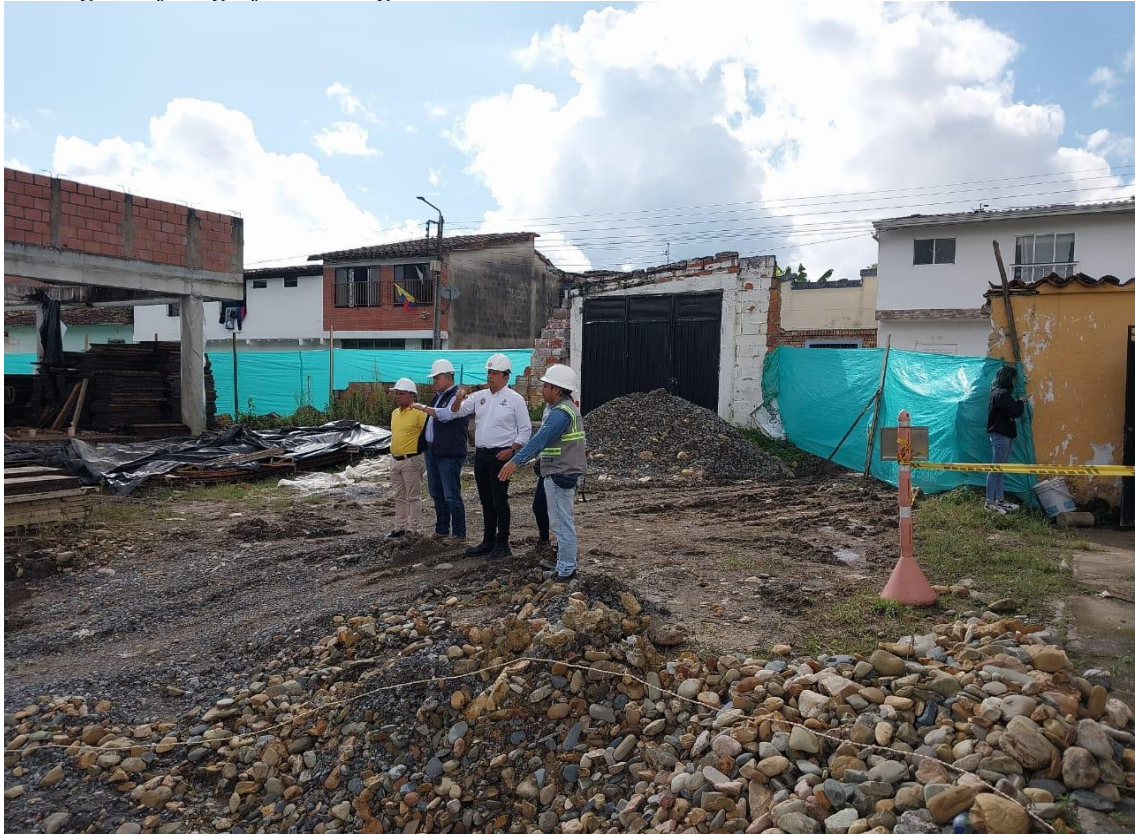
Figura 28. Registro fotográfico de seguimiento de obra, cerramiento del área.
