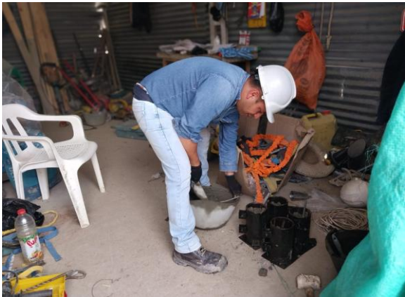
TOMA DE MUESTRAS DE CONCRETO INTERVENTORIA
