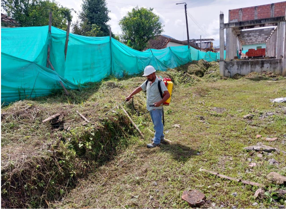
Figura 29. Registro fotográfico de seguimiento de obra, cerramiento del área y fumigación del área.
