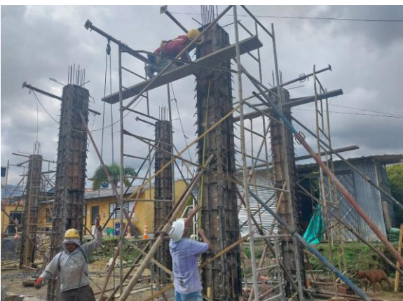
FUNDIDA DE COLUMNAS MODULO 3
