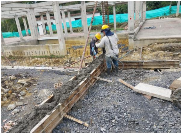
FUNDIDA DE VIGAS DE CIMENTACION
