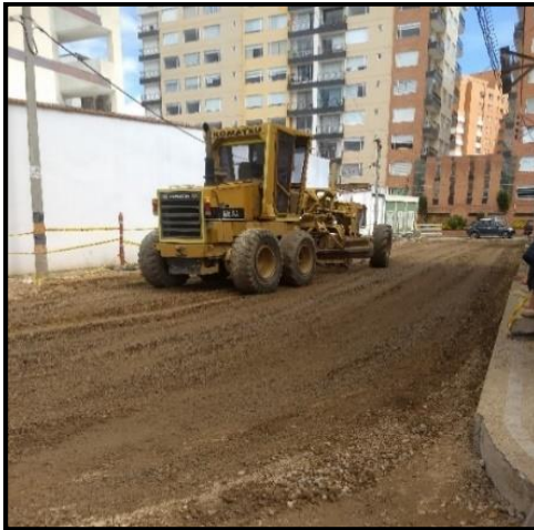
Ilustración 15. Extendido de Base Granular.
