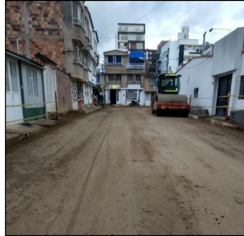
Ilustración 16. Compactación de Base granular.
