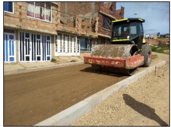
Ilustración 36. Compactación de Base granular.
