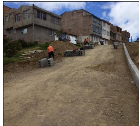
Ilustración 38. Instalación de sardinel A-10.
