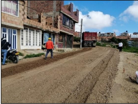
Ilustración 35. Extendido de Material de Base granular.
