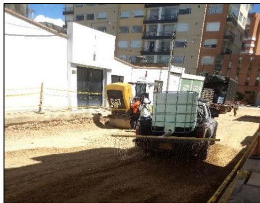
Ilustración 10. Humectación de Sub-base granular.
