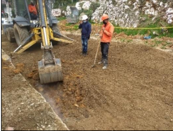
Ilustración 29. Excavación mecánica para retiro de material de subrasante saturado.
