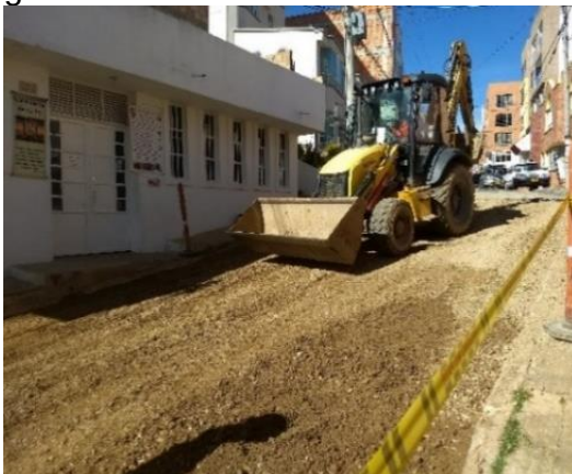
Ilustración 27. Extendido de Base granular.
