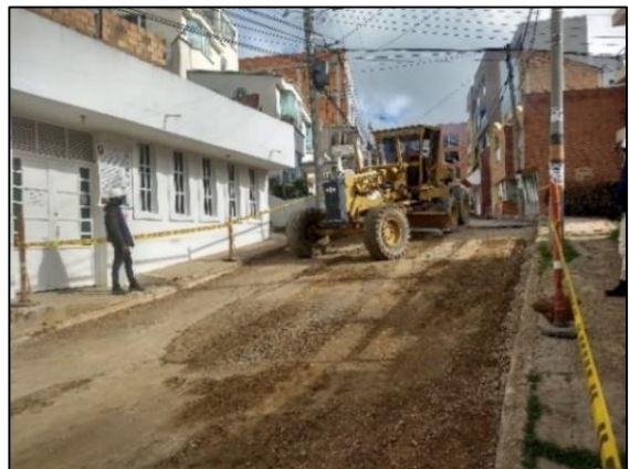
Ilustración 28. Nivelación de Base granular.
