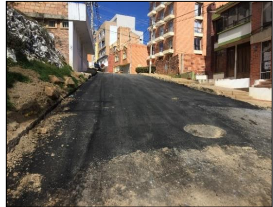
Ilustración 32. Capa de Base granular con emulsión asfáltica CRL-H1.
