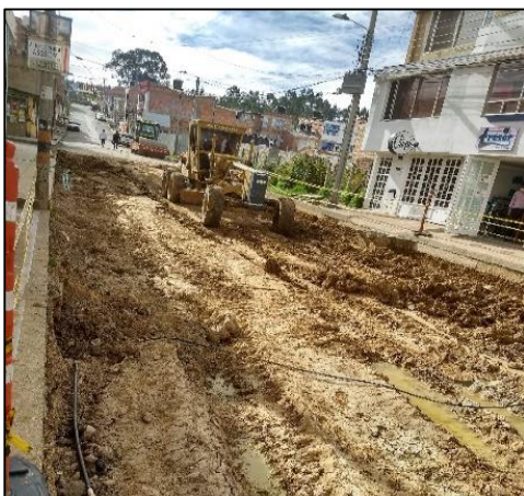
Ilustración 25. Nivelación y conformación de subrasante.
