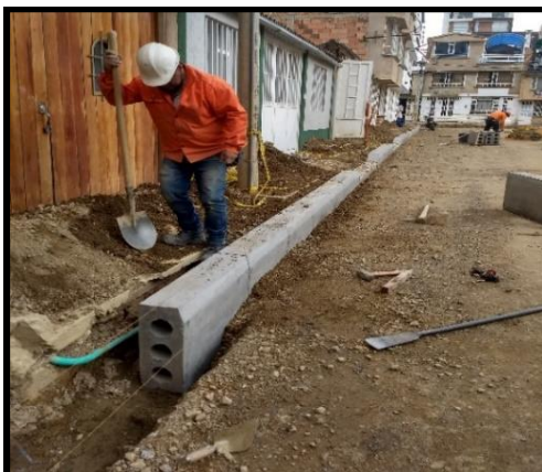
Ilustración 17. Instalación de Sardinel prefabricado A-10.
