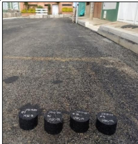
Ilustración 22. Briquetas elaboradas para control de Calidad de mezcla.
