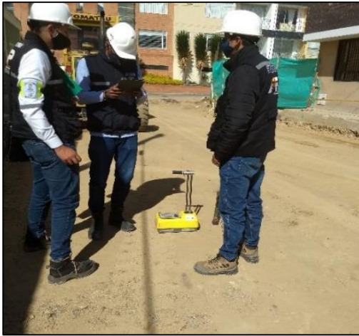
Ilustración 13. Toma de Densidades en Sub-base granular, por densímetro nuclear.
