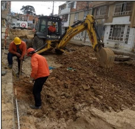
Ilustración 23. Excavación mecánica para estructura de pavimento.
