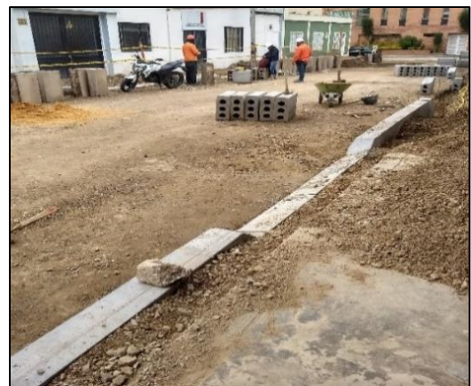
Ilustración 18. Sardinel A-10, A-100 y A-85 instalado.
