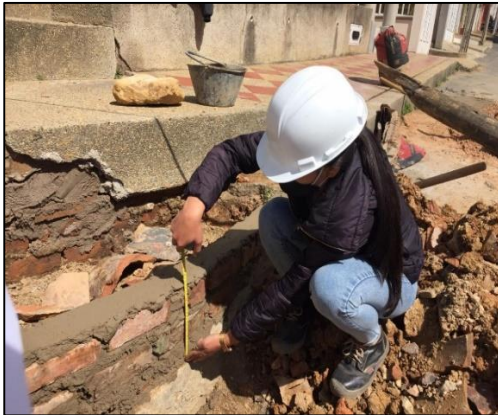
Ilustración 43. Medición Construcción de hiladas en mampostería.
