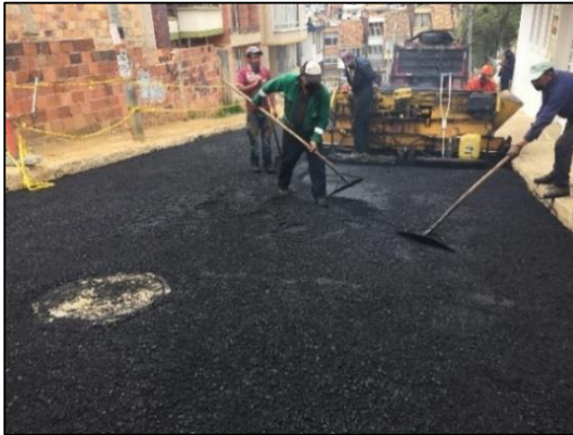
Ilustración 33. Extendido de carpeta asfáltica.
