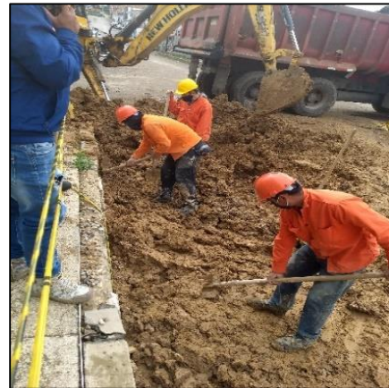
Ilustración 24. Excavación manual Para perfilamiento de caja.
