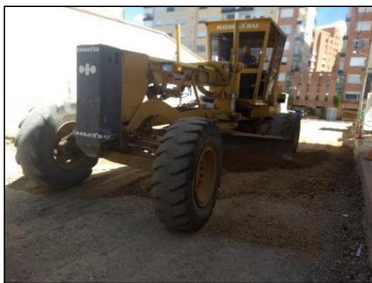
Ilustración 9. Extendido de Sub-base granular.
