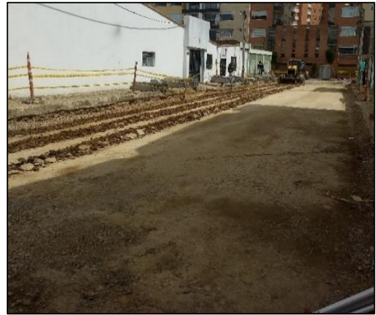
Ilustración 12. Escarificación de capa de Sub-base granular por altos Niveles.
