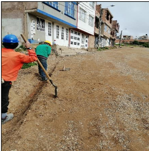
Ilustración 37. Excavación manual, para instalación de sardinel.
