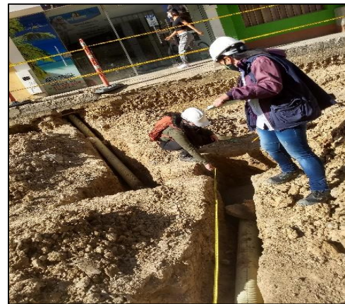
Ilustración 44. Medición de excavación manual y metro lineal de tubería.
