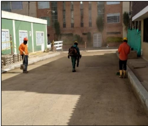
Ilustración 19. Soplado de superficie, previo a imprimación asfáltica.
