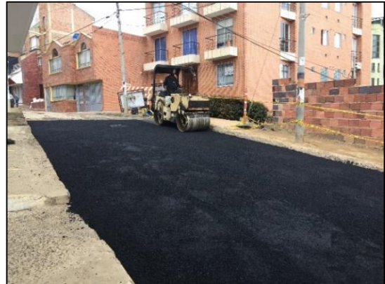
Ilustración 34. Compactación de Carpeta asfáltica.
