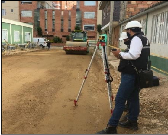
Ilustración 11. Toma de niveles a sub-base por parte de interventoría para la respectiva aceptación.
