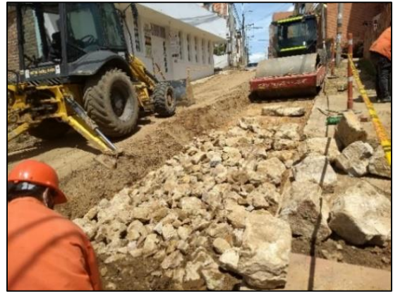
Ilustración 30. Colocación de piedra rajón, para mejoramiento de Subrasante.
