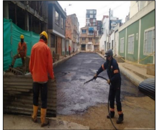
Ilustración 20. Riego de imprimación asfáltica.
