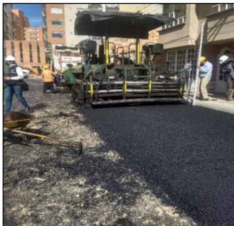
Ilustración 21. Instalación de carpeta asfáltica MDC-19.
