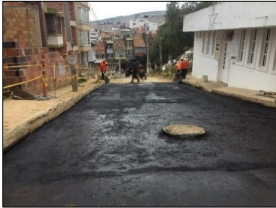
Ilustración 31. Tramo ya con Riego de imprimación asfáltica.
