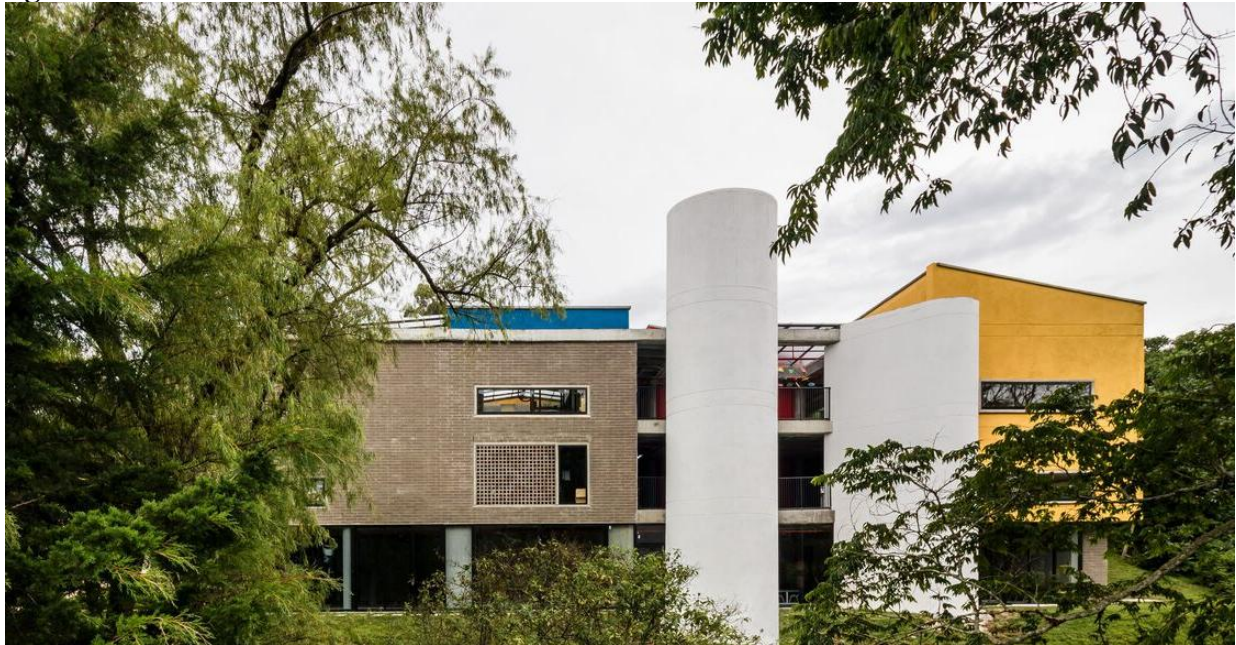
Figura 13. Vista Exterior CDI Casas del mar.
