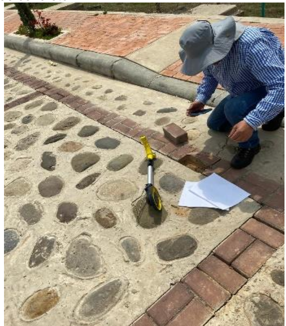
Ilustración 38. Medición del espesor de la placa de concreto
