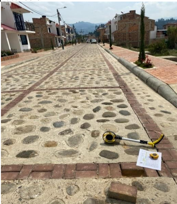
Ilustración 37. Toma de medidas de la placahuella
