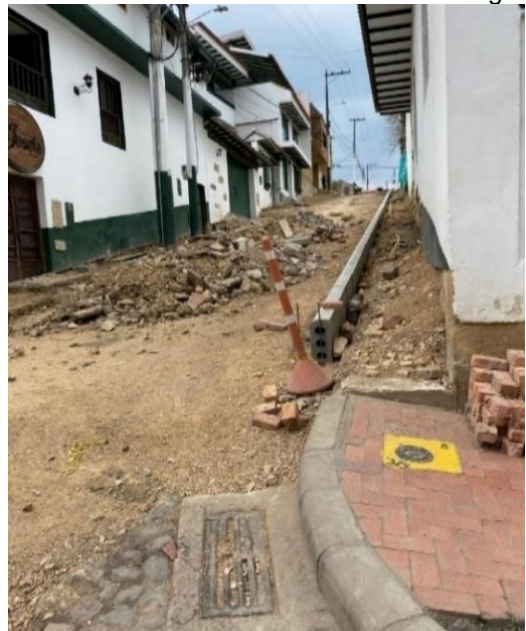
Ilustración 26. Demolición de andén antiguo
