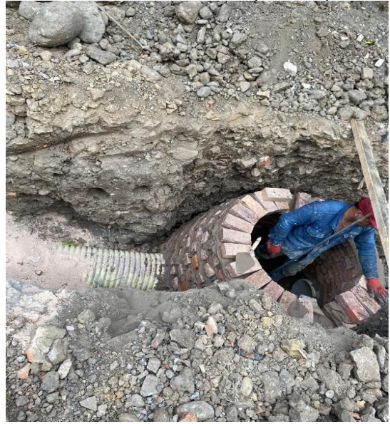
Ilustración 32. Pozo 2 de inspección pluvial
