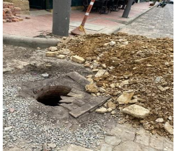
Ilustración 26. Demolición de andén antiguo
