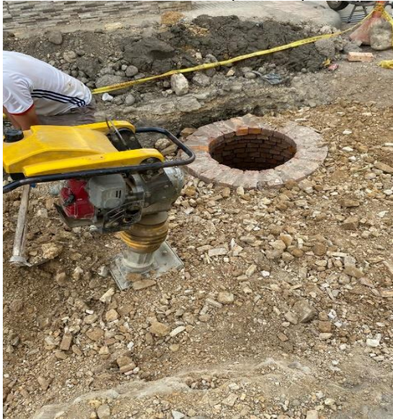
Ilustración 31. Pozo 1 de inspección pluvial
