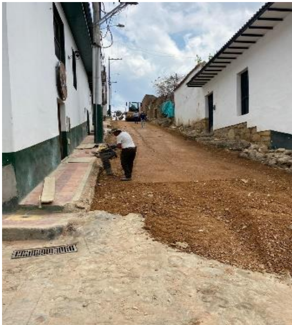
Ilustración 25. Compactación de la vía
