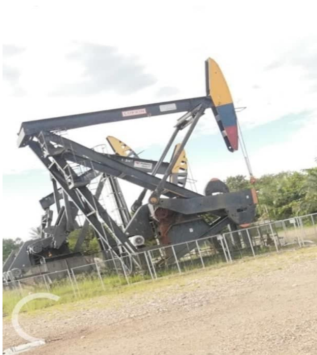
Figura. 21 Machin o Bomba de varilla para la extracción de petróleo Fuente: Autor
