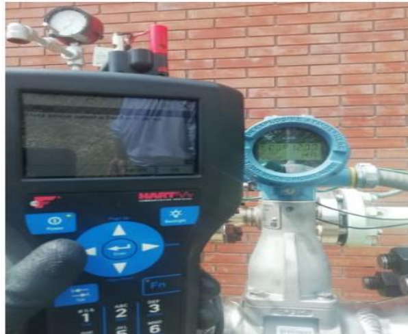
Figura. 33 Configuración transmisores FIT, PIT Fuente: Autor
