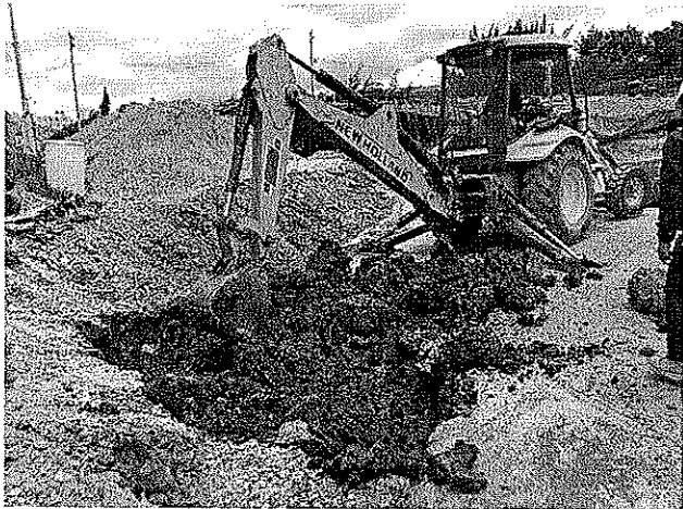
Retiro de material para mejoramiento de suelo acceso tierra armada costado oriental
