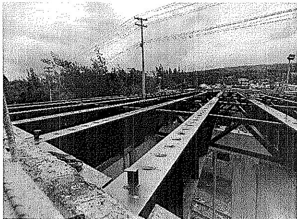
Retiro de transmisores de cortante super estructura central
