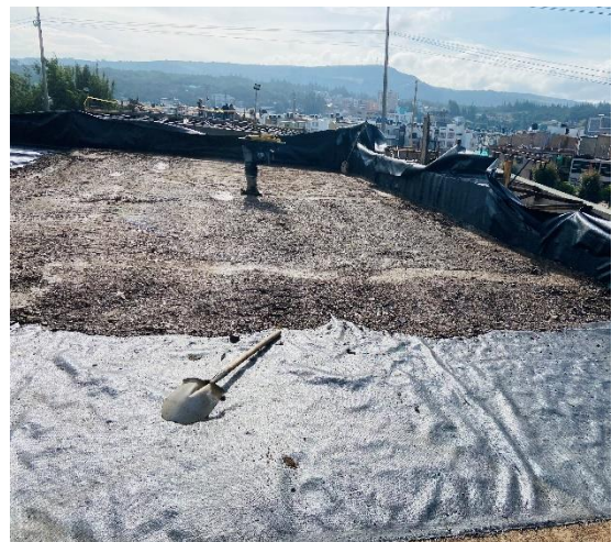
Compactación capa numero 17 de tierra armada
