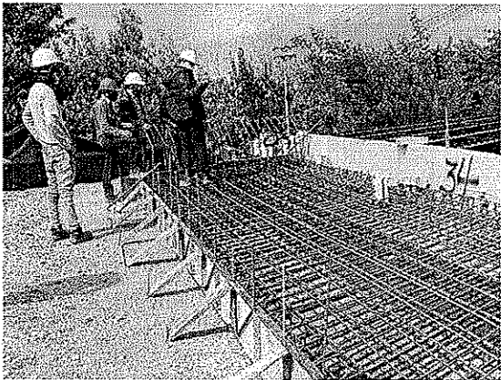
Revisión de recubrimientos acero de refuerzo losa de aproximación
