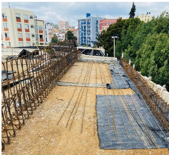
Armado de parrilla de acero para losa ciclovía
