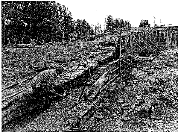
Excavación para realización de bordillo y dentellón
