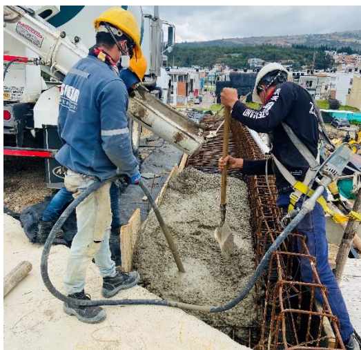
Fundida y nivelación de parte inferior del bordillo sur
