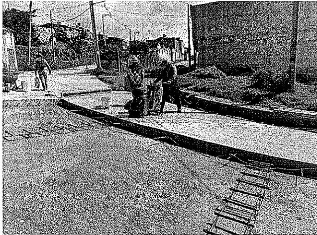
Realización de corte juntas de retracción placa de concreto.
