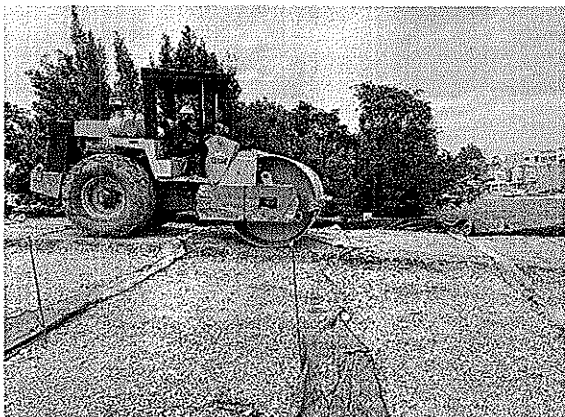
Compactación capa de conformación de losa ciclovía
