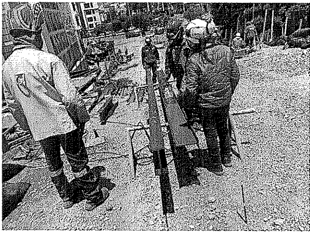
Aplicación de base epóxica de fosfato de cinc y posterior instalación de vigas IPE 200 costado occidental
