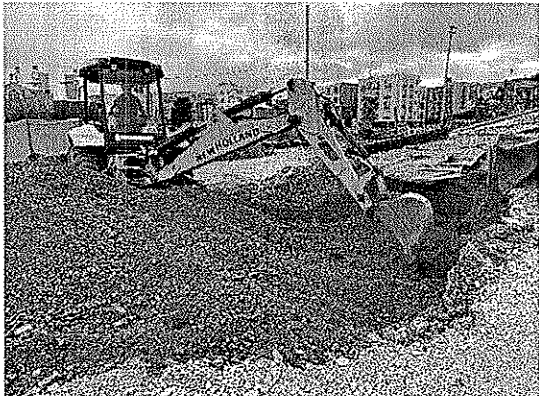
Retiro y excavación mecánica de material de relleno para mejoramiento acceso costado oriental
