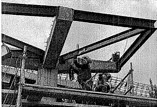
Realización método no destructivo de líquidos penetrantes estructura metálica rampa peatonal costado sur tramo 2
