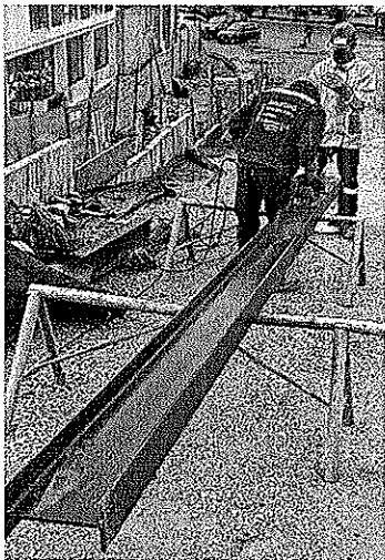
Corte Vigas IP 200 estructura metálica rampa peatonal tramo 3 costado sur occidental
