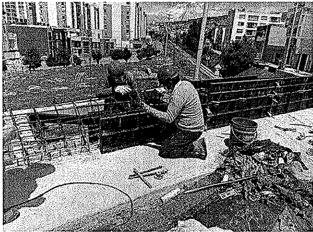
Instalación de formaletas bordillo sur oriental
