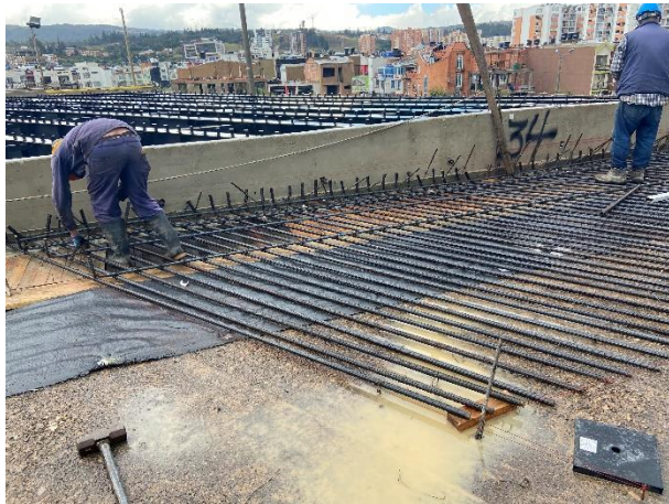
Instalación de parrilla losa de aproximación
