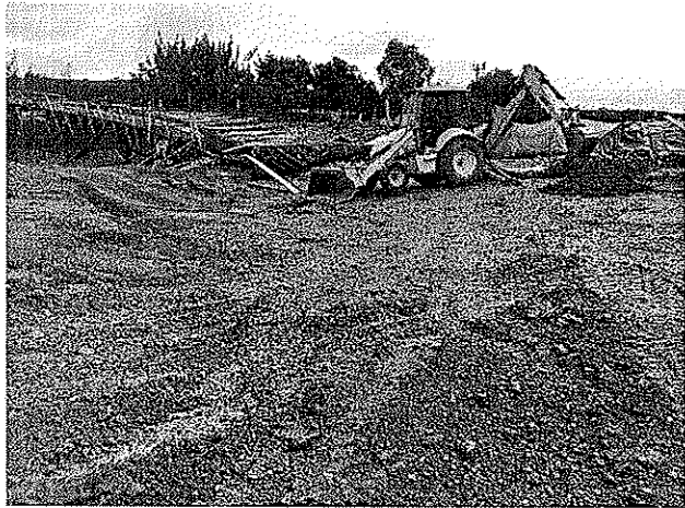
Excavación mecánica para mejoramiento de acceso tierra armada costado oriental
