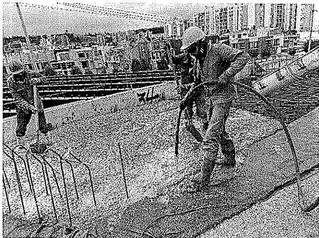
Fundida y nivelación de losa de aproximación costado occidental
