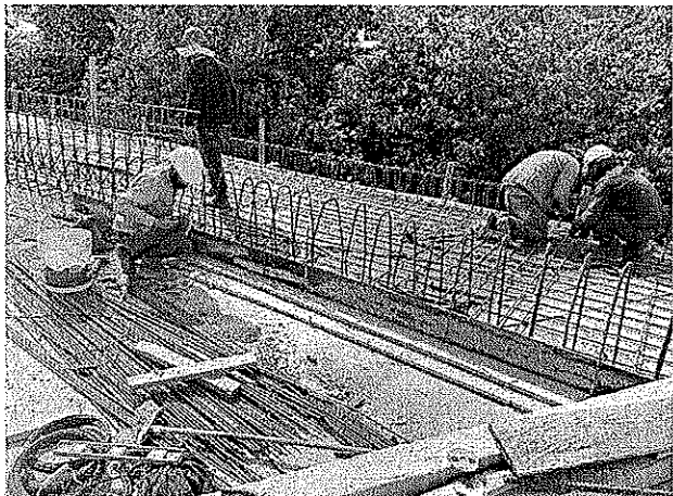
Instalación de parrilla de acero de refuerzo losa ciclovía costado noroccidental
