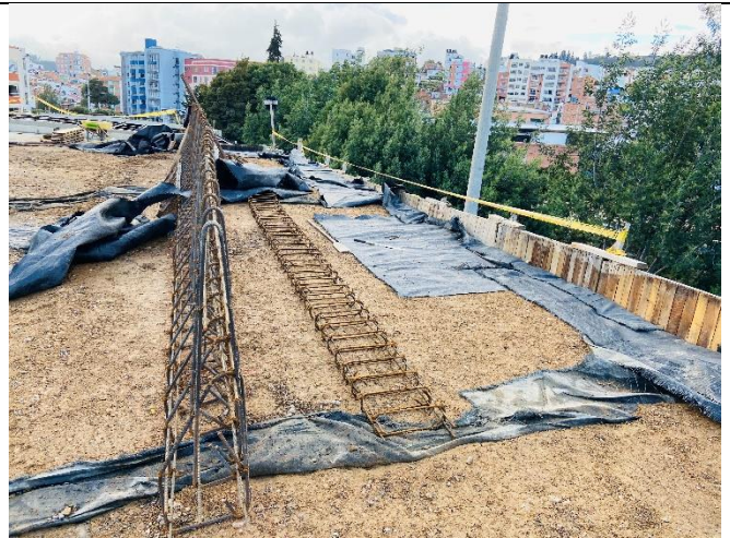
Ubicación de acero de refuerzo para New Jersey
