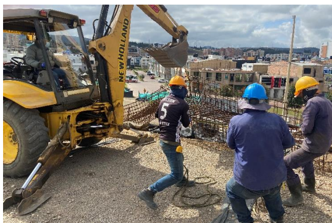
Retiro de parrilla de refuerzo correspondiente al bordillo sur
