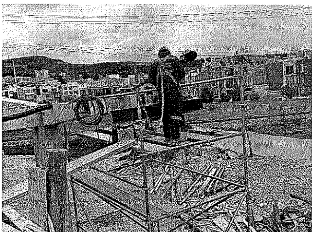
Izaje y montaje de viga IP 200 estructura metálica rampa peatonal tramo 2 costado occidental
