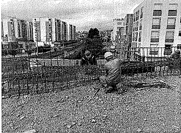
Armado para acero de refuerzo bordillo sur costado occidental
