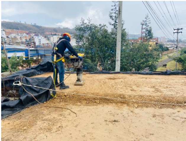
Compactación de relleno para conformación de capa de la ciclovía
