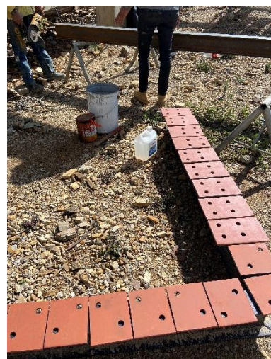
Pintura definitiva platinas para instalación de arriostramiento con base epóxica de fosfato de Cinc
