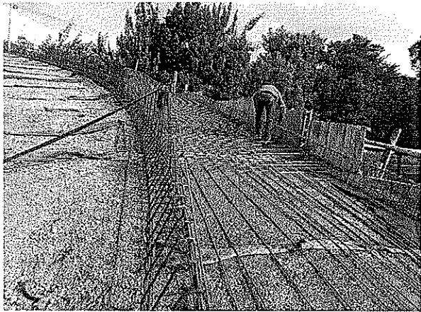
Instalación de parrilla de acero losa ciclovía costado oriental
