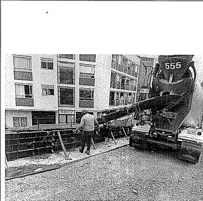
Fundición de parte superior del bordillo sur oriental
