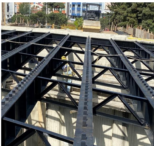
Instalación de pines para asegurar pasadores en estructura metálica
