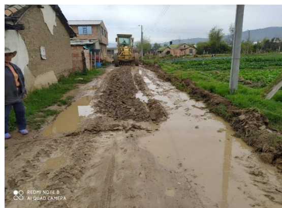
Figura 30. Alineamiento y nivelación con extensión de material granular (recebo)
