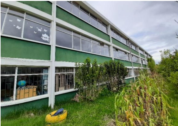
Figura 36. Toma de cantidades obra muros externos y ventanas con perfiles en acero
