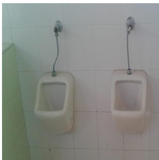
Figura 7. Desmonte e Instalación Orinales
