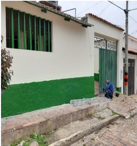
Figura 4. Resanado y pintura muros exteriores
