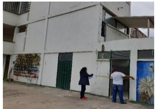
Figura 37. Toma de cantidades obra muros externos y ventanas con perfiles en acero
