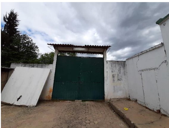
Figura 38. Toma de cantidades obra muros externos y puerta en acero
