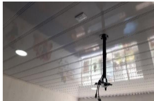
Figura 18. Instalación Paneles led 18 W
