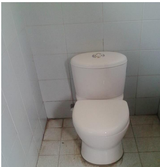
Figura 6. Desmonte e Instalación de Sanitario
