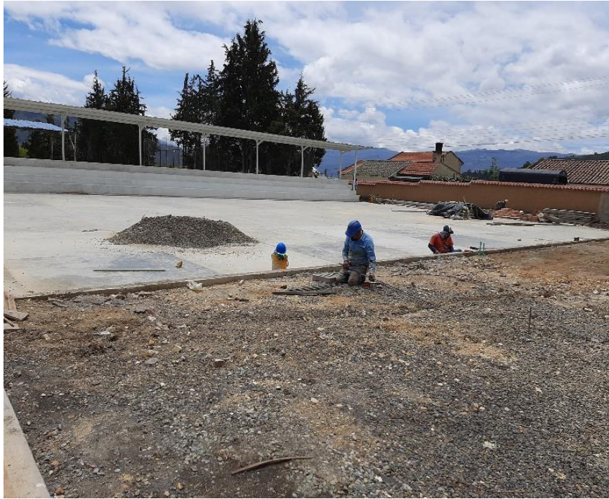
Figura 10. Placas en concreto para canchas múltiples
