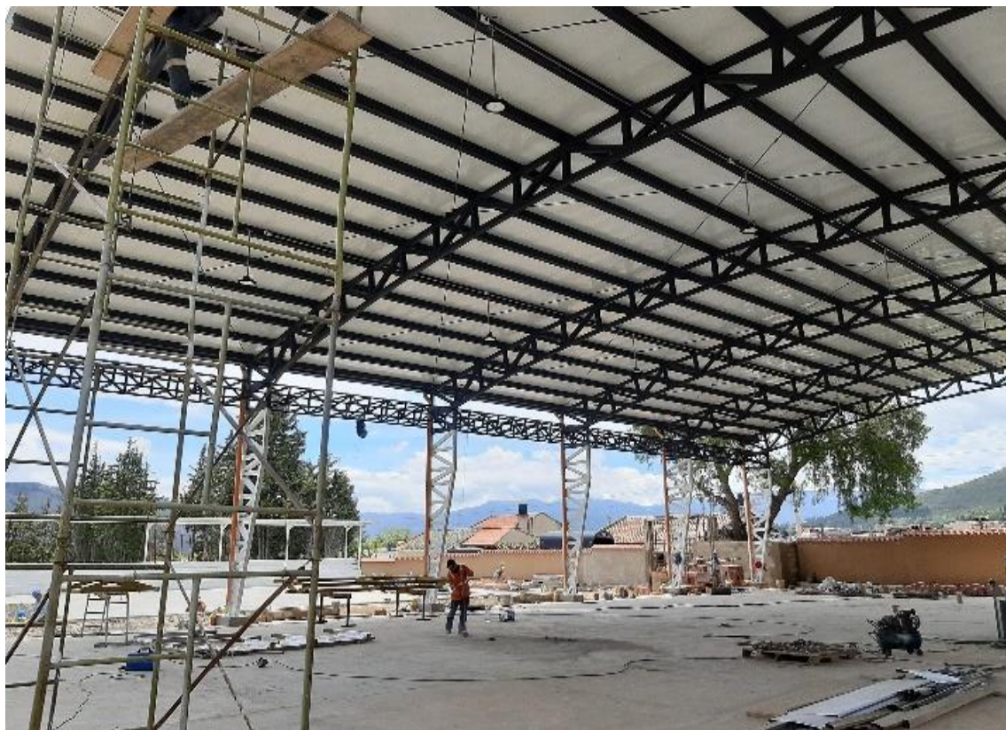
Figura 8. Cubierta Canchas Múltiples
