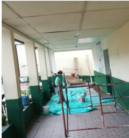
Figura 5. Resanado y pintura muros interiores
