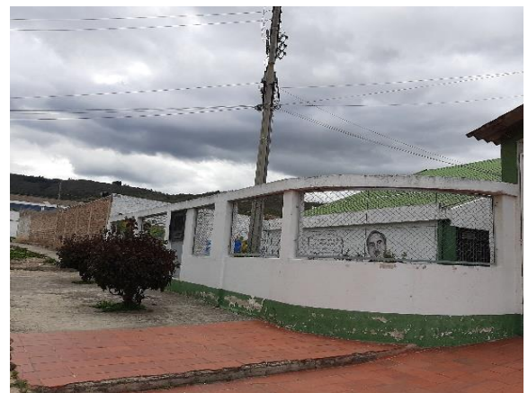
Figura 39. Toma de cantidades obra muros externos y rejas con perfiles en acero
