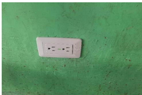
Figura 19. Instalación toma doble Autor
