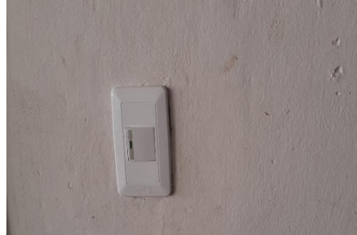
Figura 20. Instalación Iluminación tomas
