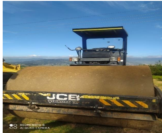
Figura 41. Registro fotográfico vibro compactador
