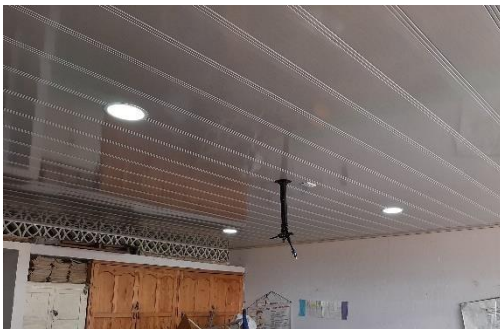
Figura 17. Instalación estructura PVC
