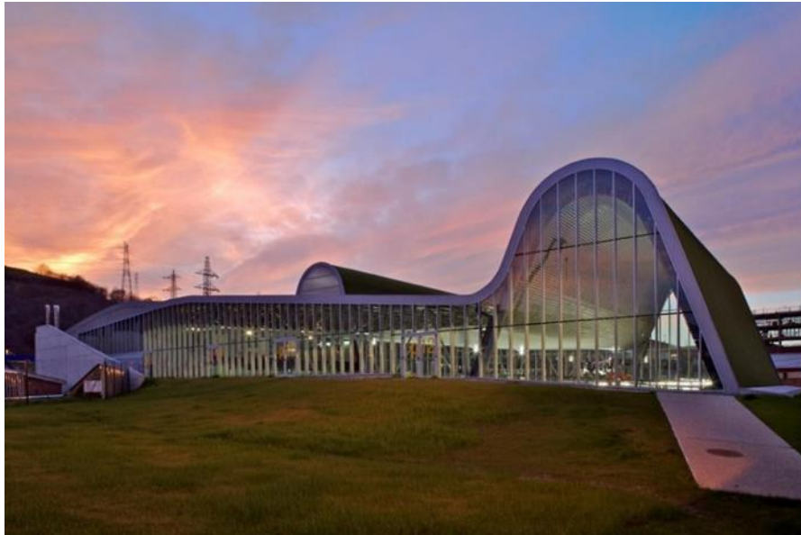
Figura 5. Vista Frontal Centro Deportivo y de Ocio
