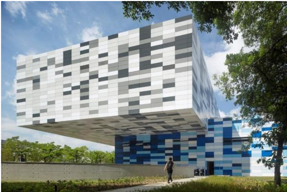
Figura 14. Exterior Centro Deportivo Tucheng
