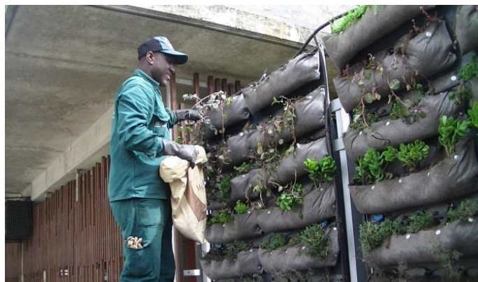
[Figura 7] - Implementación del sistema de riego, 10 de junio de 2016 – Fuente propia.
