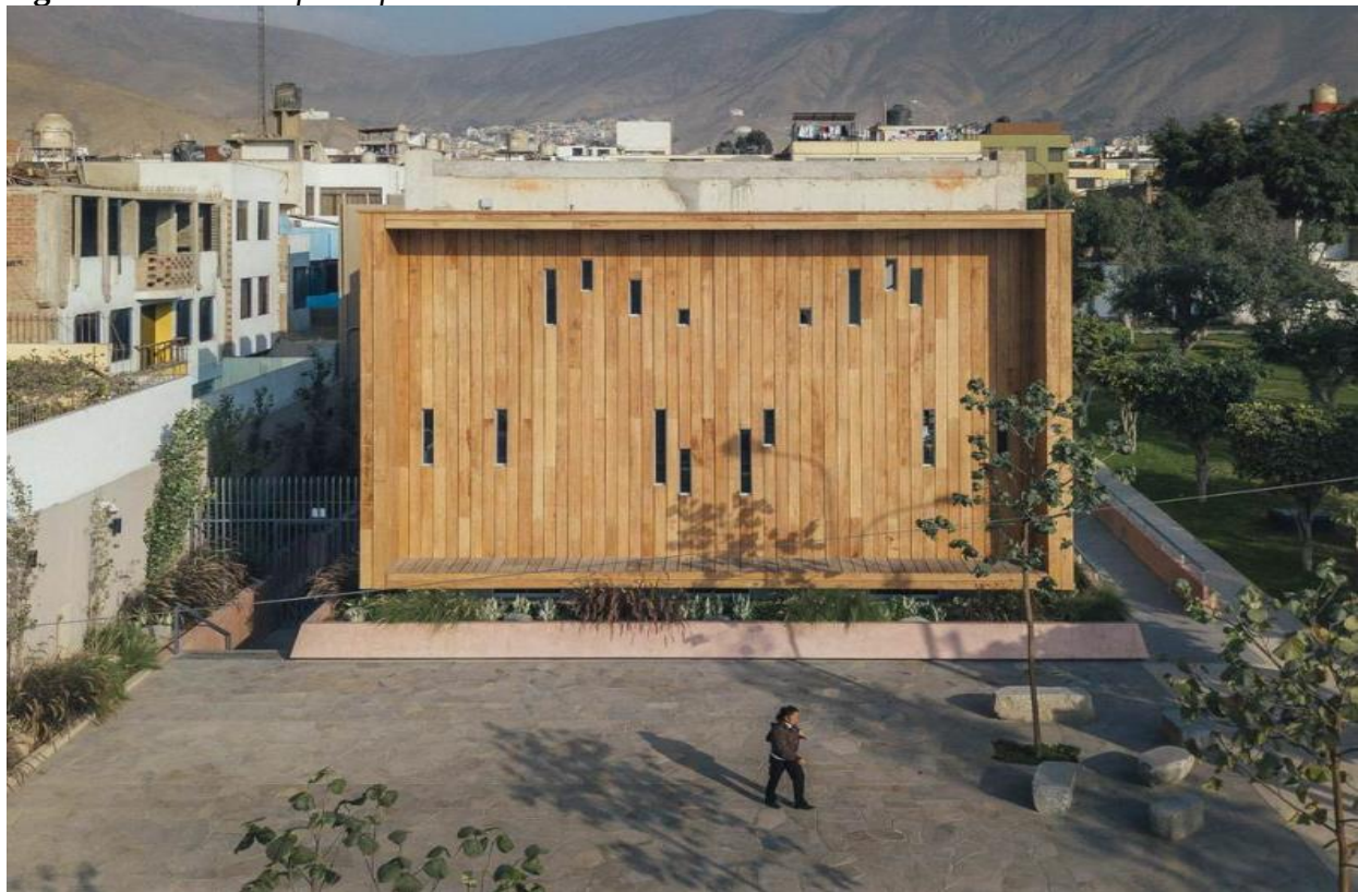
Figura 31. Fachada principal biblioteca comunitaria
