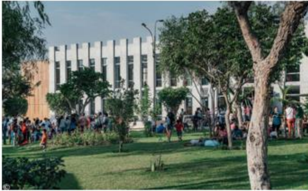
Figura 33. Fachadas – entrada principal
