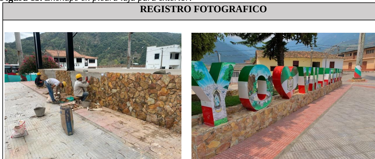
Figura 15. Enchape en piedra laja para exterior.
