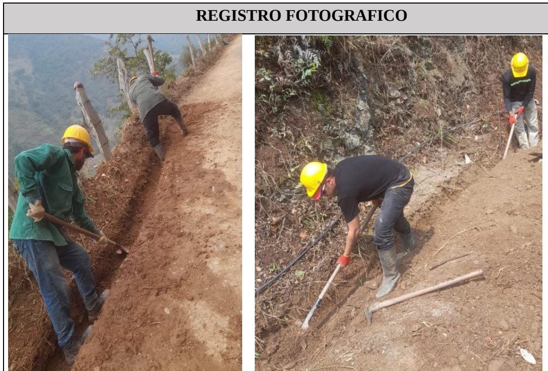
Figura 27. Excavación manual.
