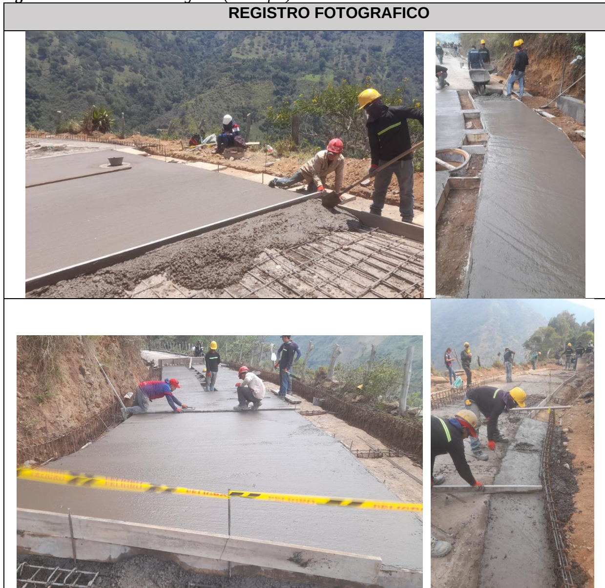
Figura 35. concreto de 210 kg/cm 2 (3.000 psi).
