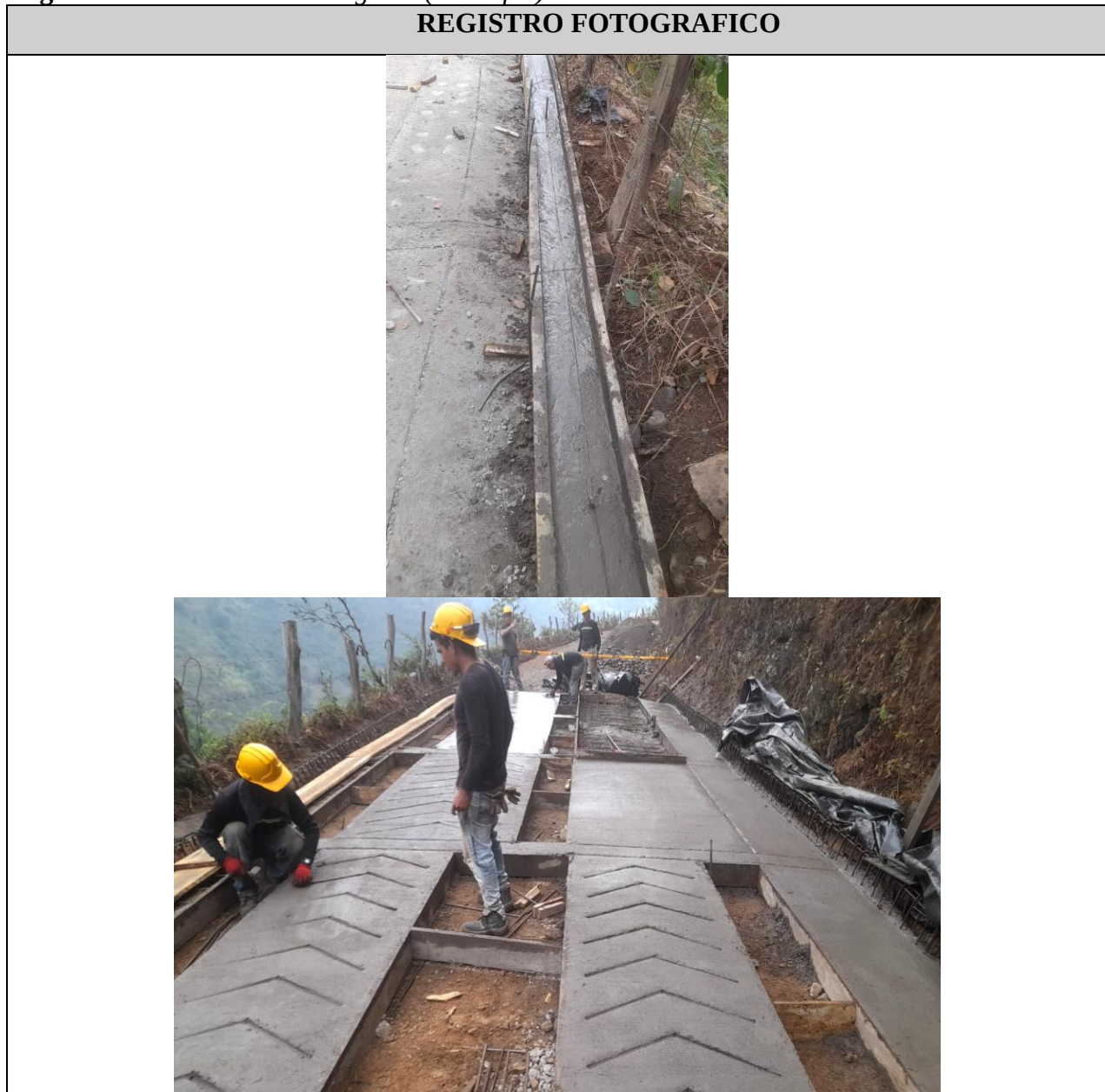
Figura 30. Concreto de 210 kg/cm 2 (3.000 psi).
