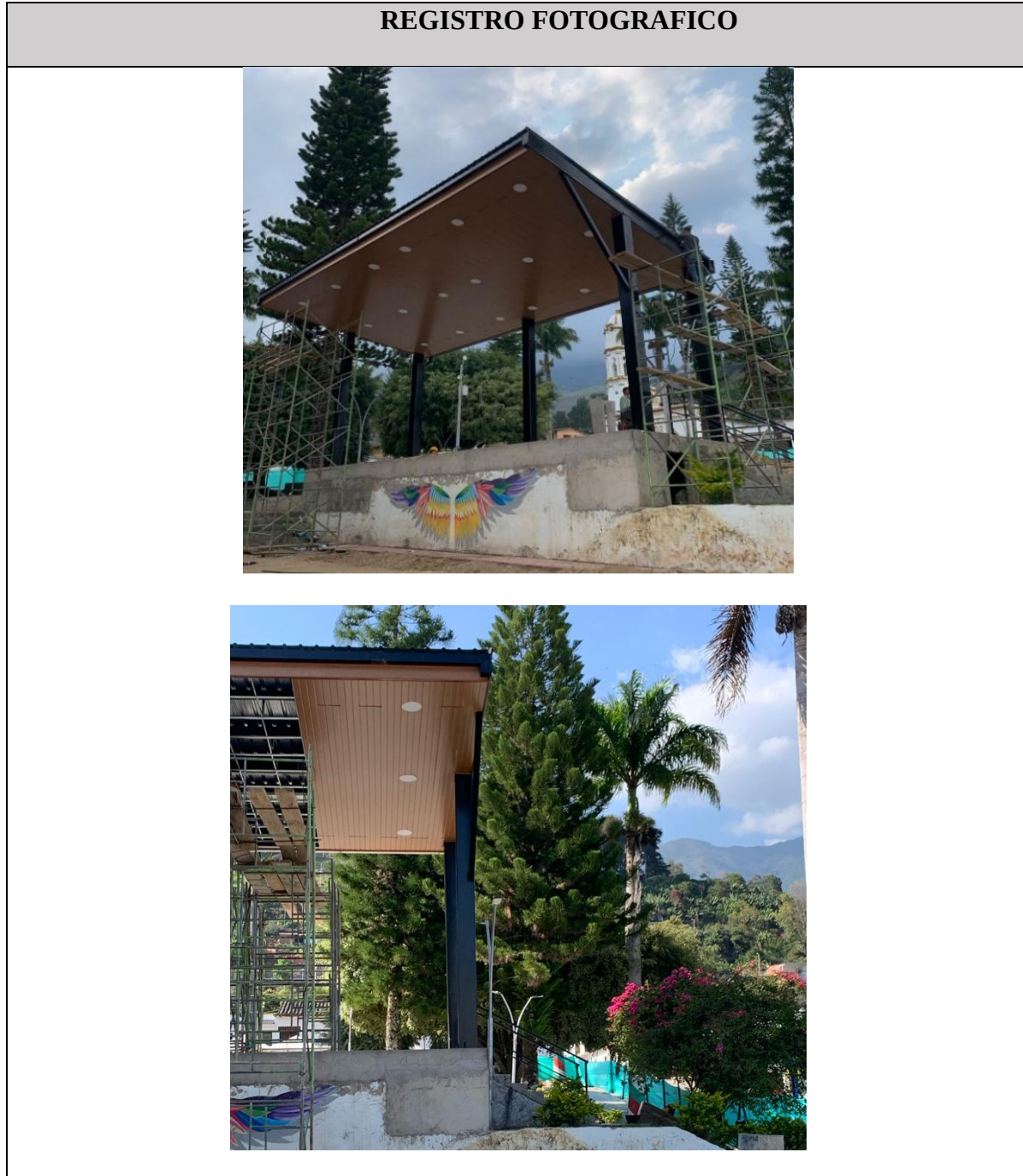
Figura 9. Cielo raso en PVC tipo madera: se instaló cielo raso en PVC tipo madera en la tarima.
