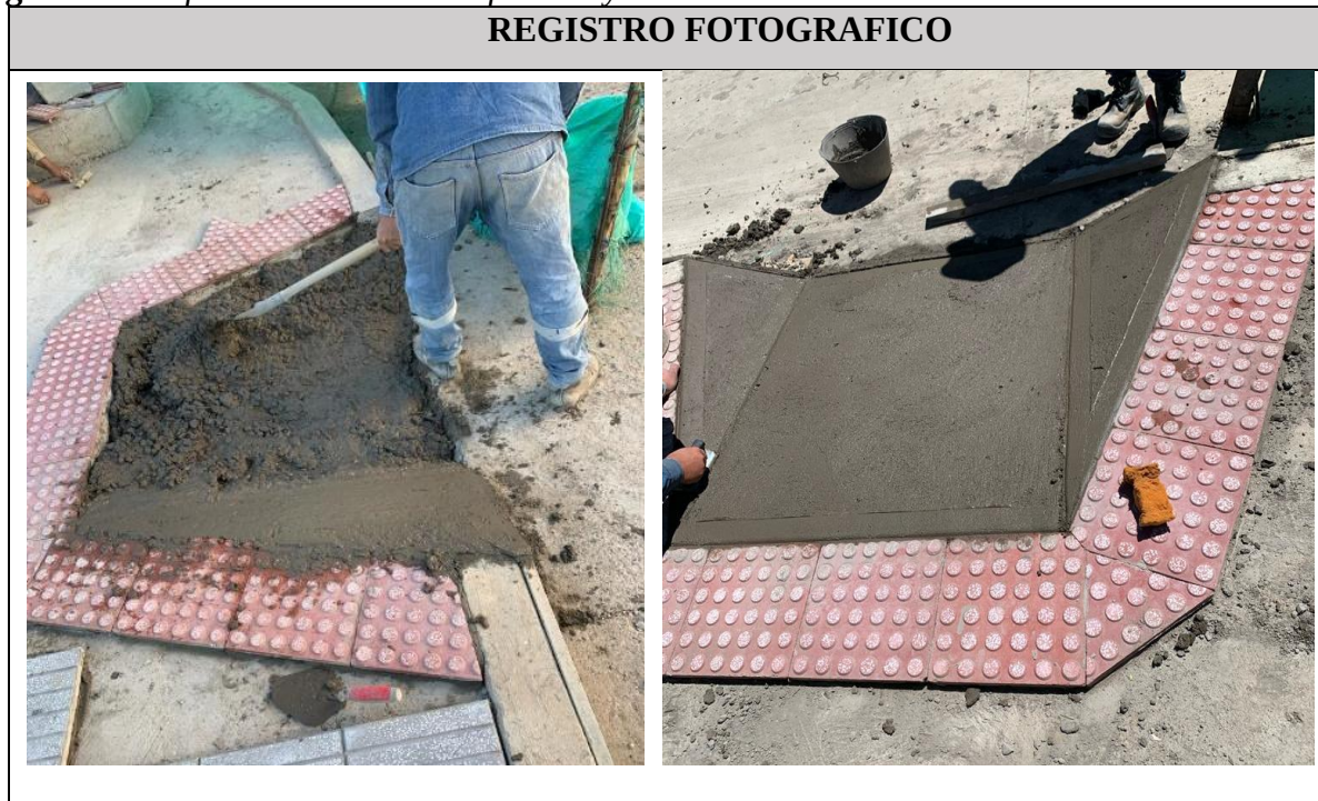
Figura 8. Rampas en Concreto 21mpa incluye Malla Electrosoldada.
