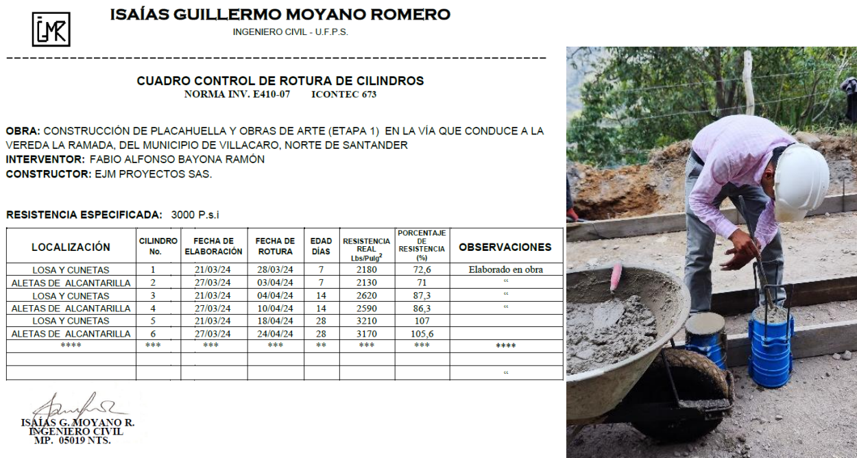
Figura 23. Control de ensayo de concreto.
