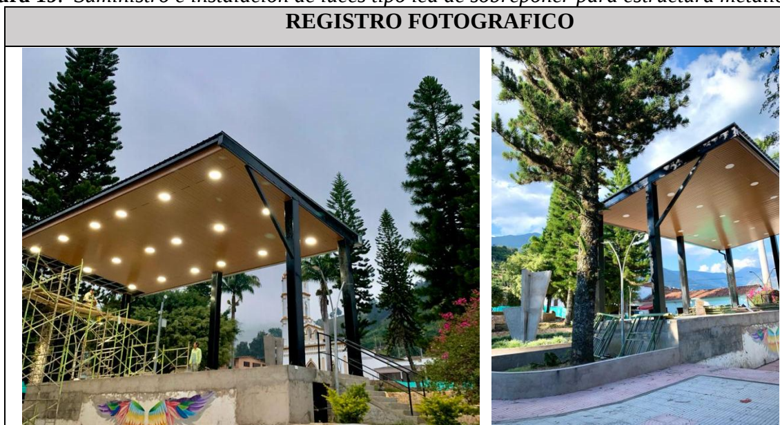
Figura 19. Suministro e instalación de luces tipo led de sobreponer para estructura metálica.
