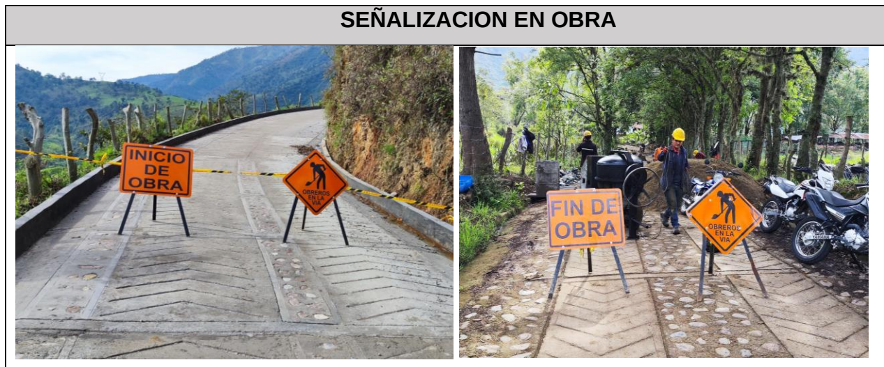
Figura 36. Señalización preventiva en la obra.
