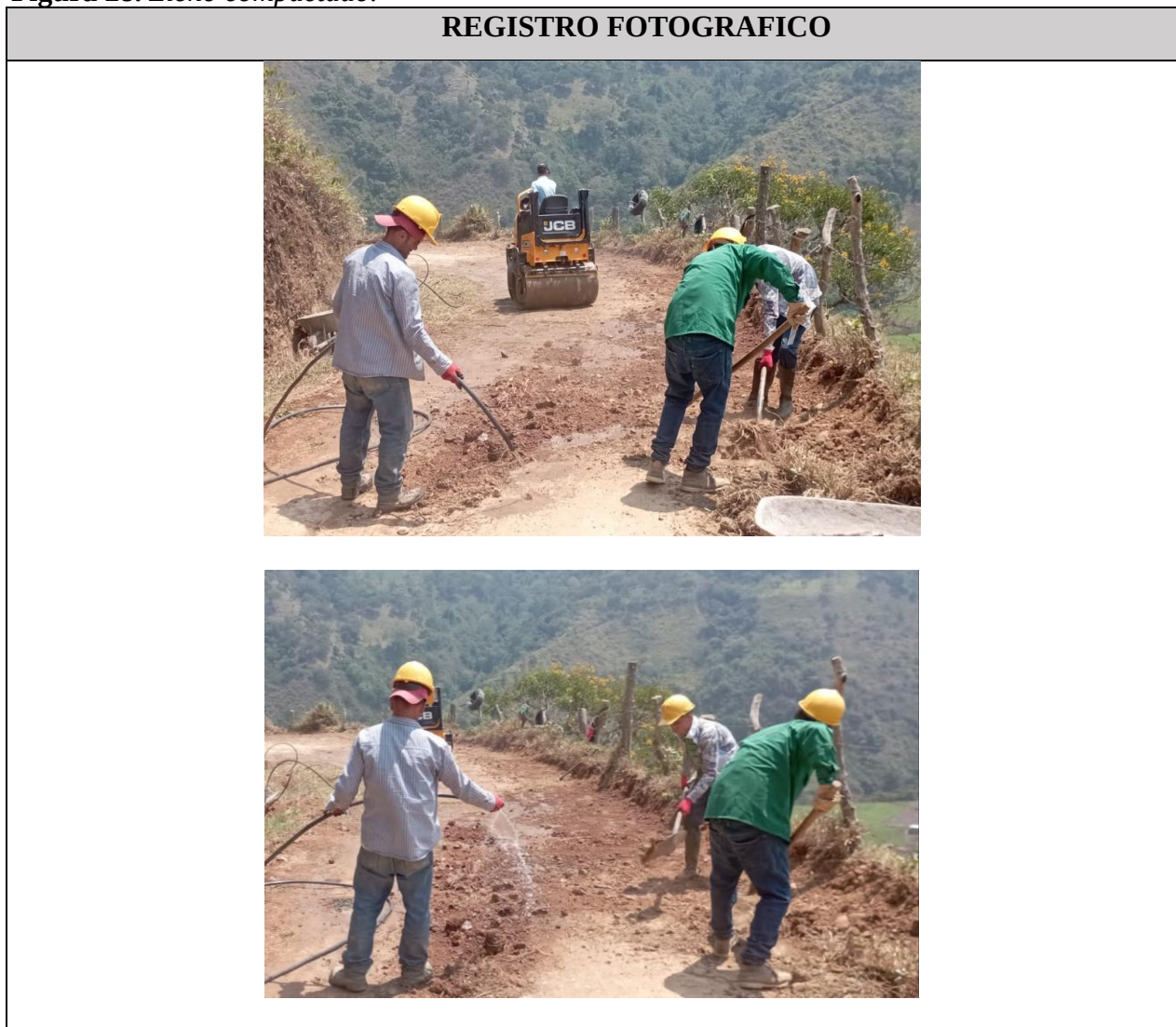
Figura 28. Lleno compactado.
