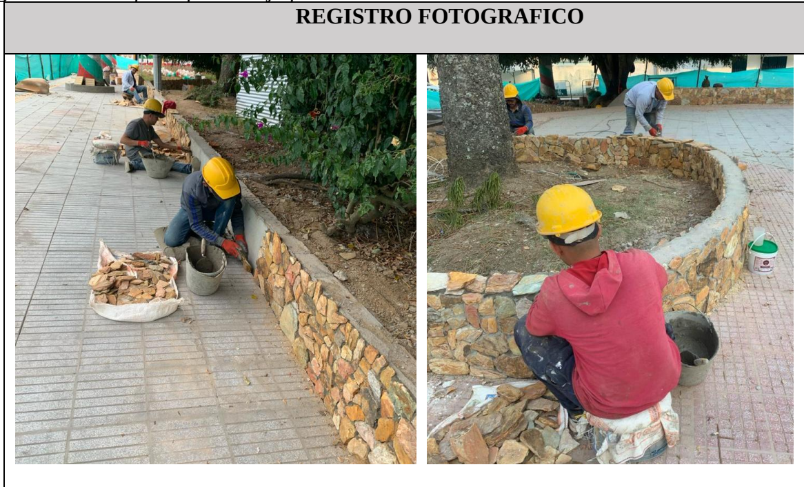
Figura 12. Enchape en piedra laja para exterior.
