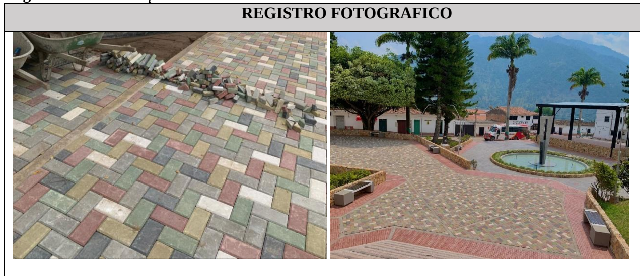
Figura 16. Piso adoquín área de circulación.
