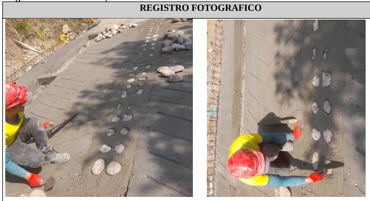
Figura 31. Concreto ciclópeo.
