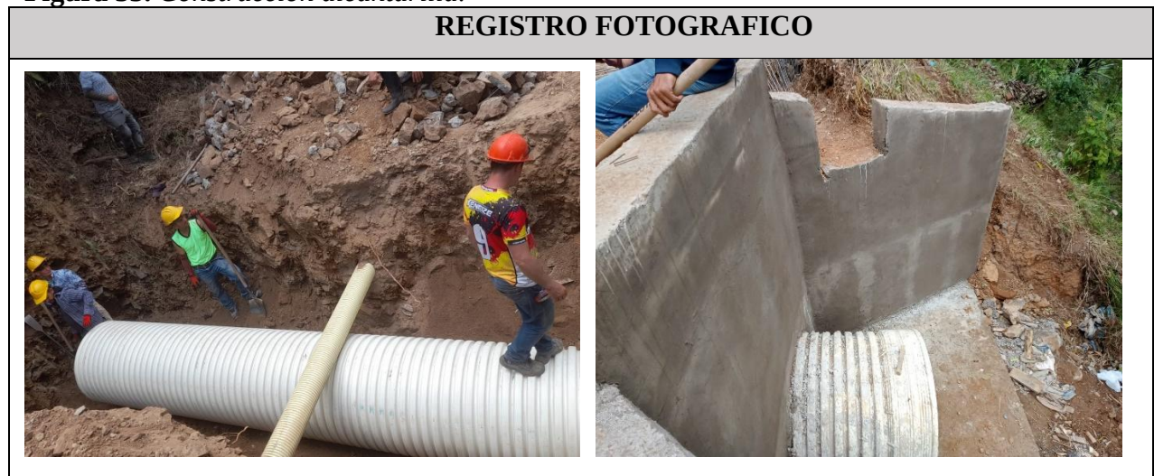
Figura 33. Construcción alcantarilla.
