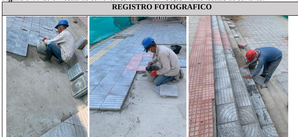
Figura 14. Piso en loseta de cemento: se instalaron 450,65 m 2 de losetas de cemento.
