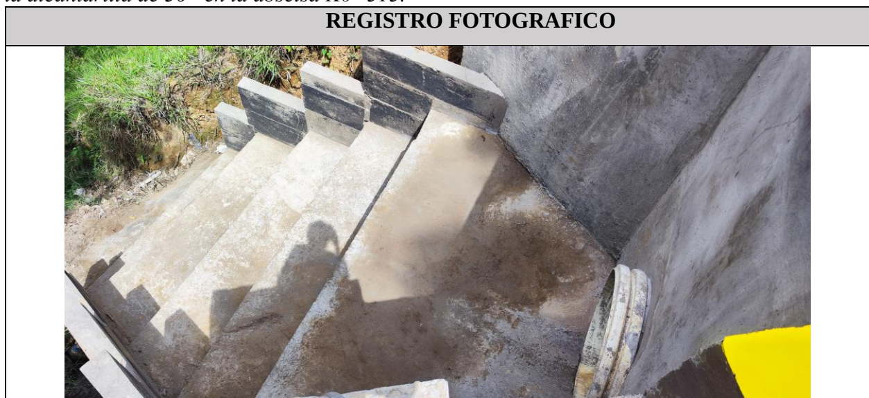
Figura 34. Construcción Disipadores: se realizó la construcción de disipadores en la salida de la alcantarilla de 36" en la abscisa K0+313.
