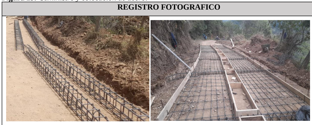
Figura 29. Suministro y colocación de acero.
