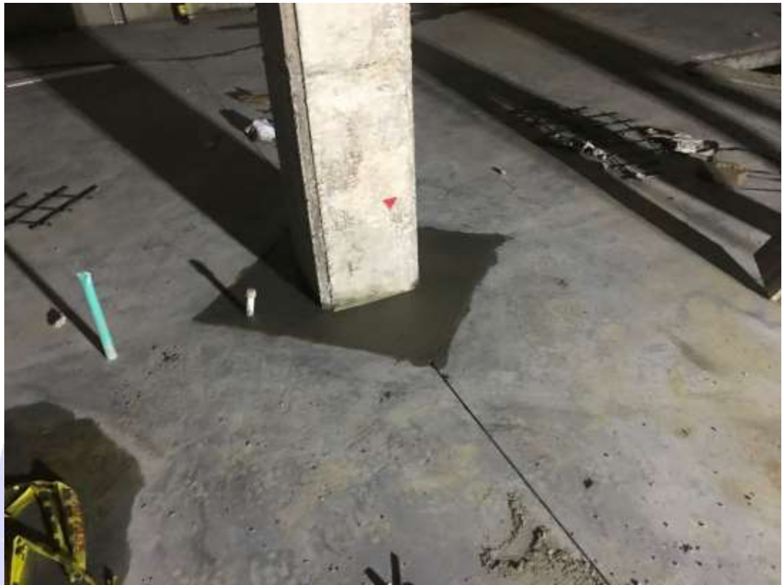
Ilustración 8. Corte de juntas de dilatación
