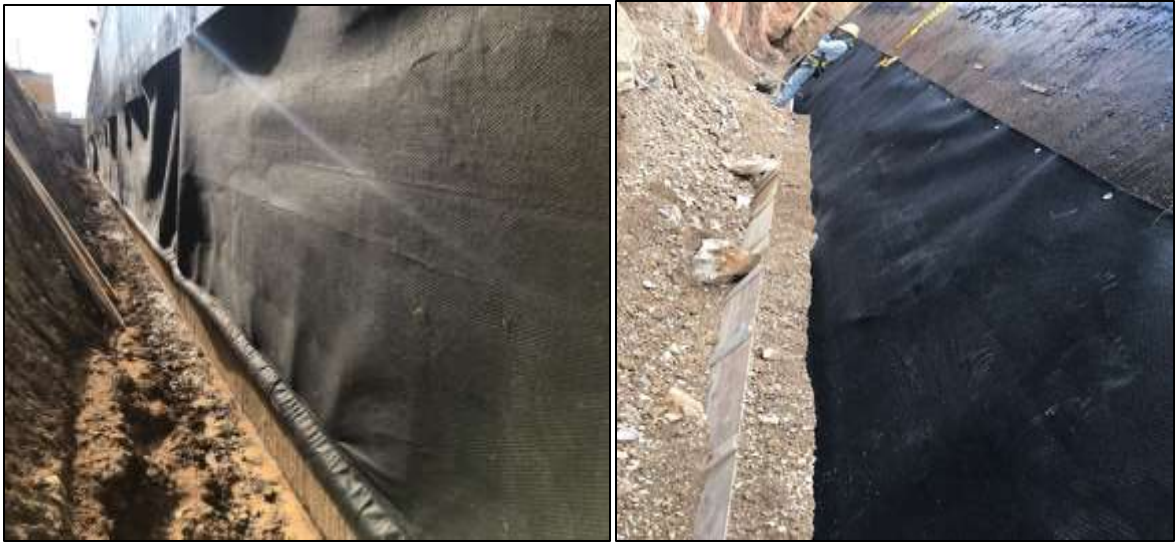
Ilustración 10. Instalación de filtro Geodren Vial y relleno de material
