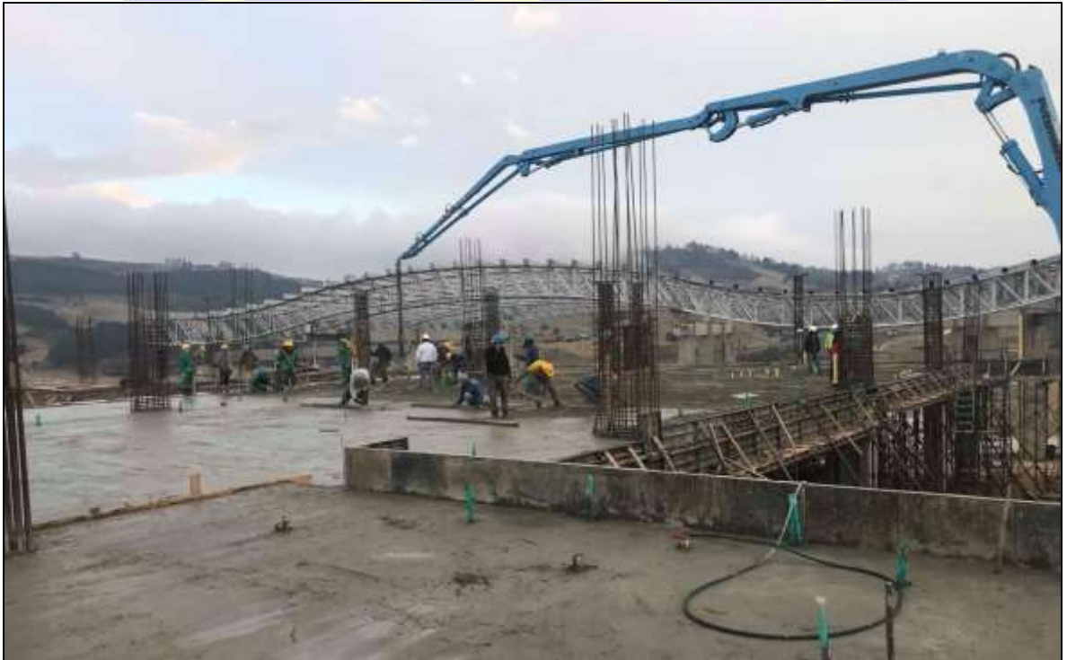
Ilustración 6. Fundida de placa de entrepiso bloque 2.
