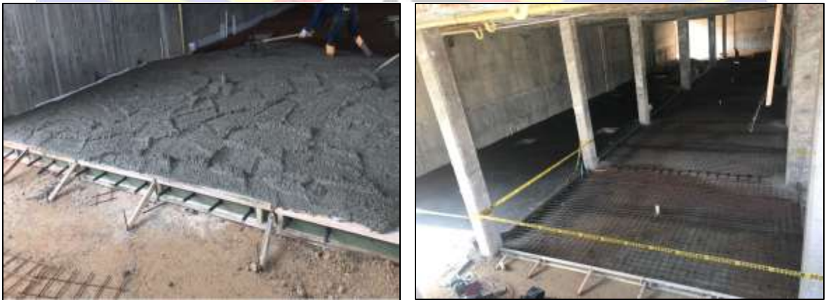
Ilustración 7. Proceso constructivo placa de contrapiso
