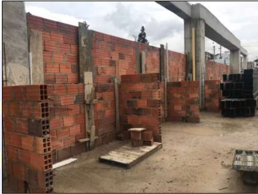
Ilustración 15. Construcción de muros y columnetas en mampostería confinada
