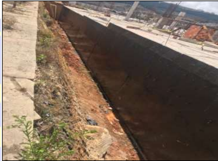
Ilustración 9. Instalación de filtro Igol denso Plus
