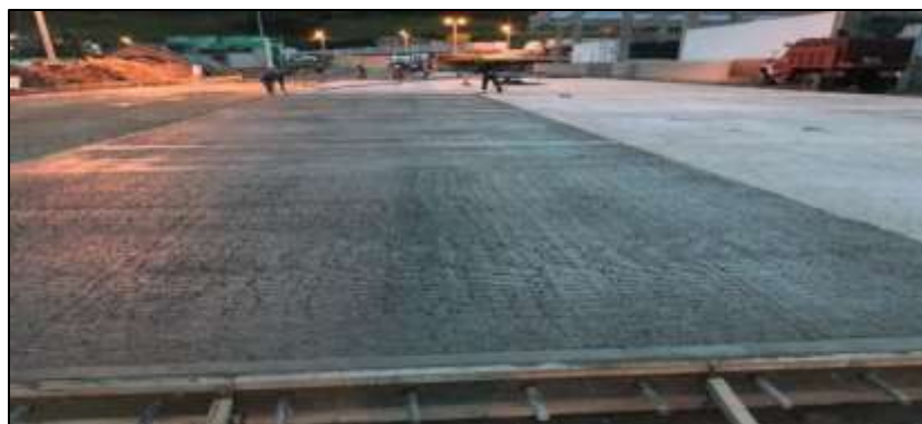
Ilustración 14. Acabado final losas de pavimento rígido
