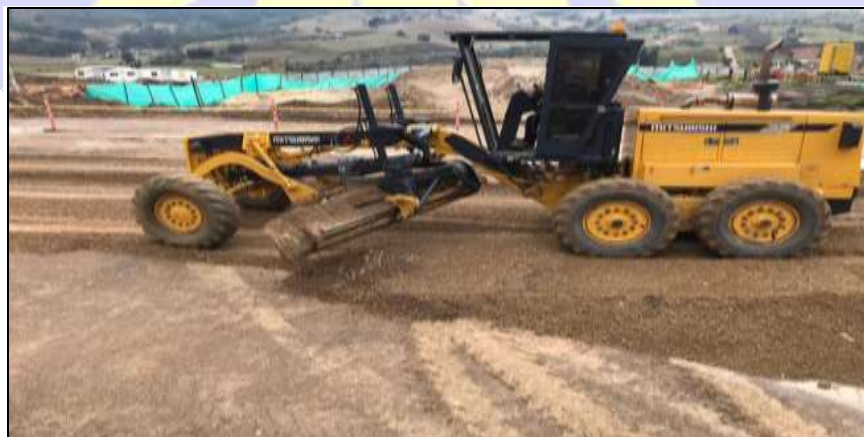
Ilustración 11. Motoniveladora en operación
