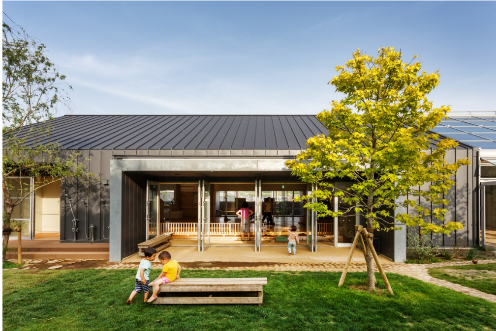
Figura 34. Espacio Exterior. Adaptado de archdaily
