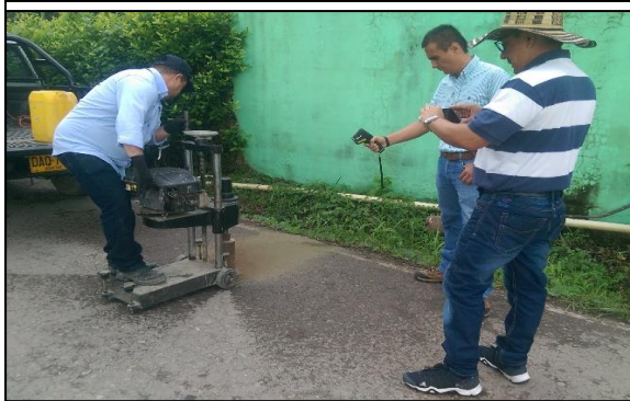
Fotografía 8 Toma de registro fotográfico del equipo de corte para la extracción de núcleos. Foto tomada por los autores del estudio.
