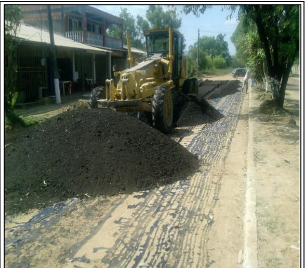
Fotografía 2 Con la motoniveladora. Fuente: Propia
