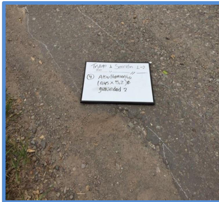
Fotografía 21 Falla 8: Abultamiento. Foto tomada por los autores del estudio.
