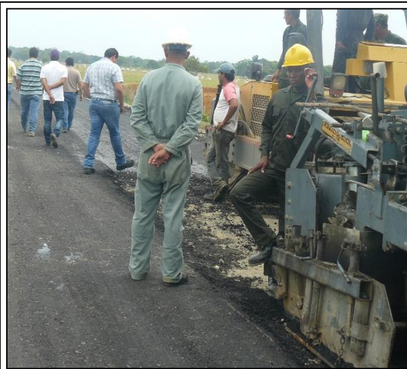
Fotografía 1 Con Finisher o terminadora de pavimentos. Fuente: Propia
