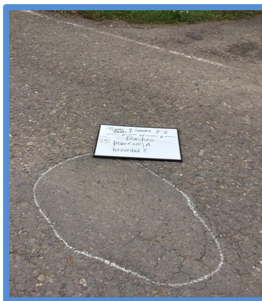
Fotografía 31 Falla 18: Parche. Foto tomada por los autores del estudio.
