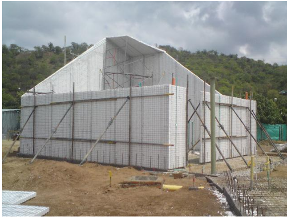
Fig. 53. Proceso Constructivo Jardin Infantil Timayu, Santa Marta 2010
