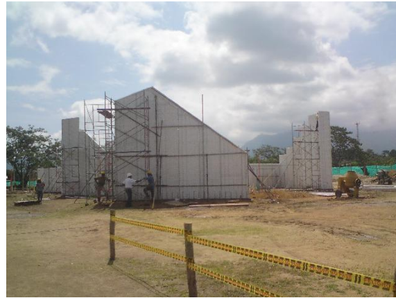
Fig. 54. Proceso Constructivo Jardin Infantil Timayu, Santa Marta 2010
