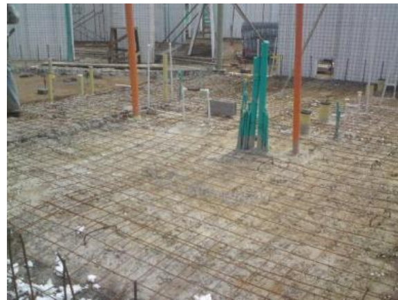
Fig. 52. Proceso Constructivo Jardín Infantil Timayu, Santa Marta 2010
