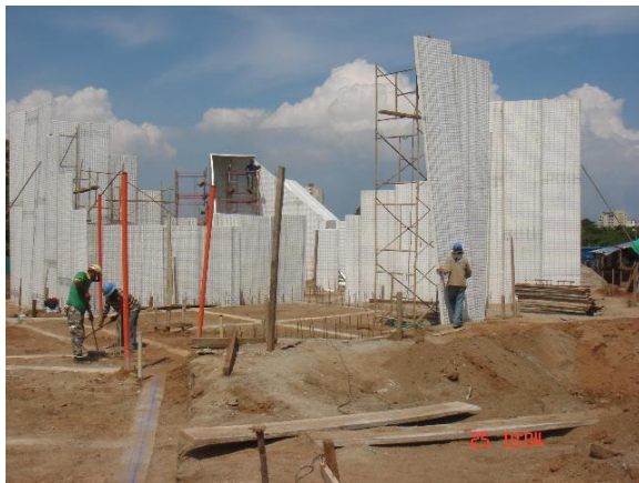
Fig. 51. Proceso Constructivo Jardín Infantil Timayu, Santa Marta 2010
