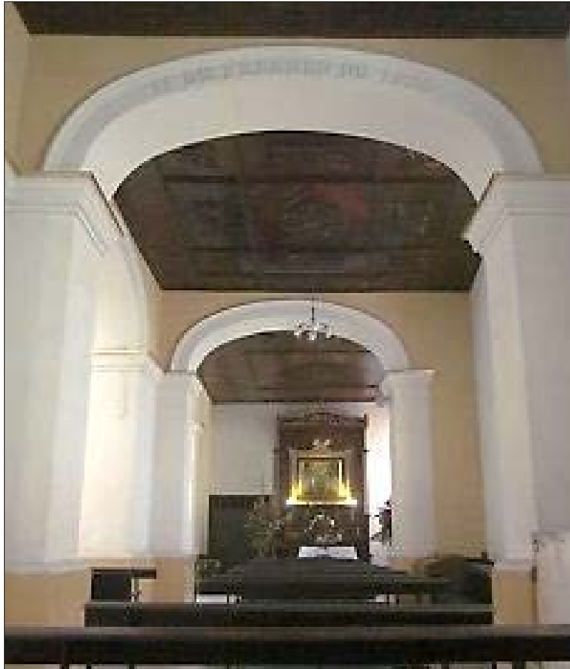
Figura 51. Arco Carpanel y Ojival respectivamente.
