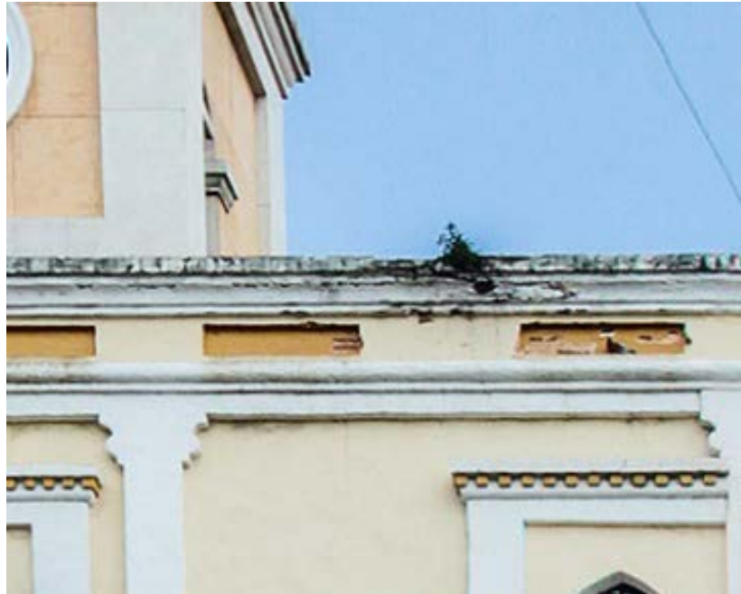
F6. Ennegrecimiento, vegetación superior, decoloración o mancha.
