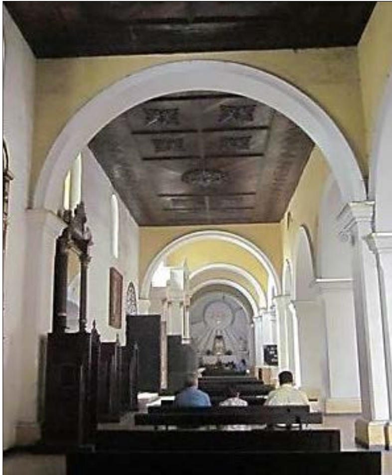
Figura 50. Arco de medio punto; Rebajado respectivamente.
