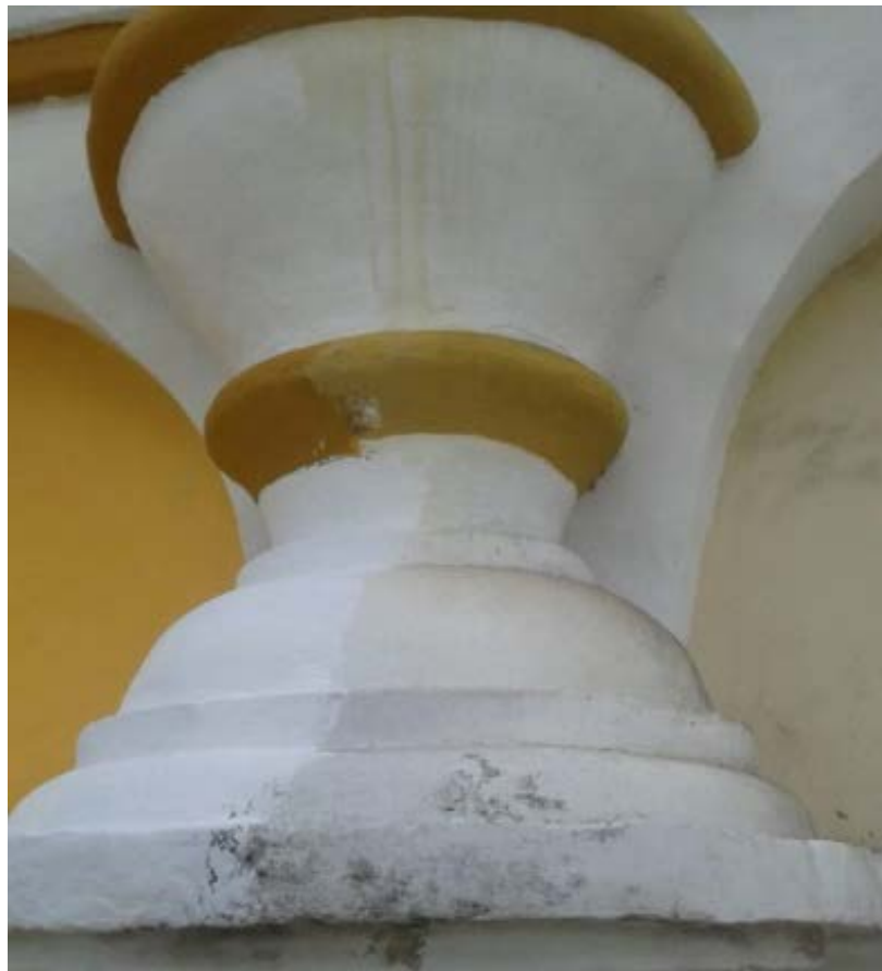
F5. Ensuciamiento, ennegrecimiento, costra desprendida, desconchado, intervenciones impropias, decoloración o mancha, lavados.
