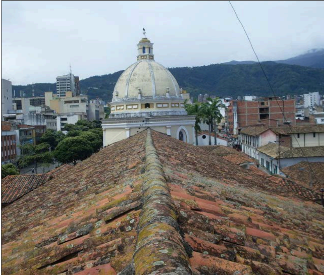
Fotografía 3. Cubierta a dos aguas, nave central
