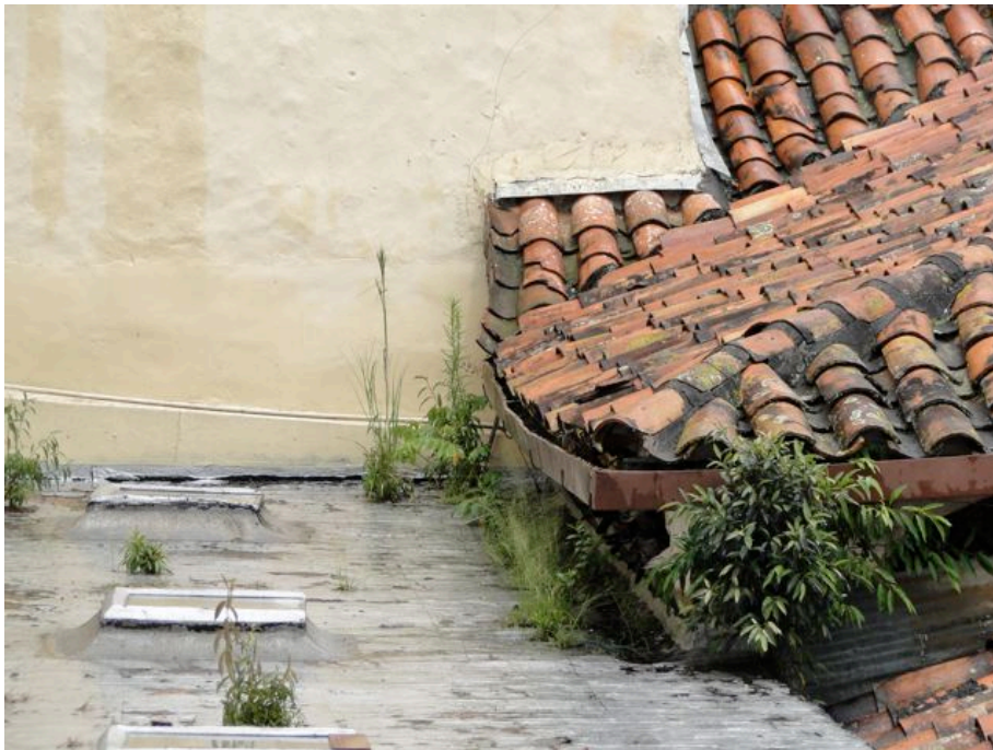
F6. Vegetación superior, ennegrecimiento, decoloración o mancha, lavado
