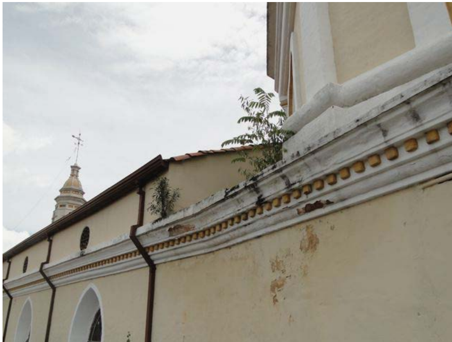
F10. Vegetación superior, ensuciamiento, ennegrecimiento, costras desprendidas, decoloración o mancha.
