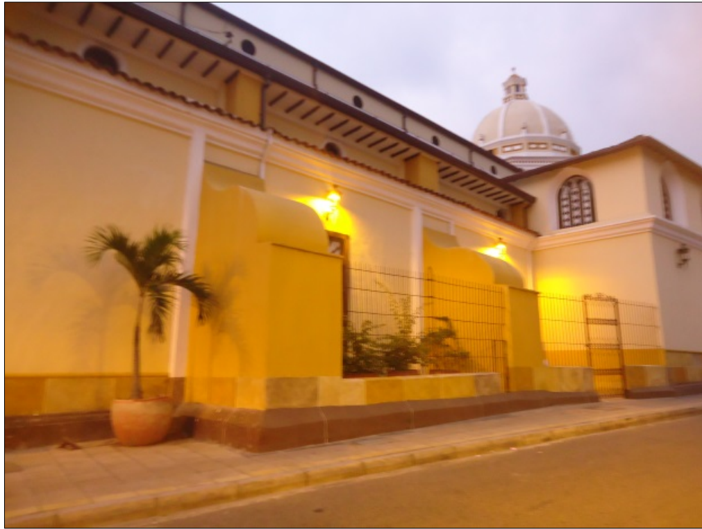
Figura 31. Refuerzo al paredón, estribos en el año 2014
