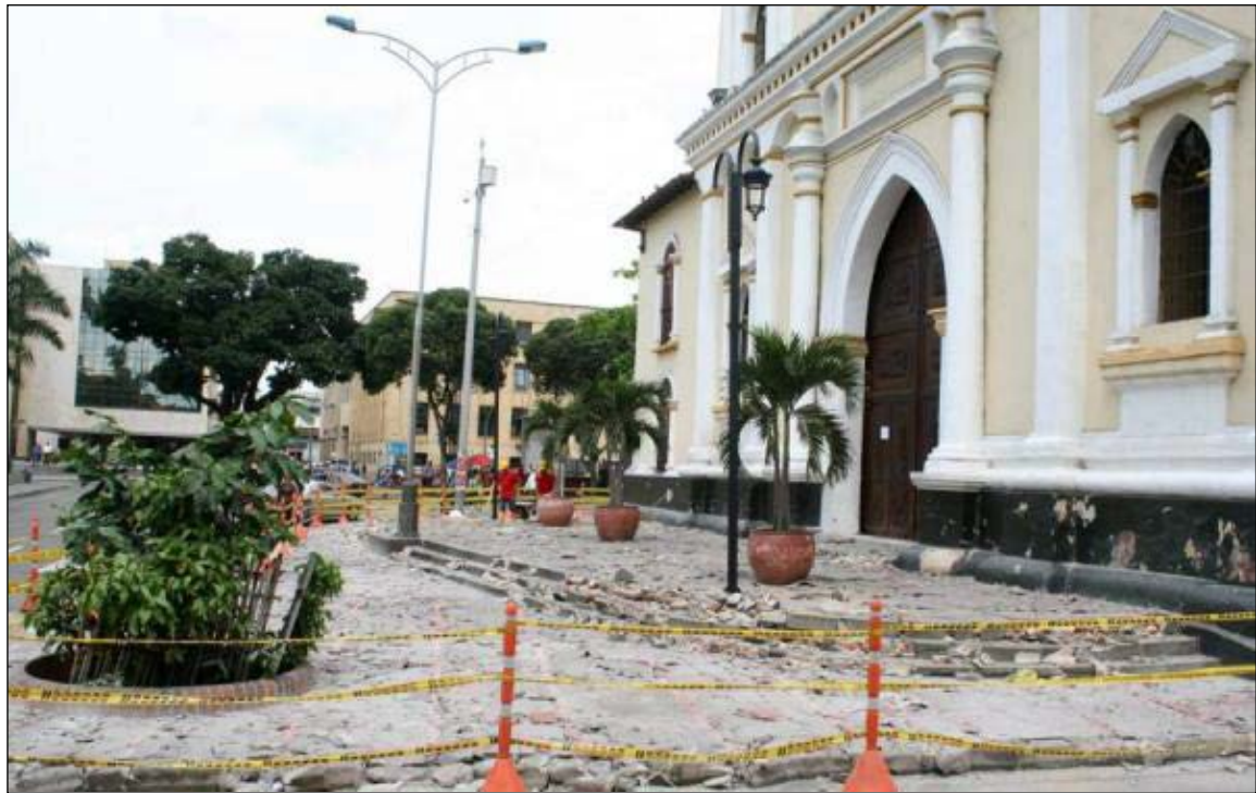
Figura 36. Atrio de San Laureano en obra.
