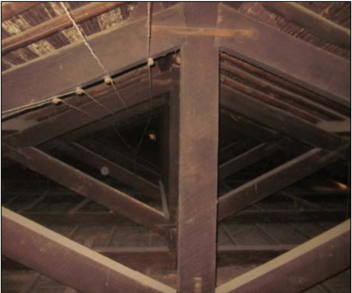
Figura 52. Vista de la estructura de cubierta del edificio. Año 2013.
