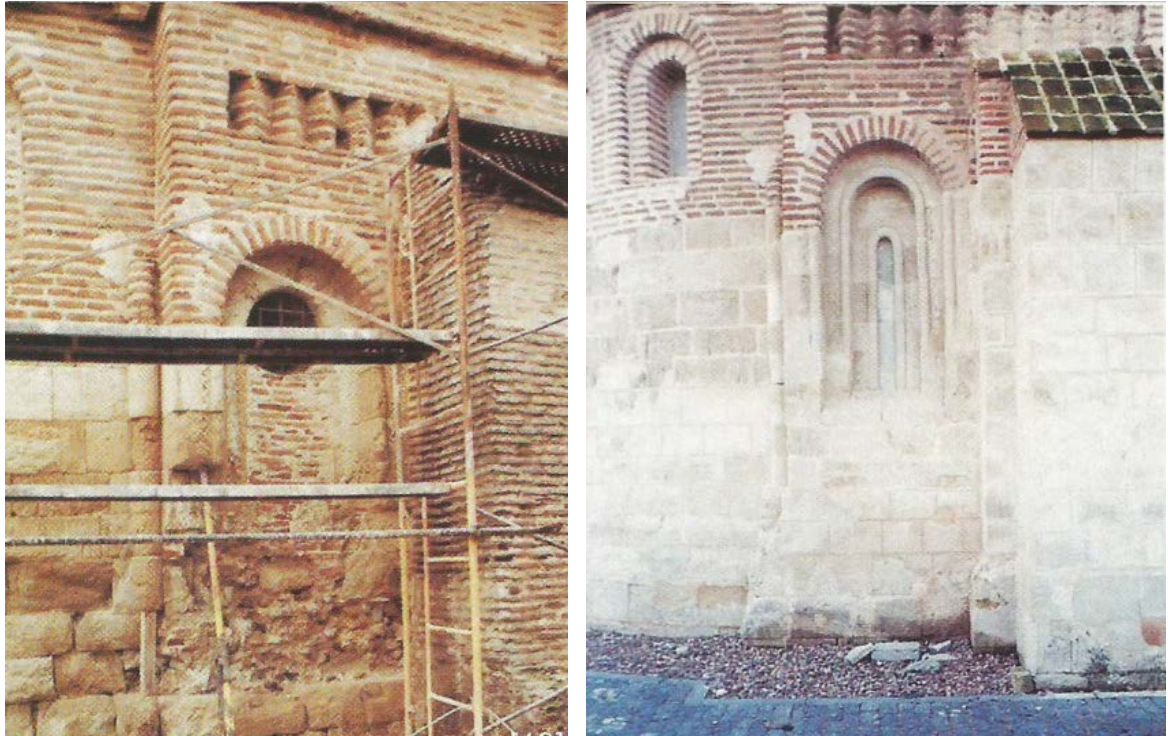
Figura 69. Proceso de restauración de la ventana del ábside del Evangelio.
