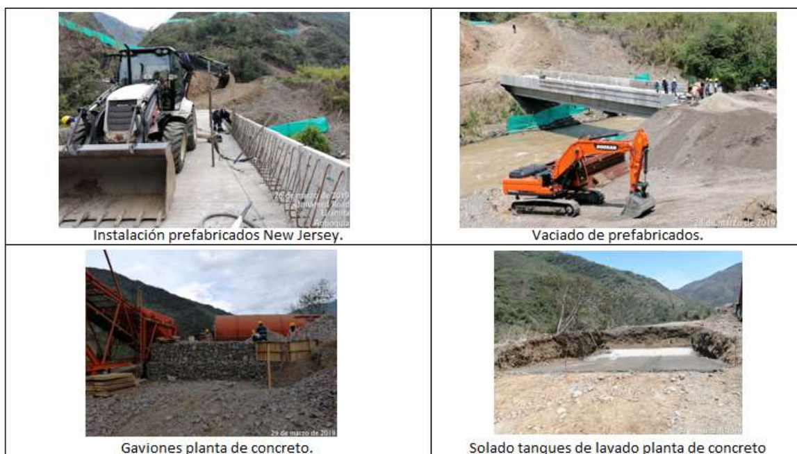
Figura 10. Actividades en planta de concreto y Puente Provisional N°4
