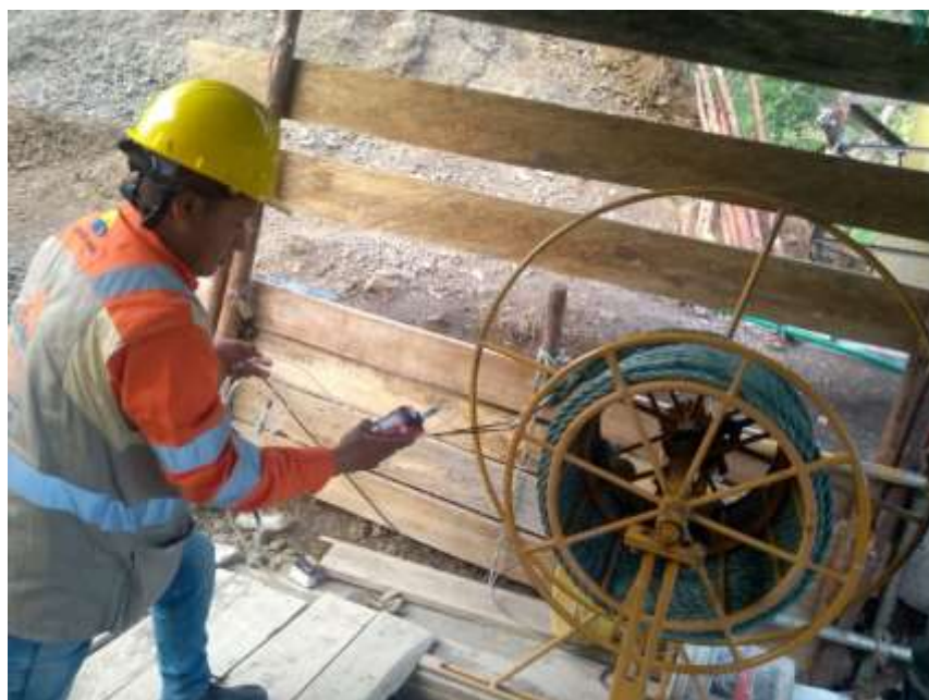
Figura 38. Medición de gases.
