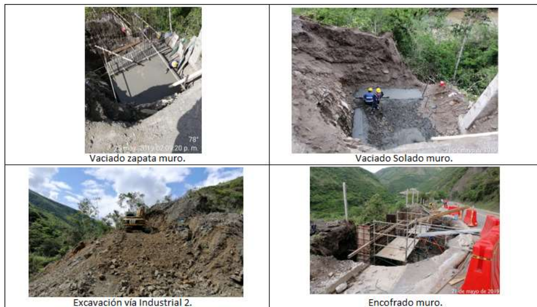
Figura 18. Registro de actividades realizadas en vía Fuente: Autora
