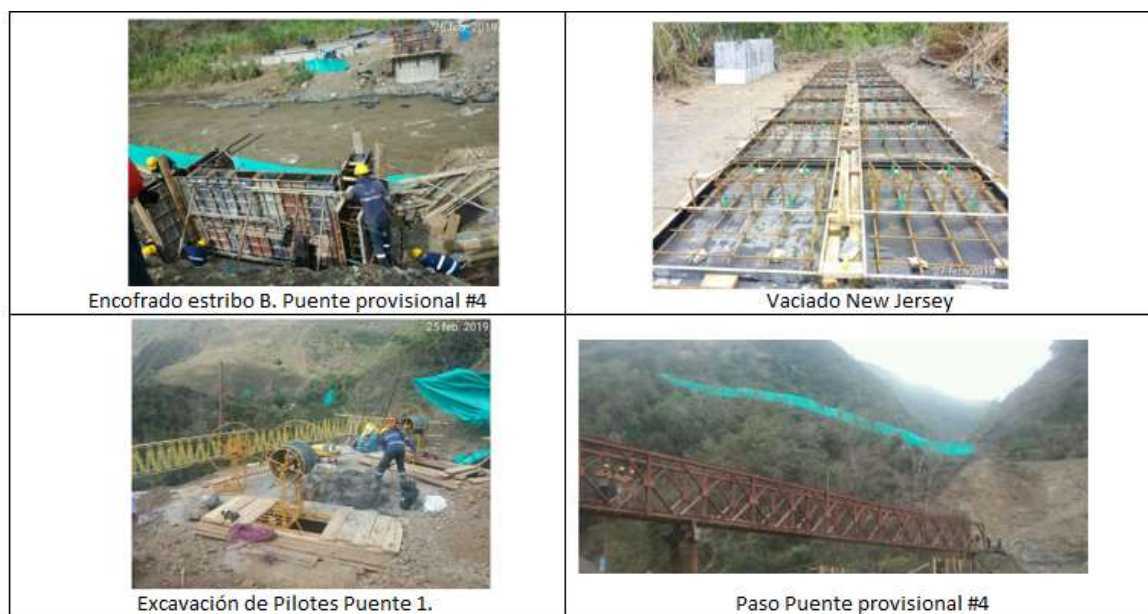
Figura 6. Construcción Puente Provisional N°4
