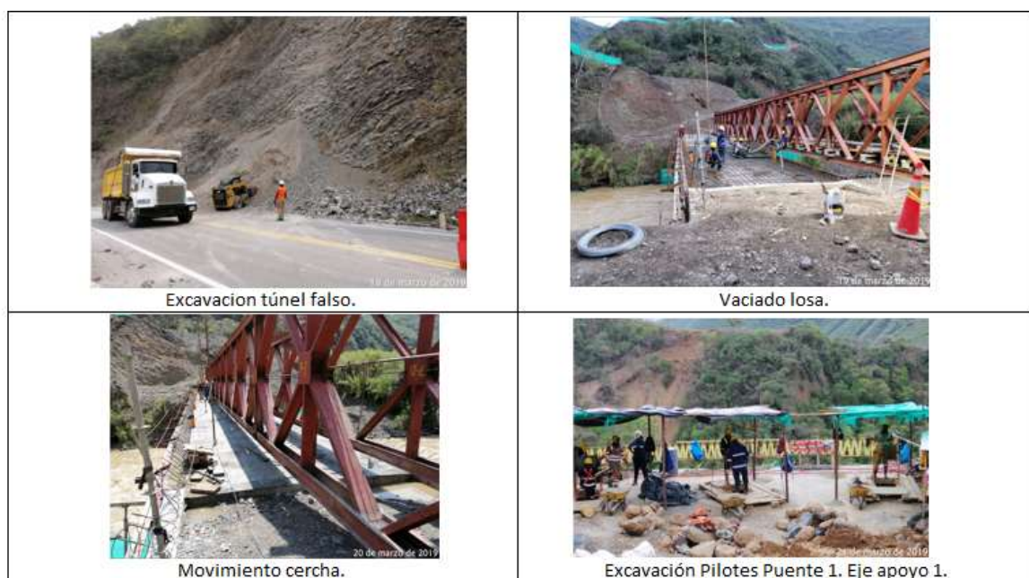
Figura 9. Registro actividades Puente 1, Puente Provisional N°4 y Vía
