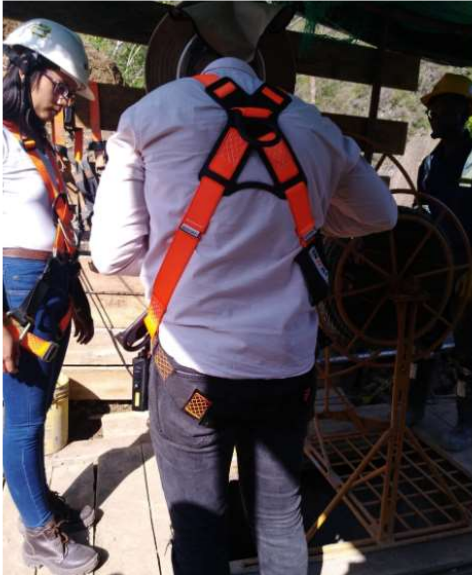
Figura 40. Supervisión anillos Caisson
