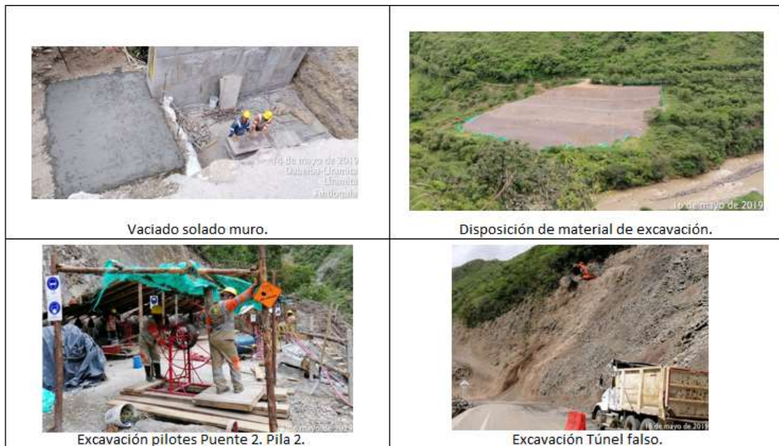
Figura 17. Registro de actividades realizadas en vía y Puente Fuente: Autora
