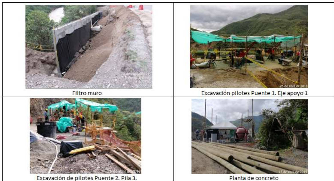
Figura 14. Registro de actividades realizadas en Puente 2 y Puente 1
