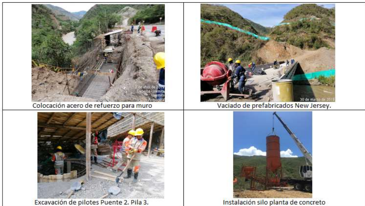
Figura 11. Registro actividades en Puente 2, vía y planta de concreto
