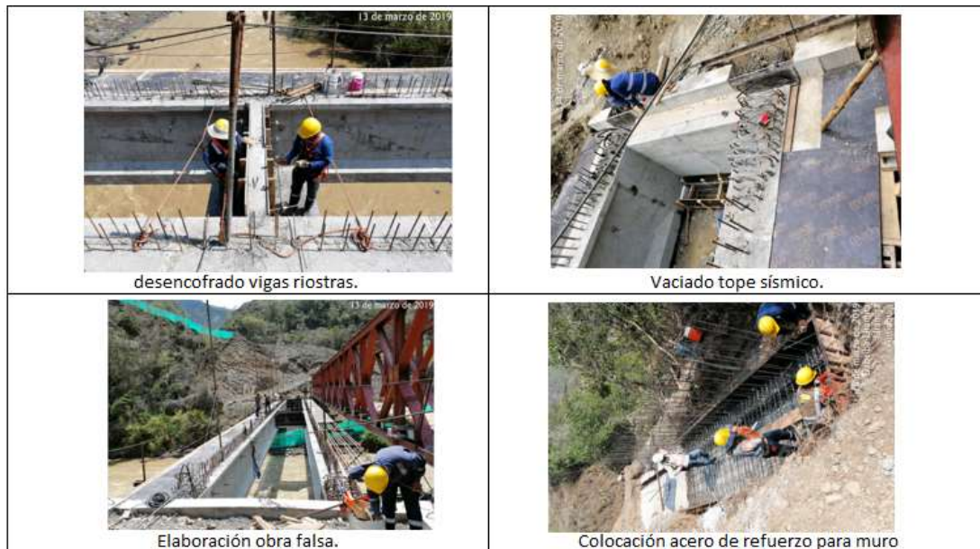
Figura 8. Elaboración obra falsa Puente Provisional N°4
