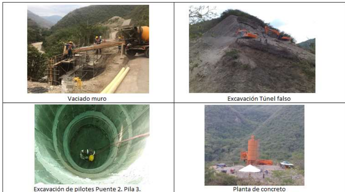
Figura 13. Actividades realizadas en vía, Puente 2 y Puente 1
