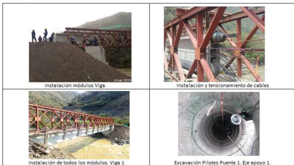
Figura 7. Instalación vigas Puente Provisional N°4
