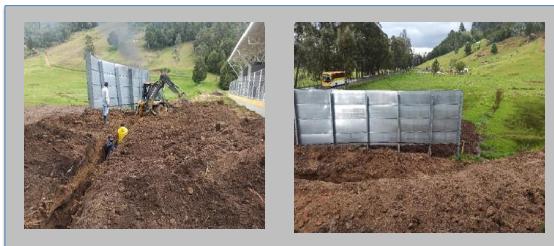
Figura 34. Trabajo de excavación.
