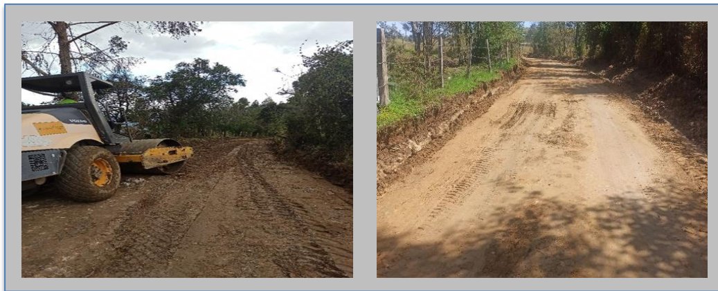
Figura 10. Trabajo de compactación. Vereda el Bosque, sector Caracoles Alto.
