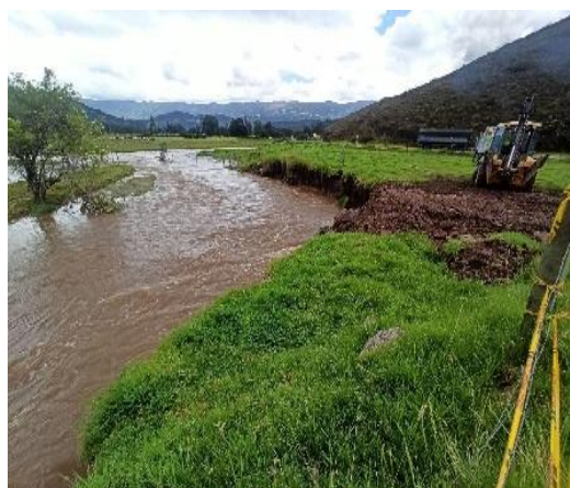
Figura 43. Zona de intervención. Río Minas
