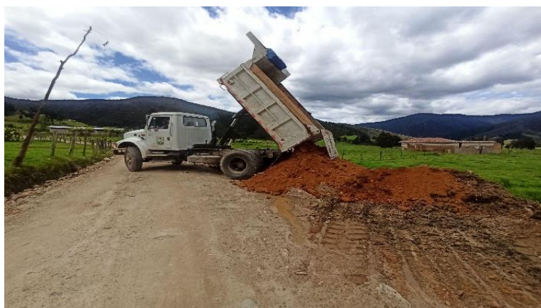
Figura 36. Deposición de material para atención a fenómeno de remoción de masa en zona autorizada.
