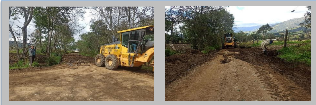
Figura 15. Trabajo de bombeo, cuneteo y ampliación de la vía. Vereda el Bosque sector Caracoles bajo.
