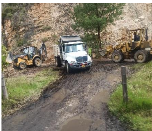
Figura 42. Cargue de volquetas con rocas de cantera de vereda Molino
