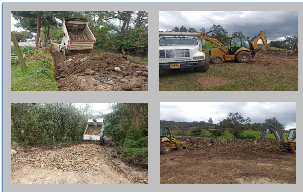
Figura 16. Trabajo de cargue y descargue de material de recebo y material tipo escombros de asfalto. Vereda el Bosque sector Caracoles Bajo.
