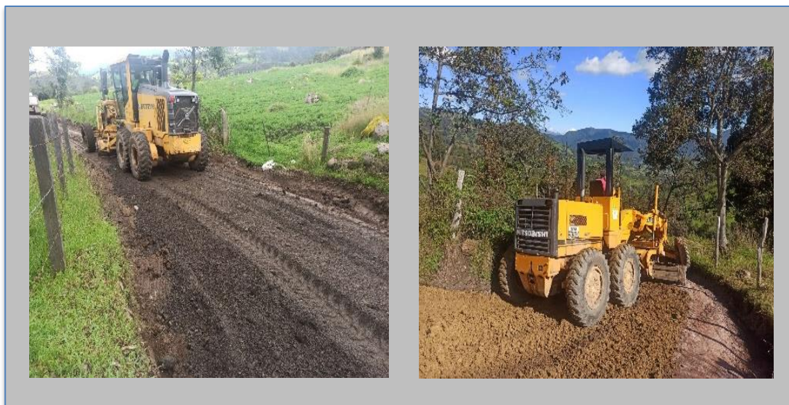
Figura 24. Trabajo de extendida de material de recebo y fresado de asfalto. Vereda el Bosque, sector Arrayanes.
