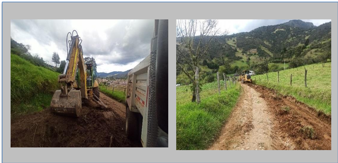
Figura 29. Trabajo de bombeo, cuneteo y ampliación de la vía. Vereda Montero.
