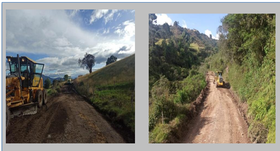
Figura 22. Trabajo de bombeo, cuneteo y ampliación de la vía. Vereda el Bosque sector Arrayanes.
