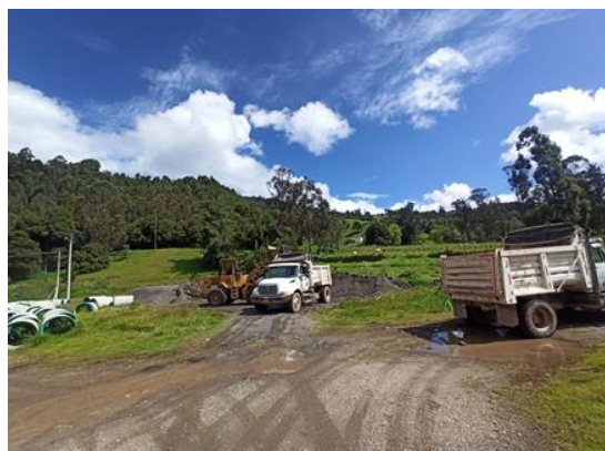
Figura 41. Depósito de fresado de asfalto. Centro de integración ciudadana (CIC)
