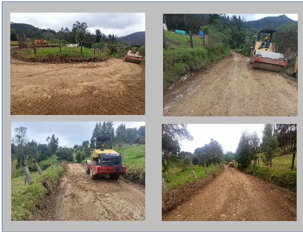
Figura 32. Trabajo de compactación. Vereda Montero.
