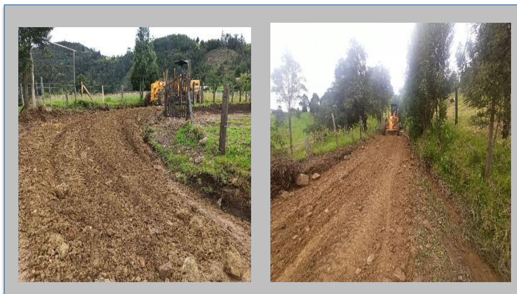
Figura 31. Trabajo de extendida de material de recebo. Vereda Montero.
