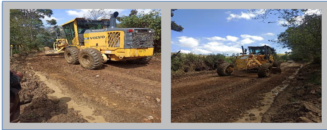
Figura 9. Trabajo de extendida de material de recebo. Vereda el Bosque, sector Caracoles Alto.
