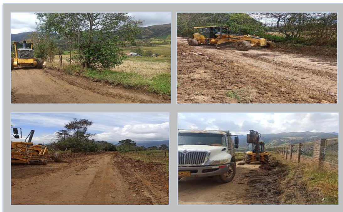
Figura 7. Trabajo de bombeo, cuneteo y ampliación de la vía. Vereda el Bosque, sector Caracoles Alto.
