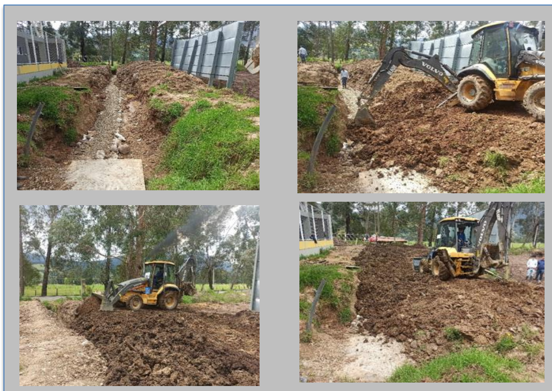
Figura 33. Trabajo de relleno.
