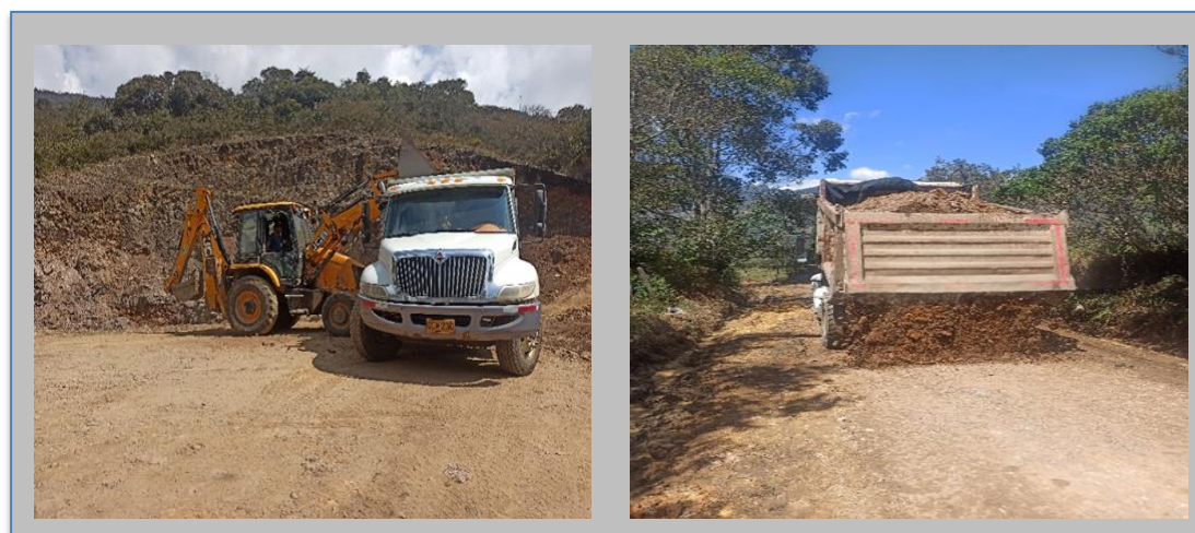
Figura 8. Trabajo de cargue y descargue de material de recebo. Vereda el Bosque, sector Caracoles Alto.
