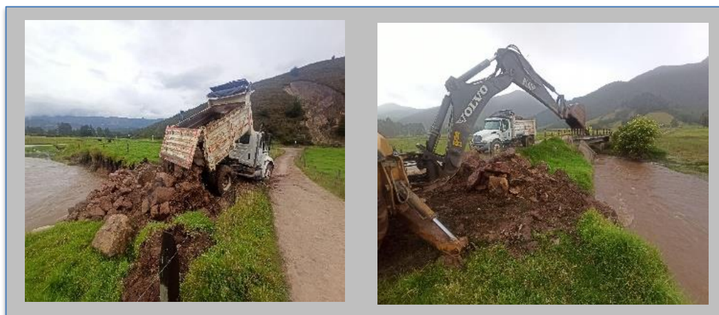
Figura 44. Trabajo de descargue de las rocas empleadas para la conformación del jarillón y su posterior ubicación en la orilla con la ayuda de la retroexcavadora.
