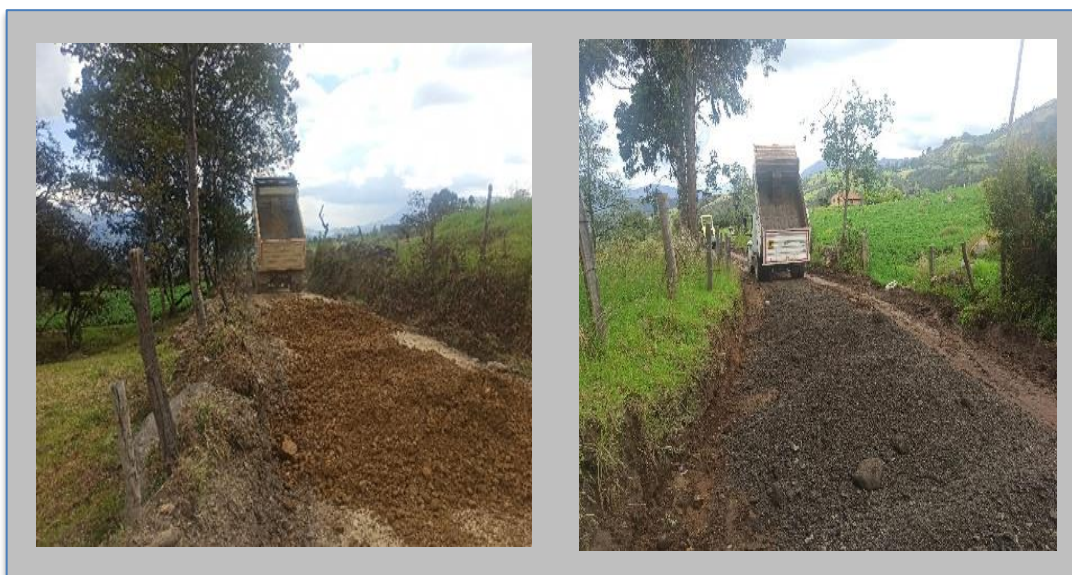
Figura 23. Trabajo de descargue de material de recebo y fresado de asfalto. Vereda el Bosque sector Arrayanes.
