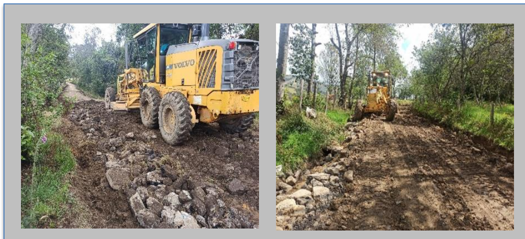
Figura 17. Trabajo de extendida de material de recebo y material tipo escombros de asfalto. Vereda el Bosque, sector Caracoles Bajo.
