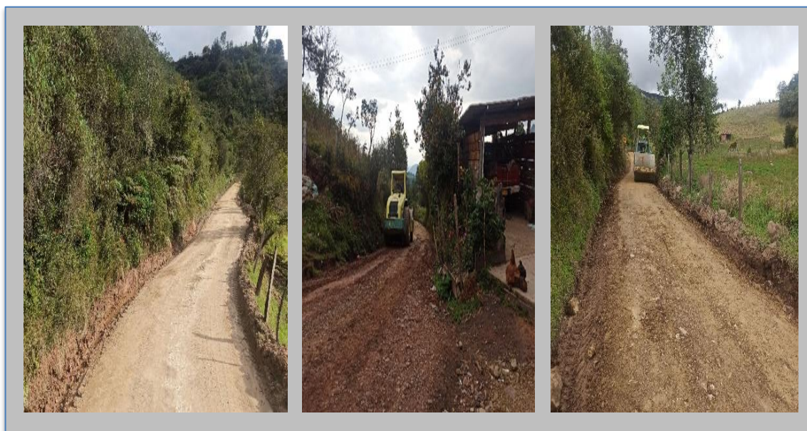
Figura 25. Trabajo de compactación. Vereda el Bosque, sector Arrayanes.
