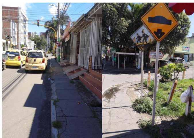
Figura 25. Identificación de la señalización vial, semaforización y estado del corredor. Elaboración propia en Excel.
