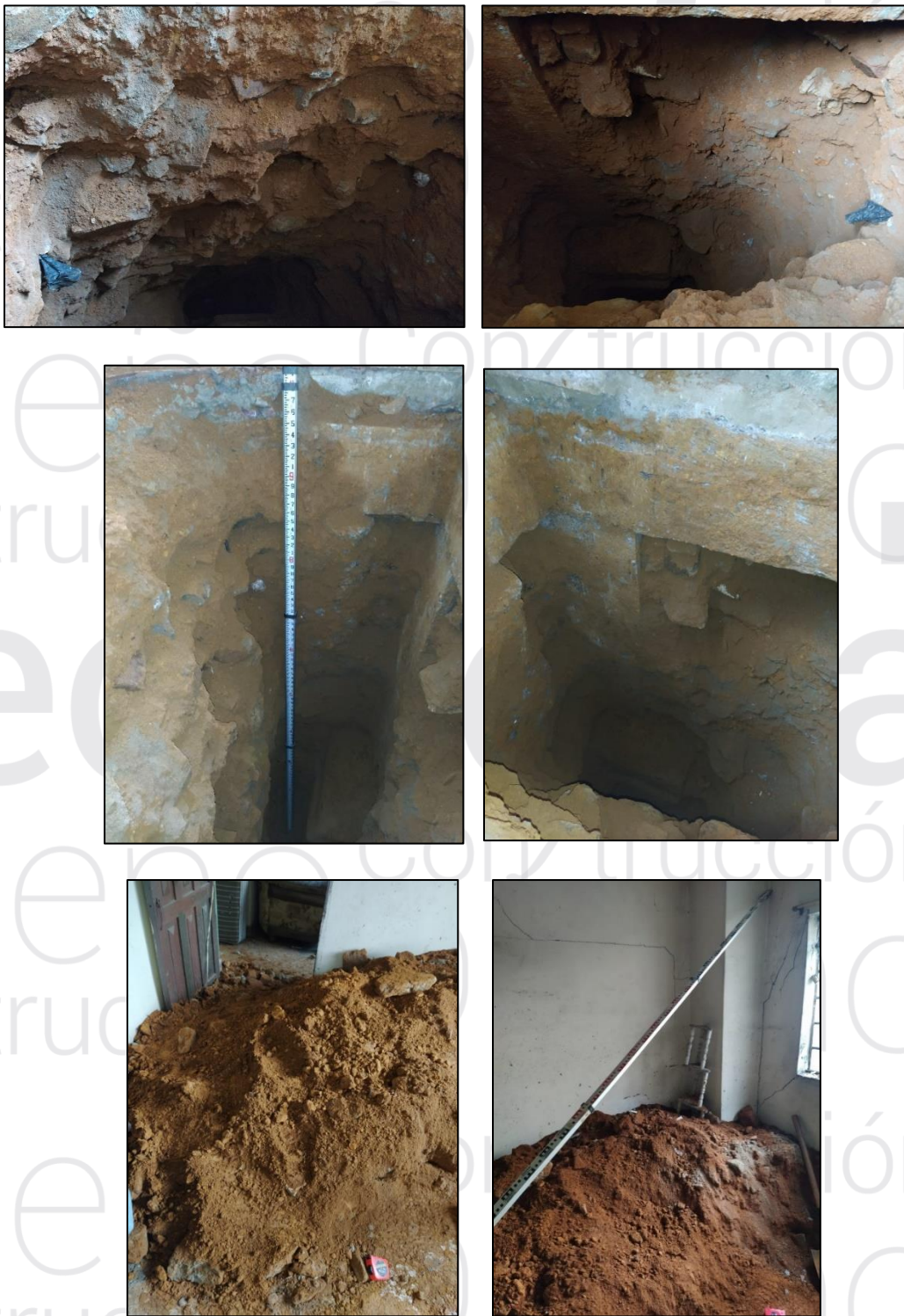
Figura 9 Registro fotográfico apique 2
