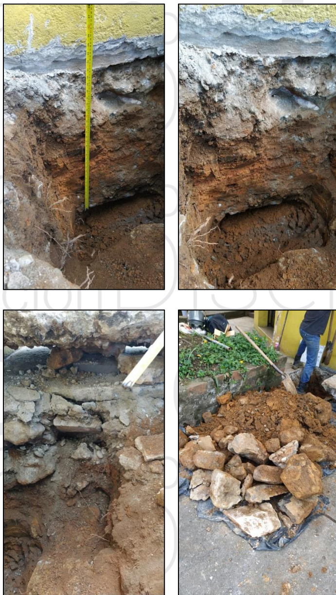
Figura 11 Registro fotográfico apique 3
