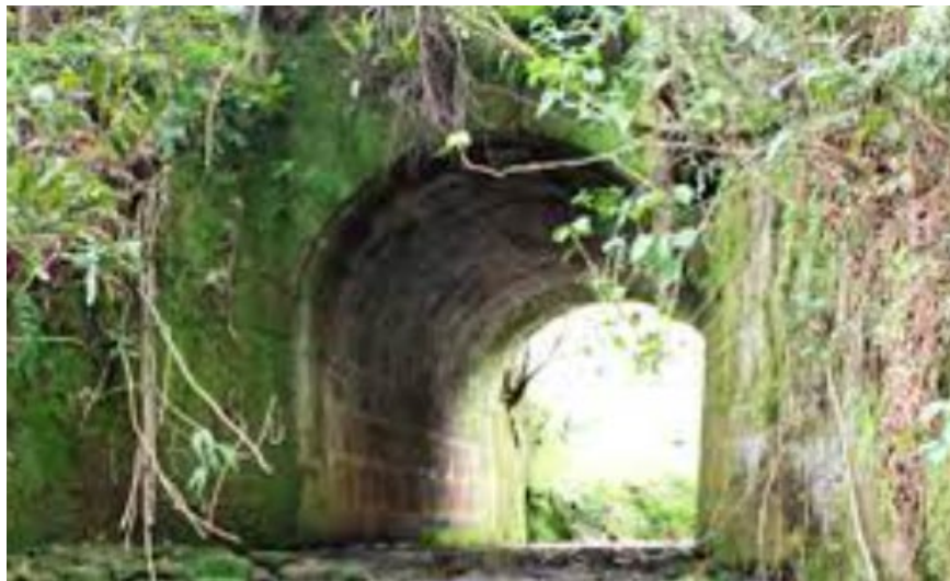
Fuente: Puente extremo S.A.S
