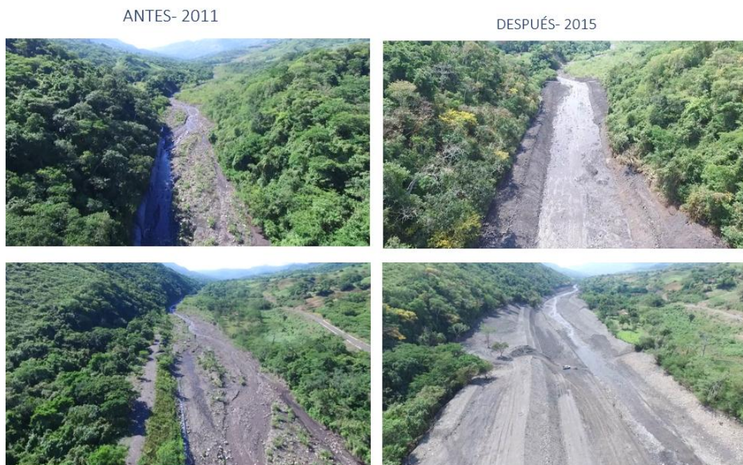
Imagen 5. Dragado Obras de mitigación realizadas en el año 2015
