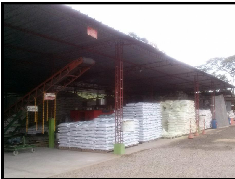
AREA DE RECALCINACION – MOLIENDA – PRODUCCION Y PRODUCTO FINAL.
