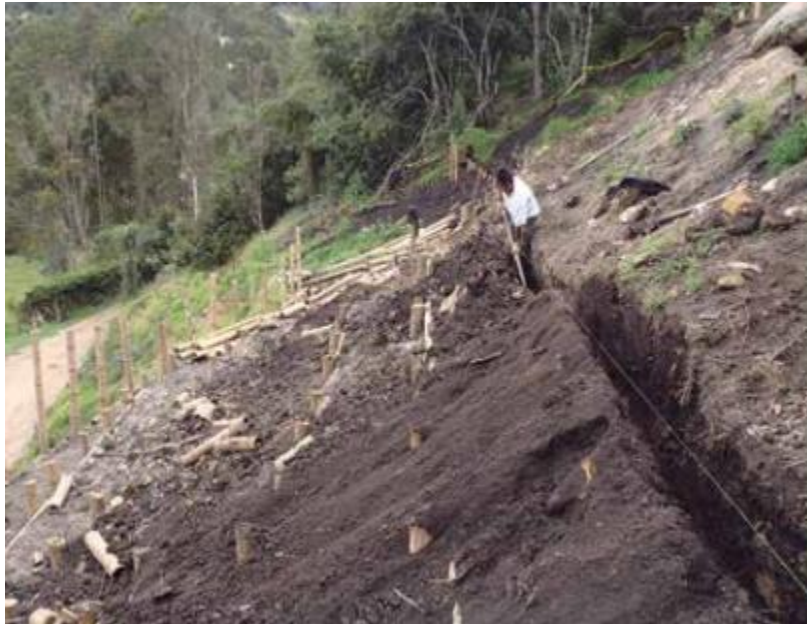
Figura 71. Zanja excavada para la colocación de las guaduas. Fuente: CAR
