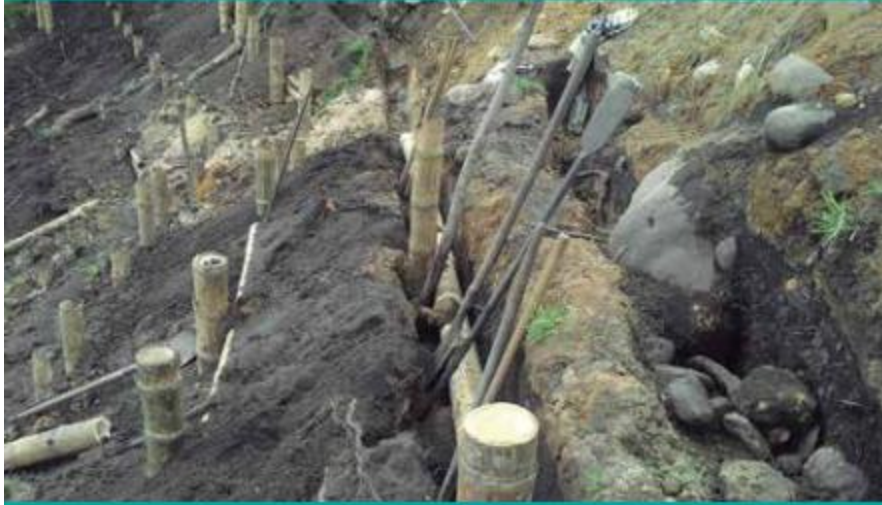
Figura 72. Parales de soporte para las guaduas horizontales. Fuente: CAR
