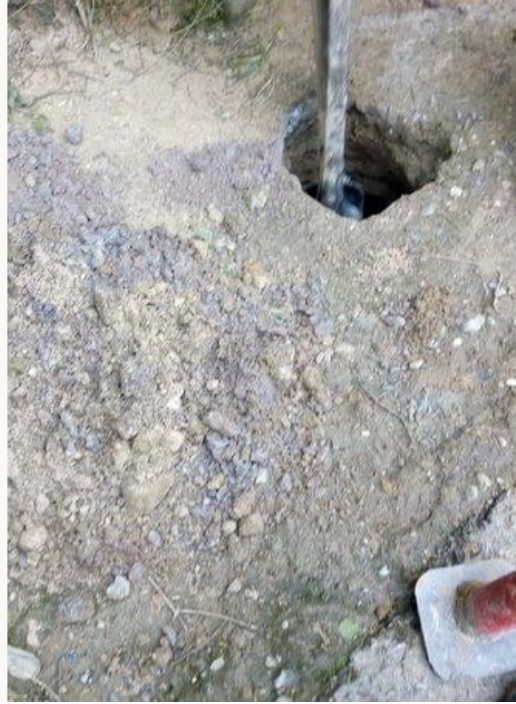
Figura 48. Sondeo N°3. Fuente: Propia
