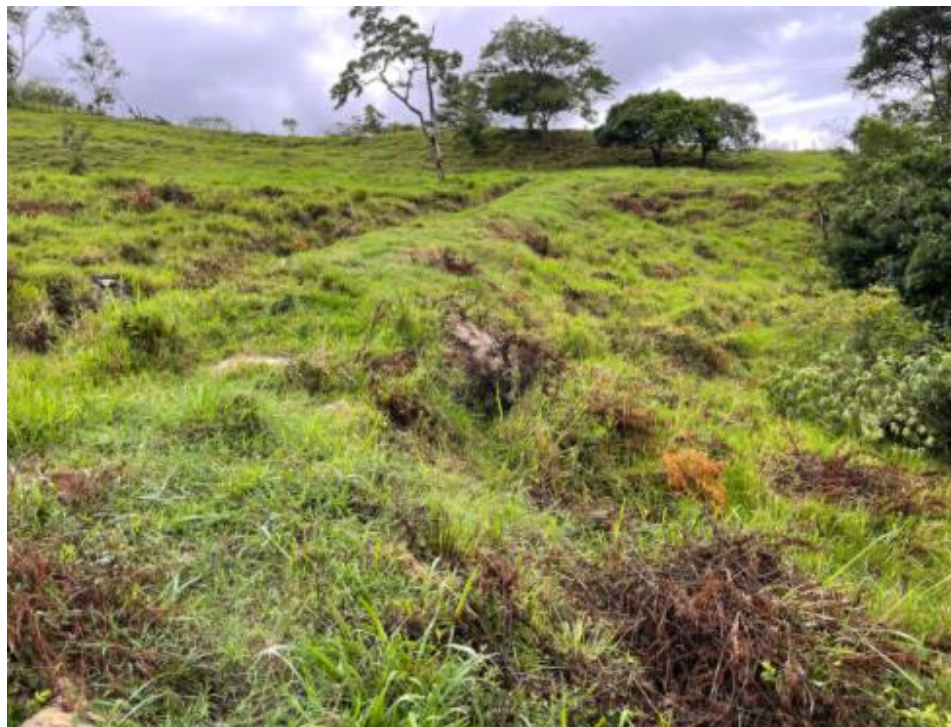
Figura 31. Escarpe principal: propia
