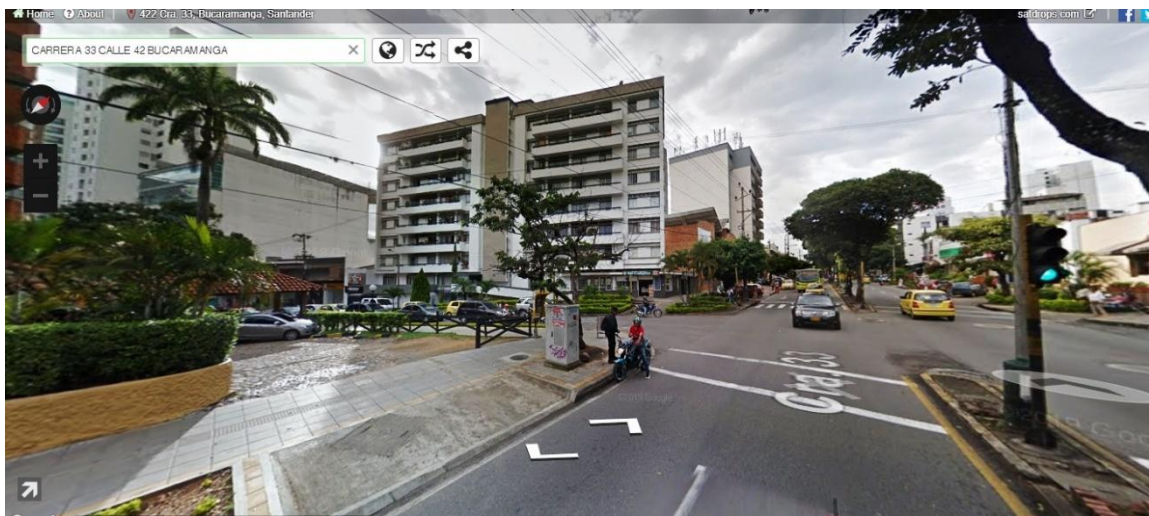
Figura 40. Edificio Santa Lucía. Carrera 33 calle 42
