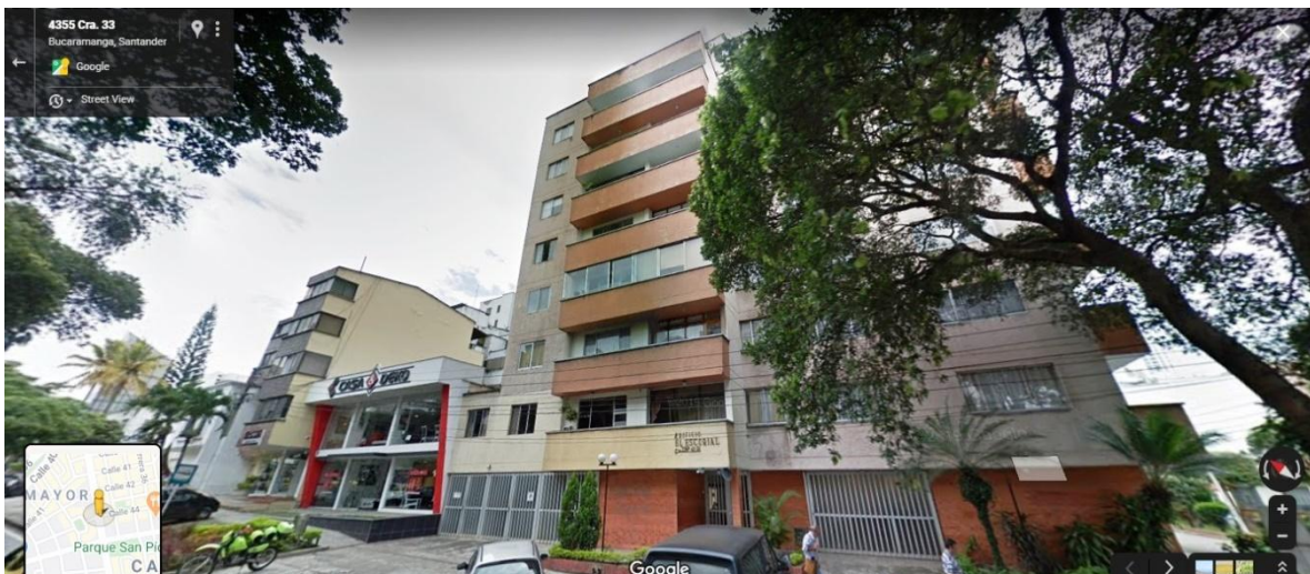
Figura 35. Edificaciones existentes frente al lote. Costado oriental Carrera 33
