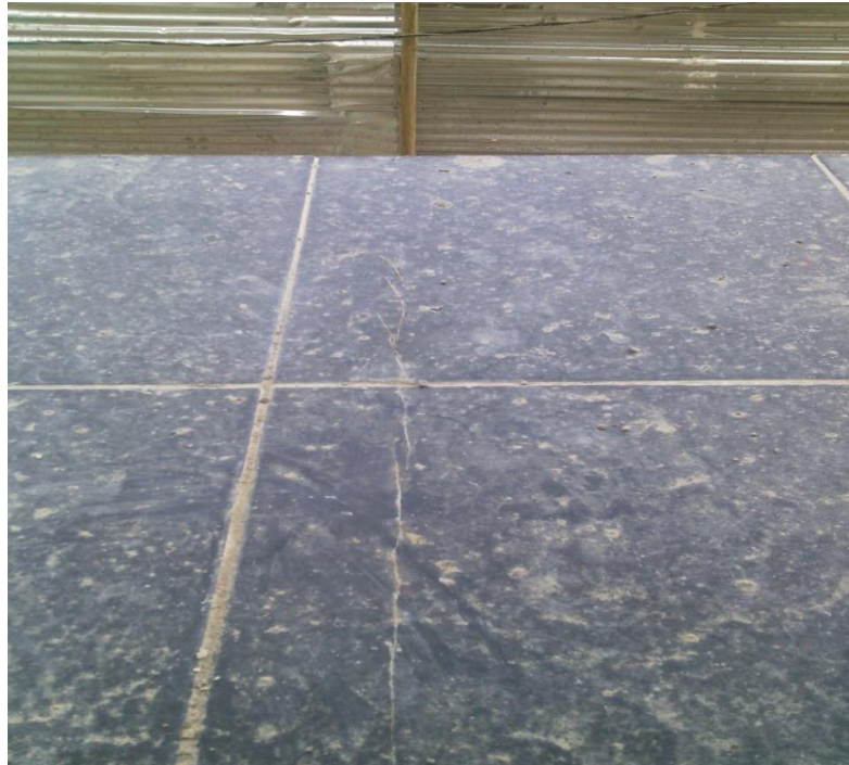
Ilustración 31. Fisura balcón
