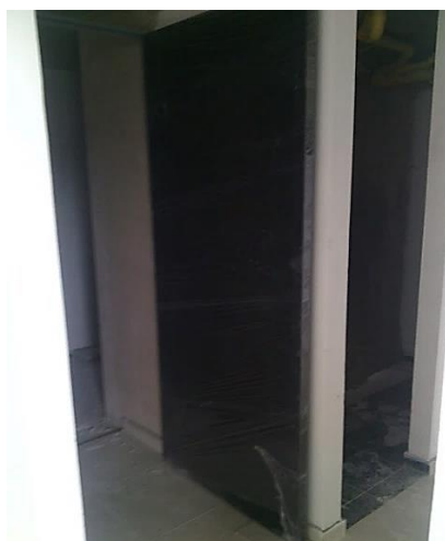
Ilustración 11. Verificación en obra de puertas
