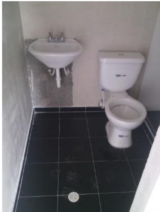
Ilustración 7.Verificación en obra pisos Cerámicos Baños
