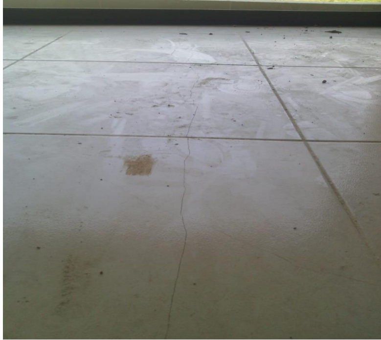
Ilustración 30. Fisura sala-comedor
