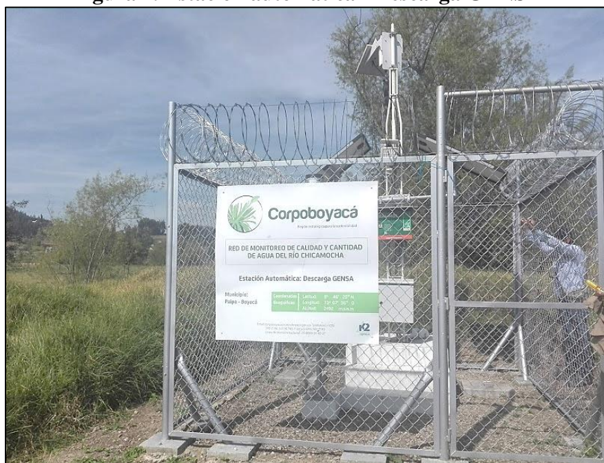
Figura 2. Estación automática - Descarga GENSA
