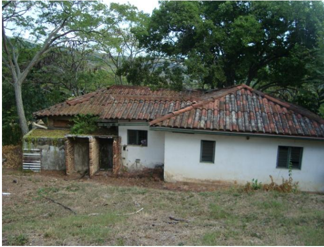
Figura No. 44 Estado actual casa ubicada en el lote No. 4
