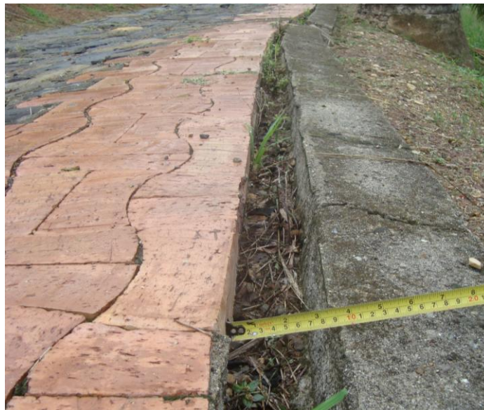
Figura No. 28 Desplazamiento de borde Externo
