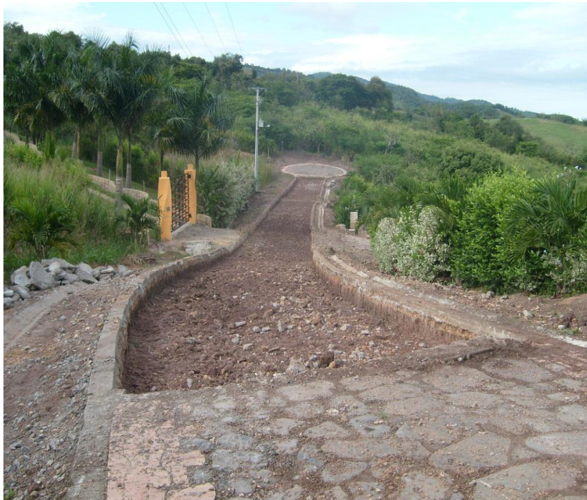
Figura No. 34 Inicio del proceso de adecuación del pavimento flexible
