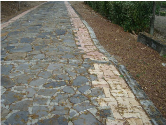
Figura No. 20 Imagen de Abultamiento (Tramo 2 vía Montelagos)
