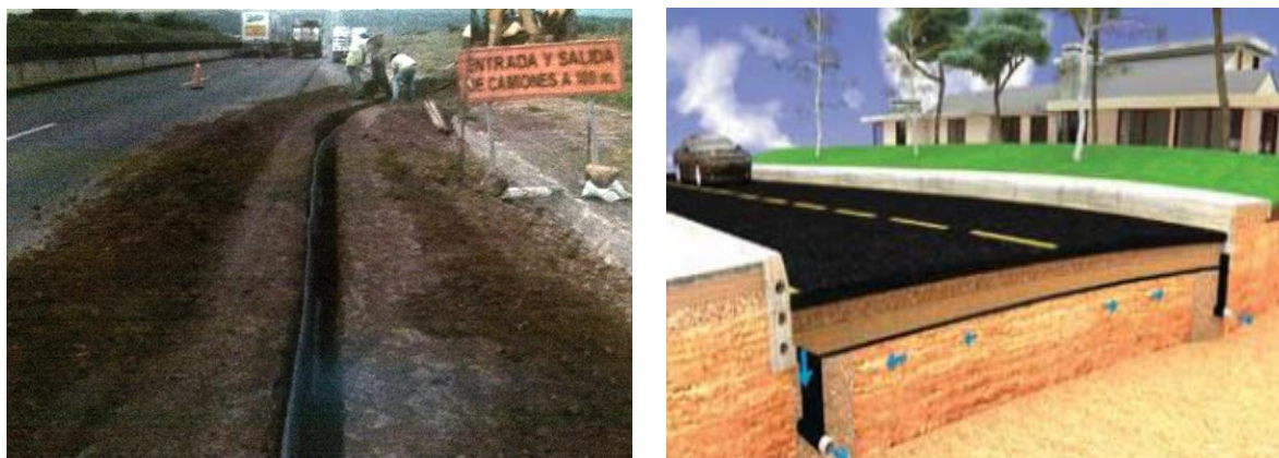
Figura No. 59 Forma de instalación del Geodren
