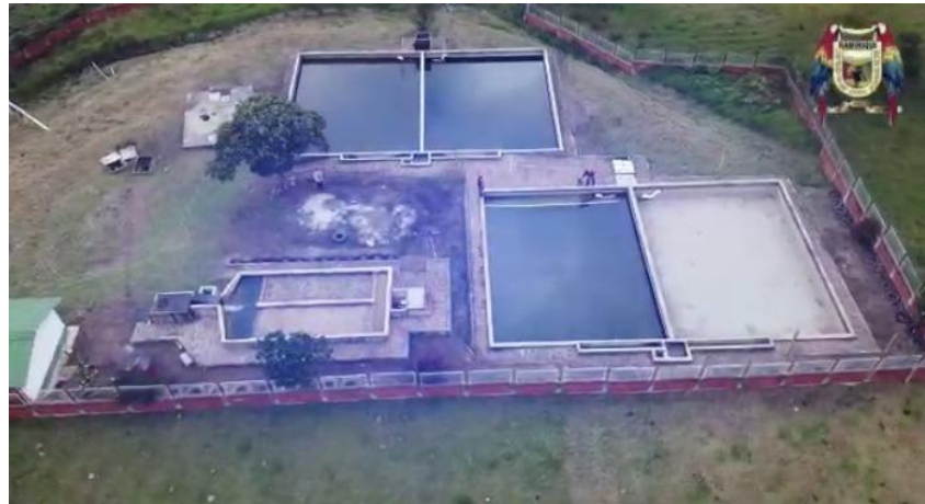
Imagen 4. PTAP sector urbano
