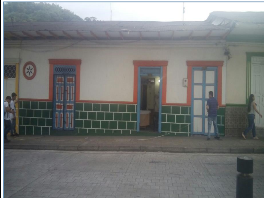
FACHADA DE LA CONSTRUCCION
