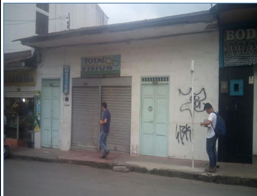
FACHADA DE LA CONSTRUCCION
