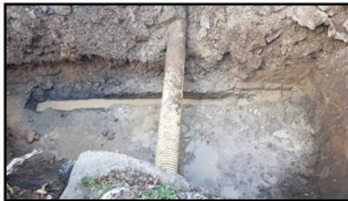
Fotografía 41. Excavación para construcción de dentellón.
