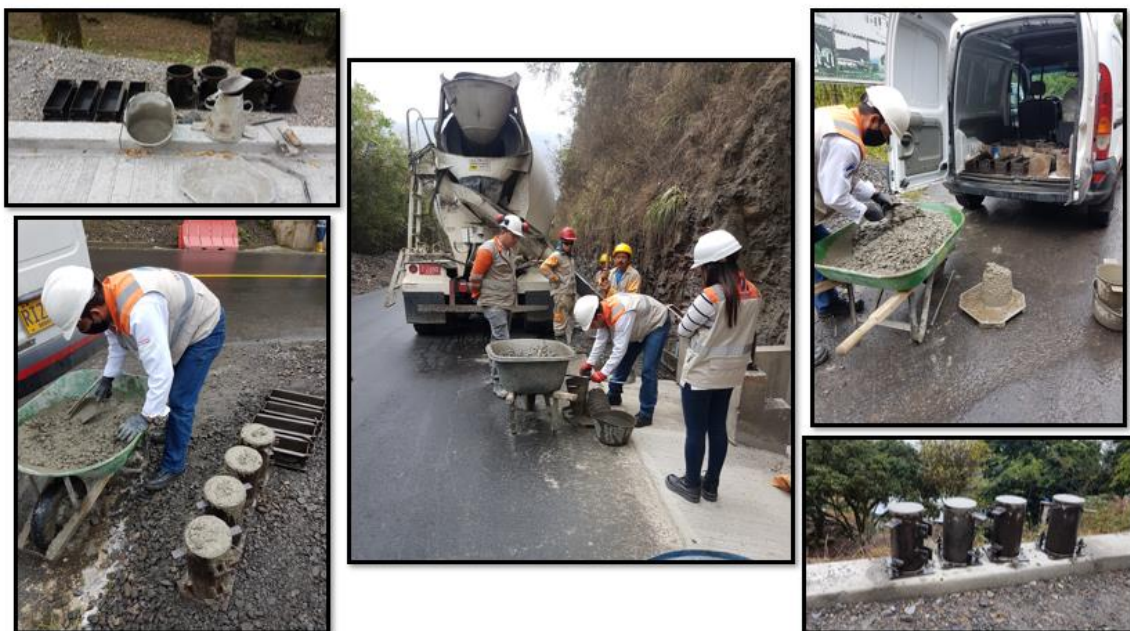
Fotografía 3. Ensayo de asentamiento y toma de muestras de concreto.
