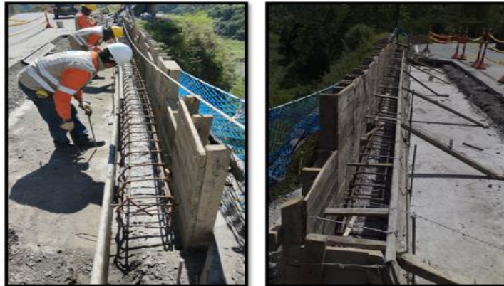
Fotografía 27. Instalación de Formaleta en Vástago de Muros.
