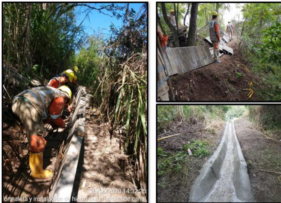
Fotografía 18. Proceso constructivo, Zanja de Coronación.
