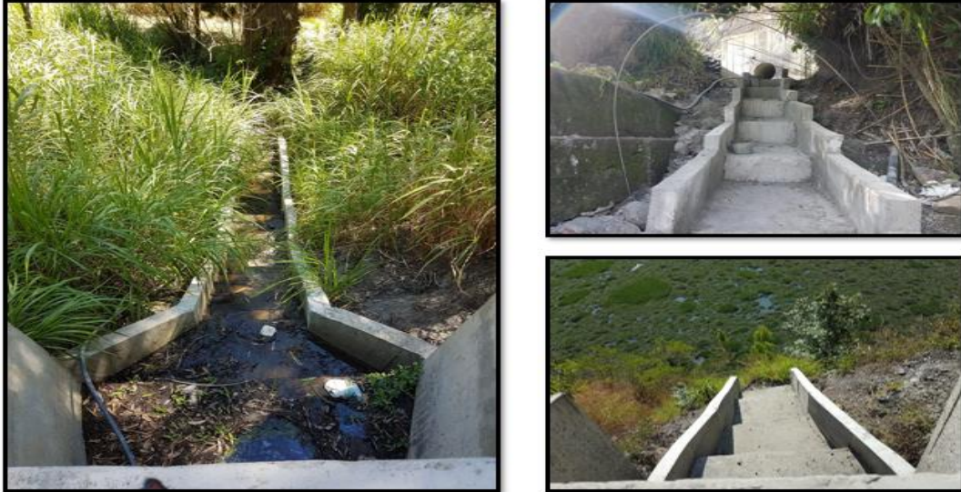
Fotografía 17. Obra terminada, dissipador escalonado.
