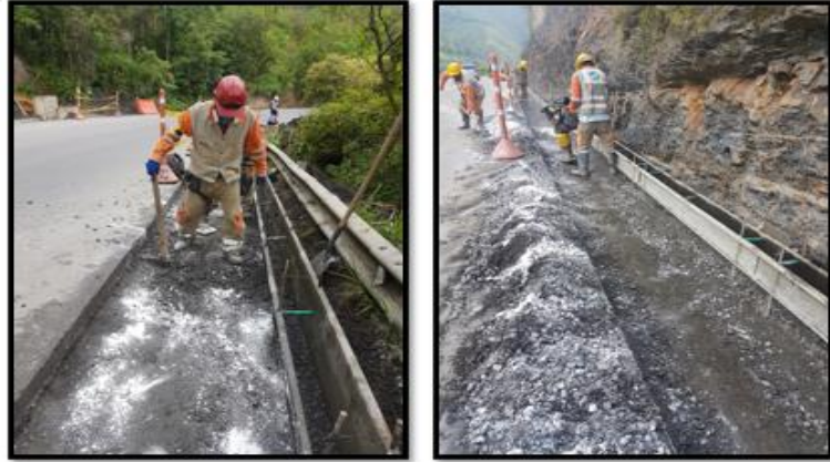
Fotografía 40. Métodos para estabilización de suelos.
