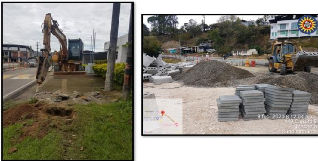
Fotografía 30. Demolición y almacenamiento de material Urbanismo.
