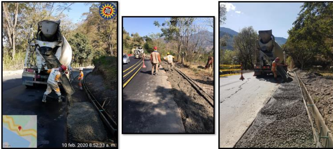
Fotografía 11. Vertido y vibrado de concreto en cunetas.
