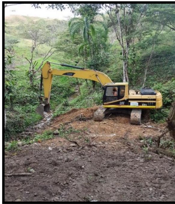
Fotografía 4. Excavación mecánica para construcción de alcantarilla.
