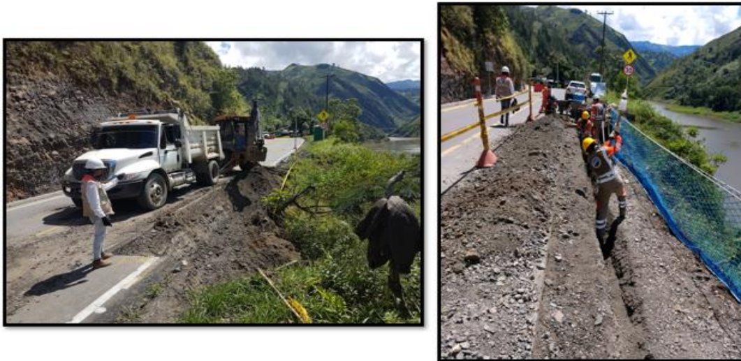
Fotografía 23. Excavación manual y mecánica, Muros de Contención.
