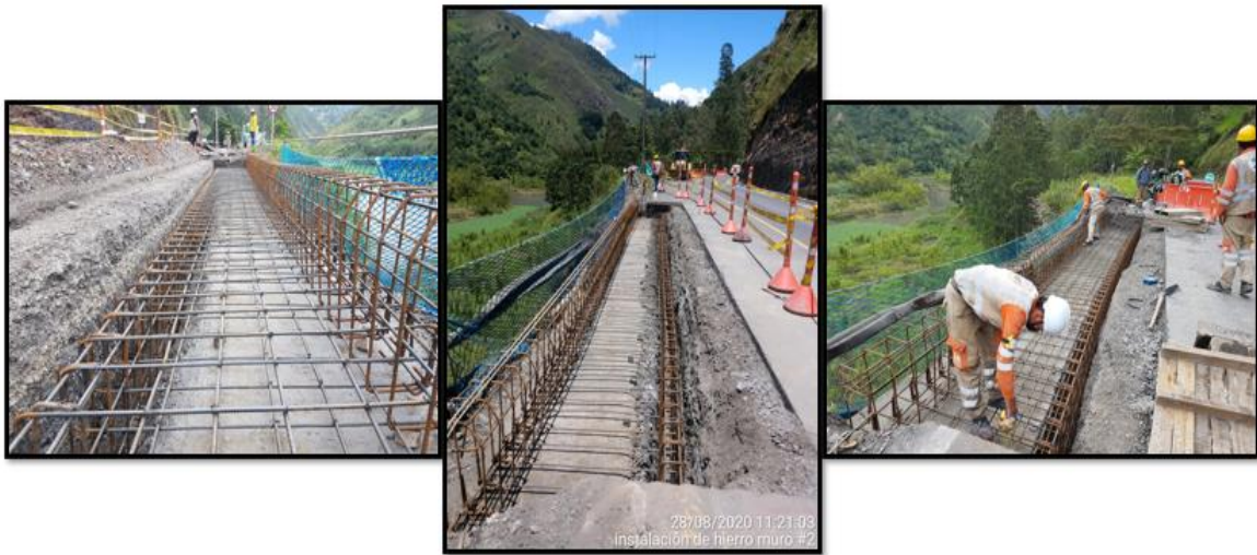
Fotografía 25. Instalación de acero Muros de Contención.
