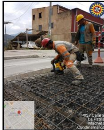
Fotografía 37. Perforación para anclajes de refuerzo.
