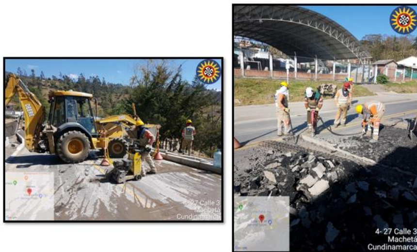
Fotografía 34. Corte y demolición de asfalto para pompeyanos.
