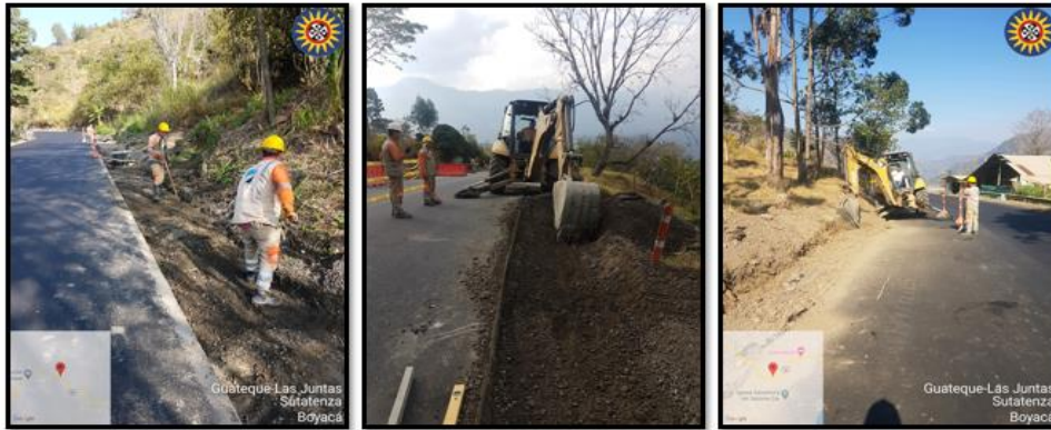
Fotografía 8. Excavación manual y mecánica para construcción de cuneta.
