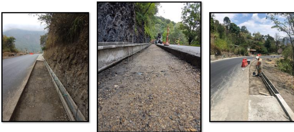
Fotografía 9. Alistado de pista e instalación de formaleta.
