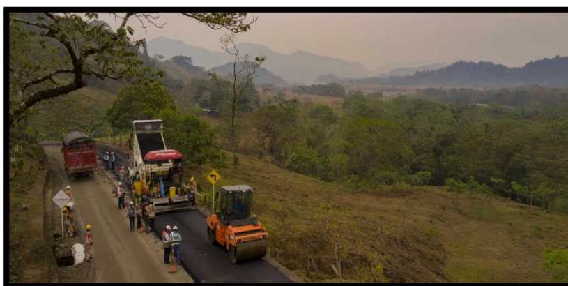
Fotografía 47. Instalación carpeta asfáltica Unidad Funcional 4.
