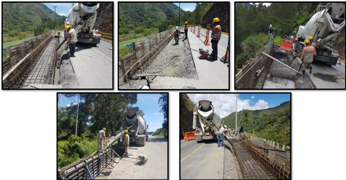
Fotografía 26. Vertido y vibrado de concreto Muros UF2 y UF4.
