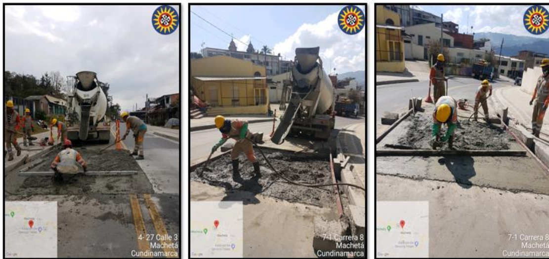
Fotografía 36. Vertido y vibrado de concreto en reductores de velocidad.
