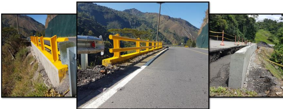
Fotografía 29. Muros Terminados UF2 y UF4.
