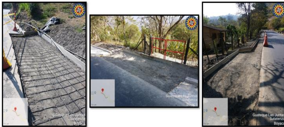
Fotografía 43. Adecuación de accesos vehiculares.
