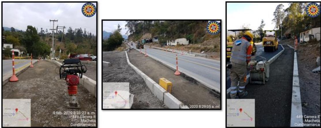
Fotografía 32. Conformación y compactación de suelo.
