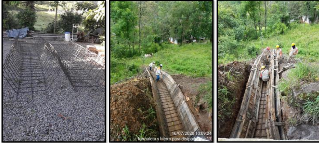
Fotografía 19. Proceso constructivo, Canal Rápido.
