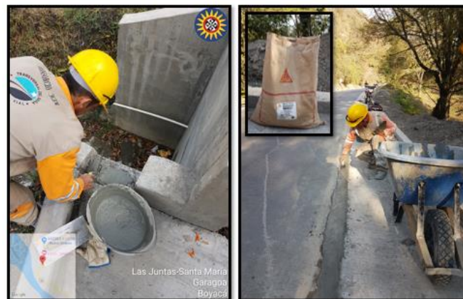
Fotografía 42. Resanes estructurales con uso de Sika Top.
