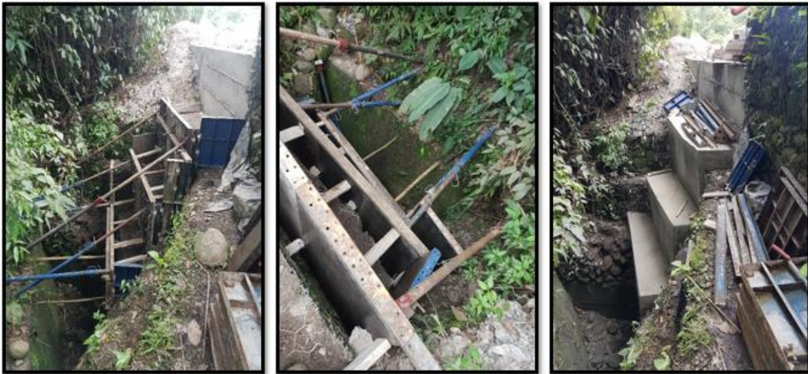
Fotografía 22. Instalación de formaleta para revestimiento de gaviones.
