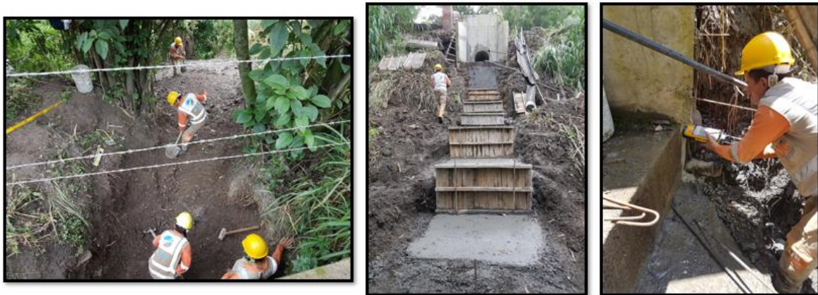
Fotografía 14. Excavación, solado de limpieza y anclajes, disipador escalonado.
