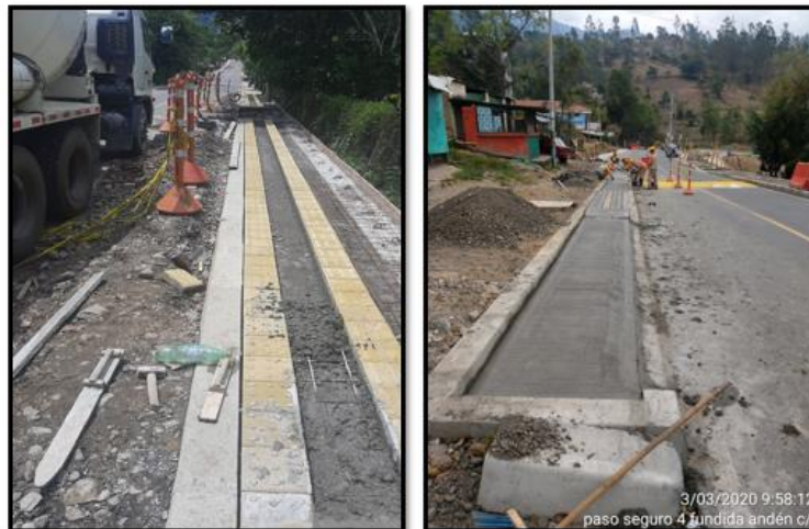
Fotografía 33. Vertido y acabado en losas de concreto.
