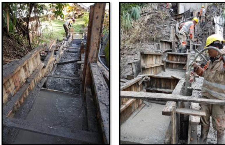
Fotografía 16. Vertido y vibrado de concreto, dissipador escalonado.
