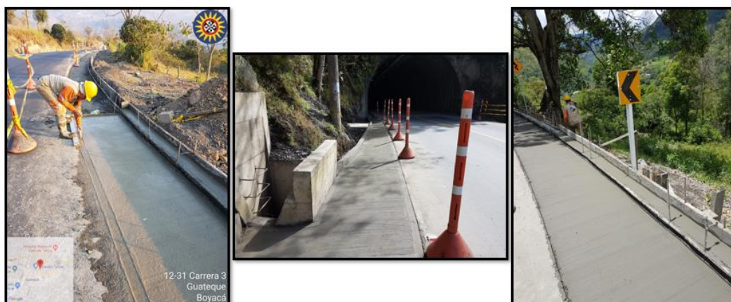
Fotografía 12. Acabado y obra terminada de cunetas.
