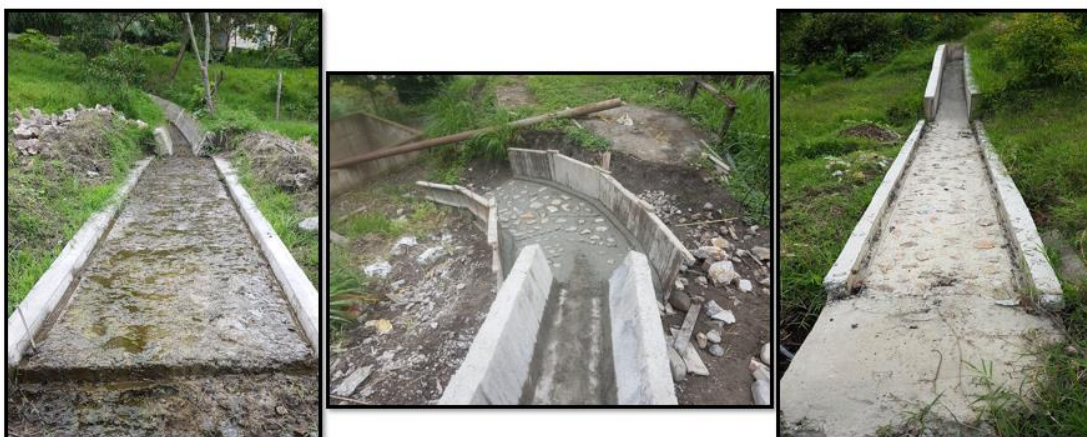
Fotografía 13. Construcción de empedrados UF2.
