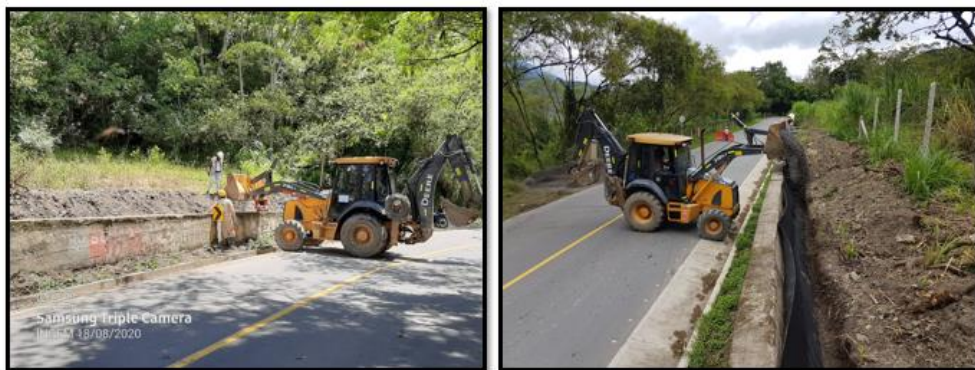
Fotografía 21. Relleno con material granular, instalación de Geodrén.
