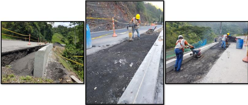
Fotografía 28. Relleno y compactación de material granular.
