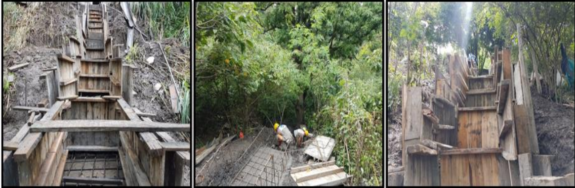
Fotografía 15. Instalación de acero y formaleta, dissipador escalonado.
