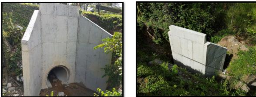
Fotografía 7. Obra terminada - alcantarillas.
