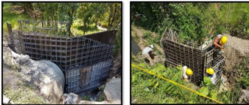
Fotografía 5. Instalación de acero en alcantarillas.
