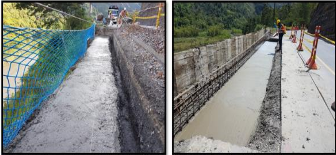
Fotografía 24. Solado de limpieza y aplicación de Antisol.
