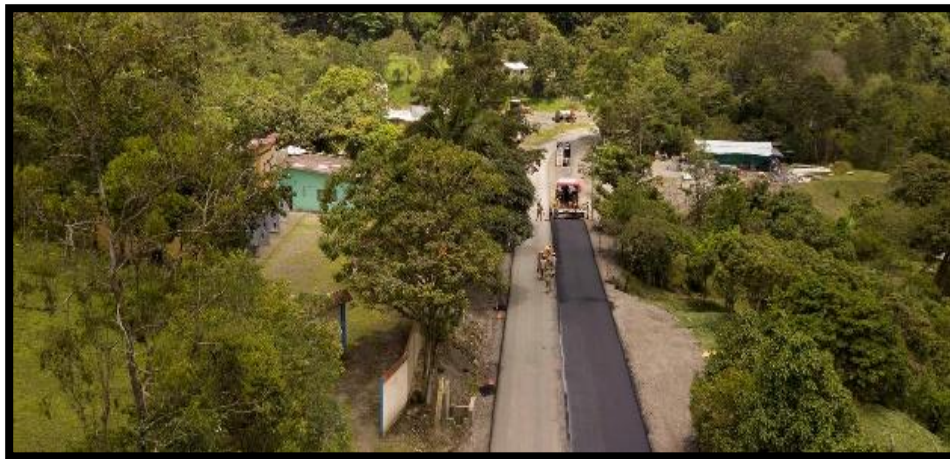
Fotografía 45. Instalación carpeta de rodadura, Unidad Funcional 2.
