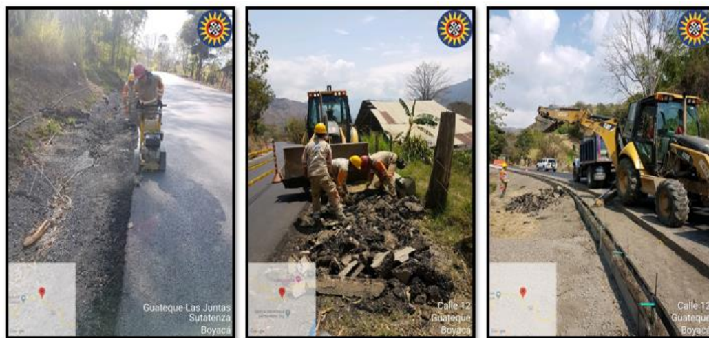
Fotografía 10. Corte de asfalto y recolección de escombros.
