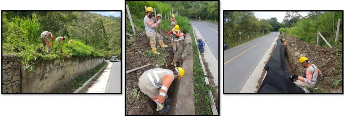
Fotografía 20. Actividades preliminares para instalación de Geodrén.
