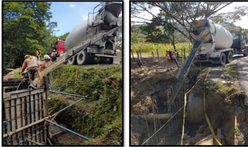
Fotografía 6. Vertido y vibrado de concreto en alcantarillas.
