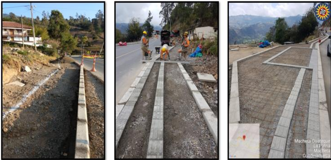
Fotografía 31. Instalación de Bordillo Prefabricado, Loseta y Malla electrosoldada.
