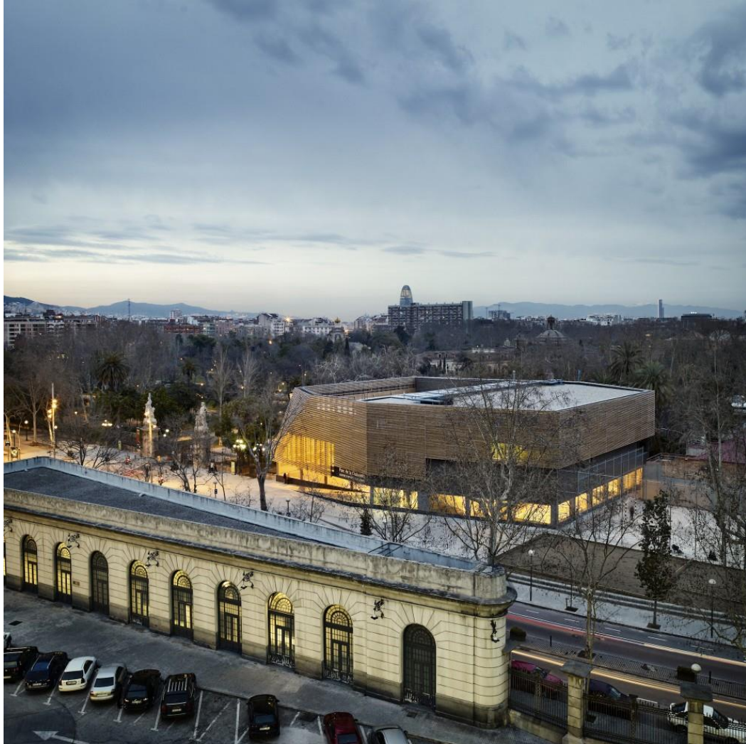
Figura 10. Foto exterior polideportivo dela ciudadella. Adaptado de Foto por José Hevia. (2010). Pabellón polideportivo y piscina cubierta / alday jover arquitectura y paisaje. Retrieved from http://www.archdaily.co/co/02-61748/pabellon-polideportivo-y-piscina-cubierta-inaki-alday-margarita-jover
