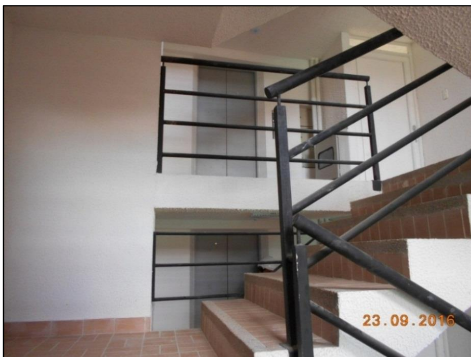
Imagen 8. Estado inicial de las escaleras y punto fijo de las torres
