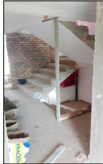
Imagen 26. Construcción del muro de cerramiento
