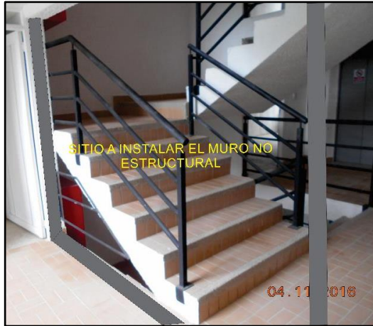
Imagen 25. Ubicación del muro de cerramiento
