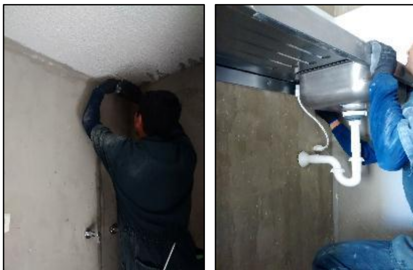
Imagen 28. Labores de instalación de duchas y grifería en apartamentos
