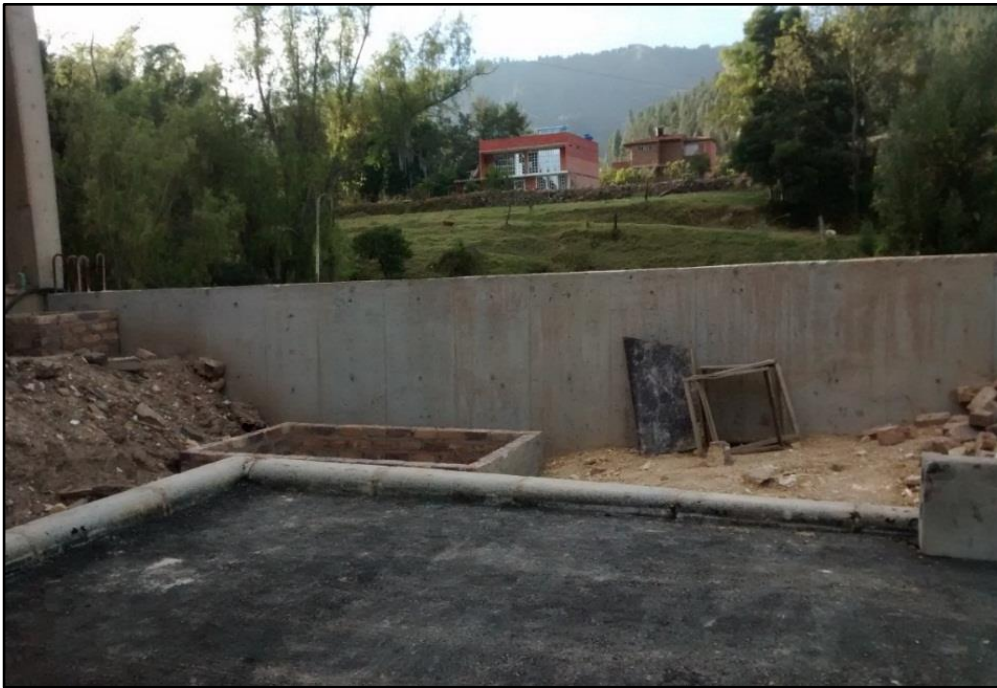
Imagen 10. Muro de contención MC - 2
