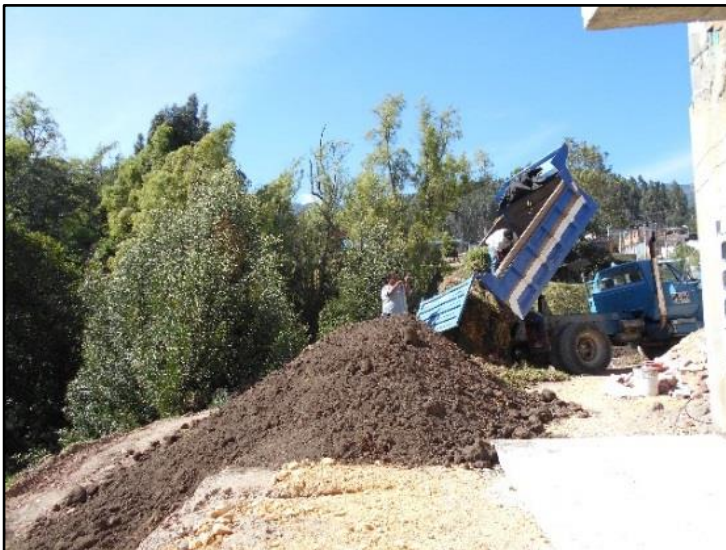
Imagen 32. Suministro de césped para empedración
