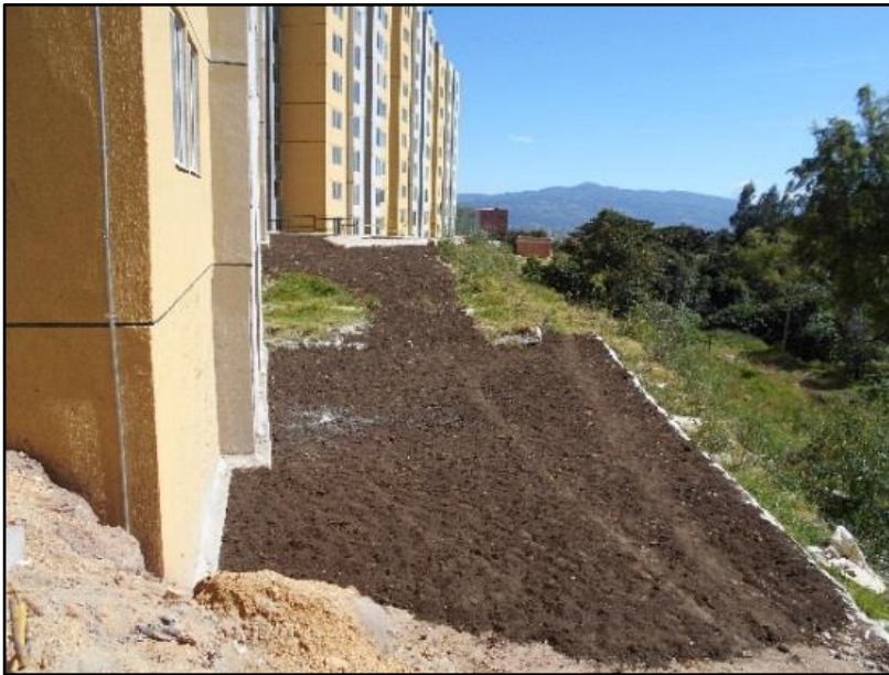
Imagen 33. Adecuación con tierra negra de la zona posterior a torre 4 y 5
