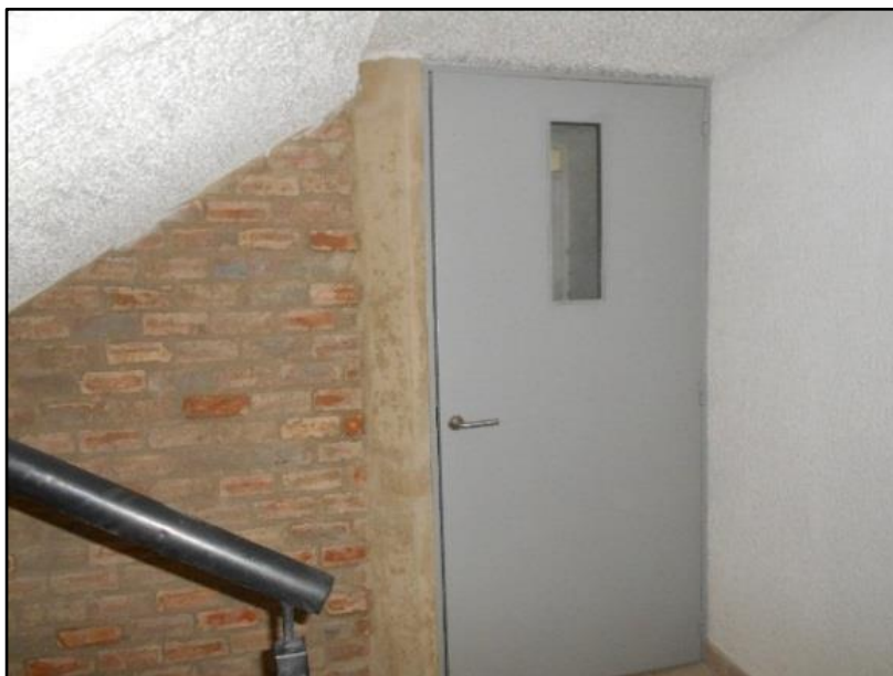
Imagen 29. Muro y puerta cortafuego terminados en su totalidad
