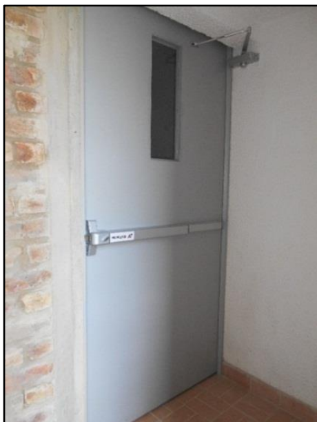
Imagen 30. Puerta cortafuego con accesorios totalmente instalada
