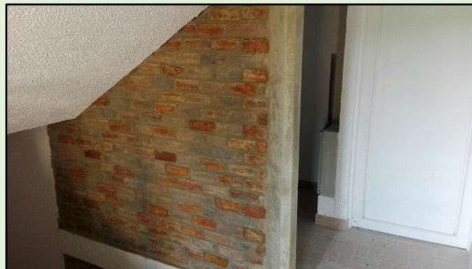
Imagen 27. Muro de cerramiento y columneta terminados
