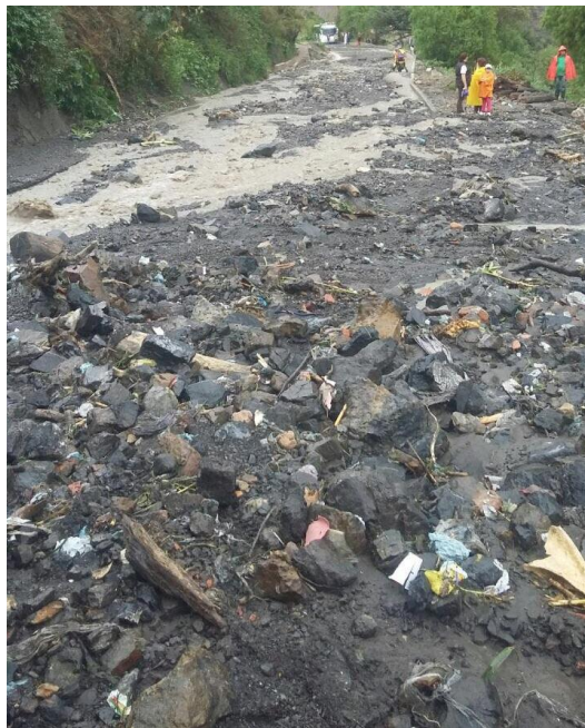
Ilustración 11 Obstrucción Vía Socotá Socha
