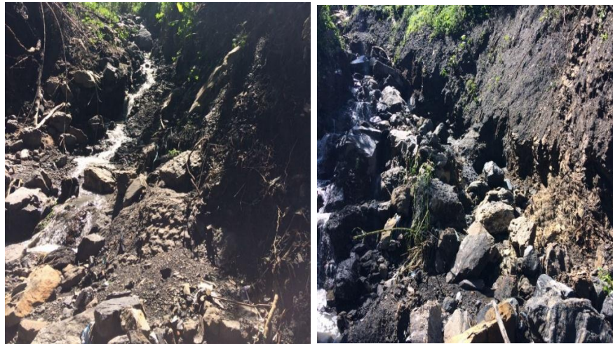
Ilustración 10 Erosión de Talud que Transporta Aguas Residuales Combinadas.
