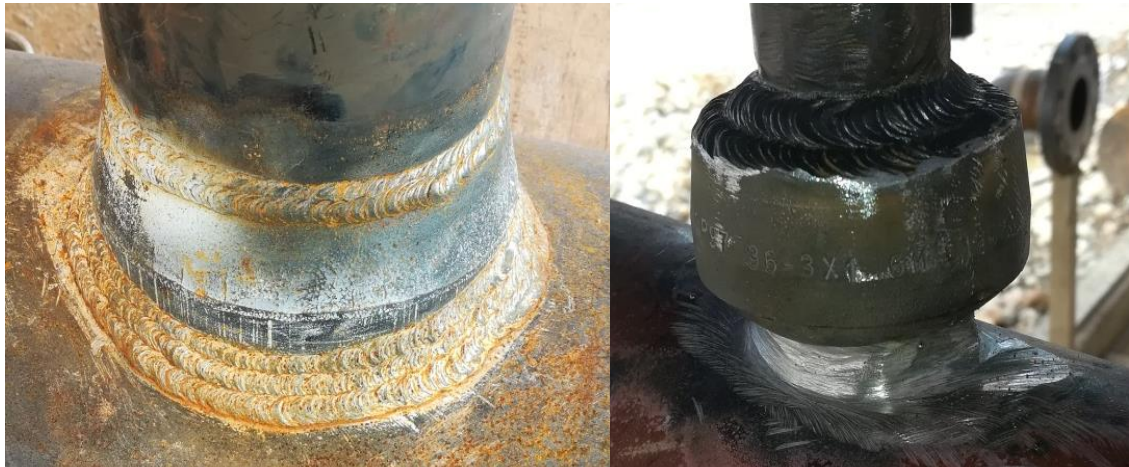
Figura 13 Soldadura en juntas de sokolet Welding de 4" y de 1"
