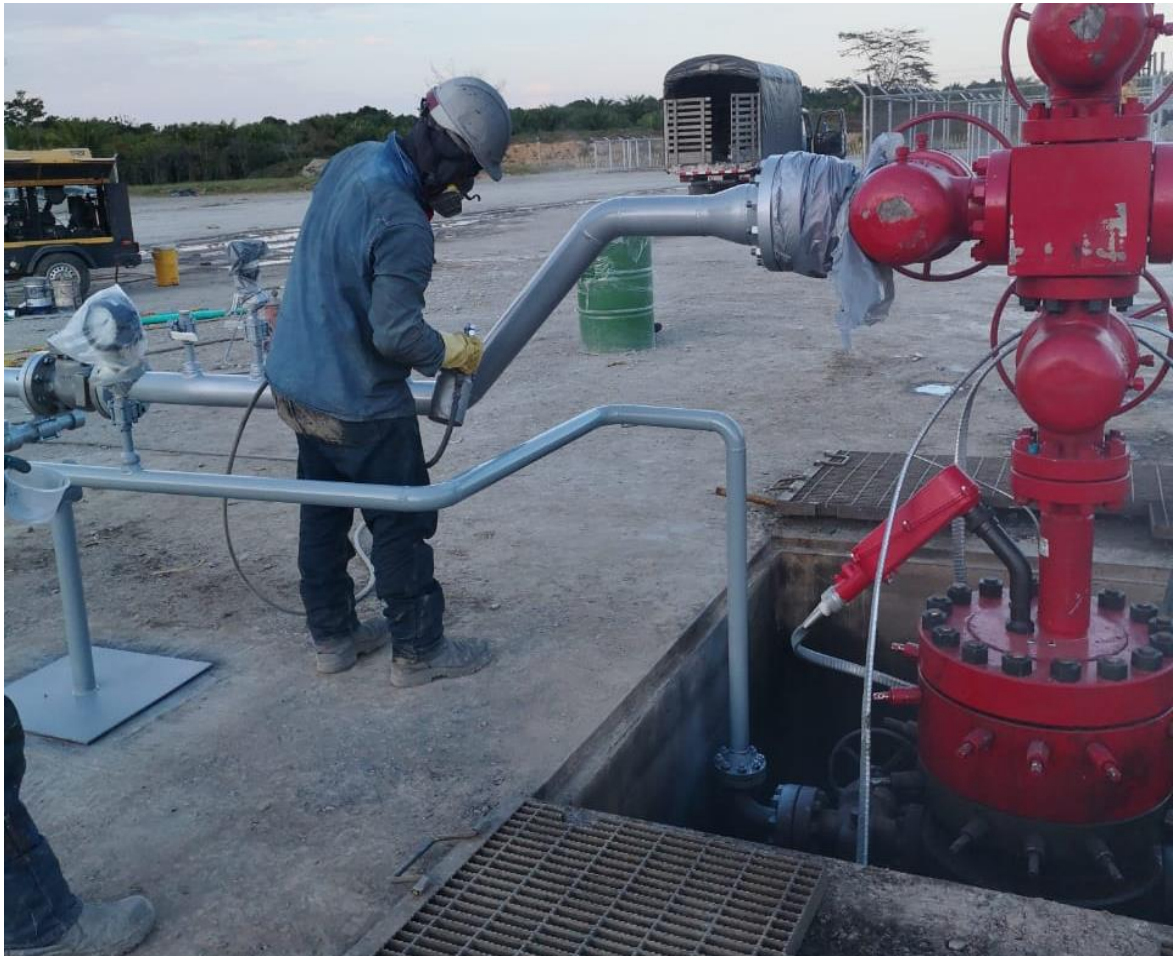
Figura 24 Acabado y recubrimiento de bajante de pozo
