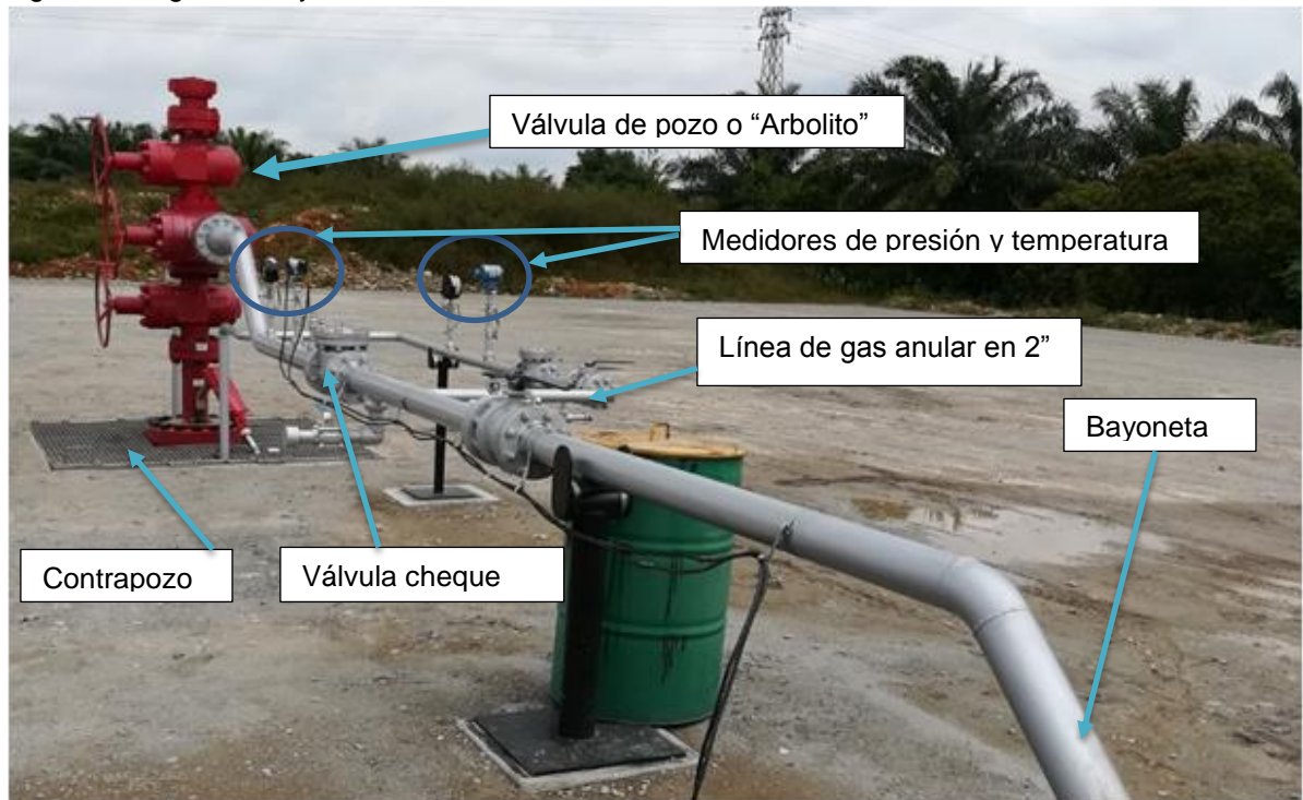
Figura 2 Imagen de Bajante de Conexión Terminada
