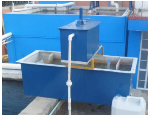
Figura 15. Vista perfil vertedero
