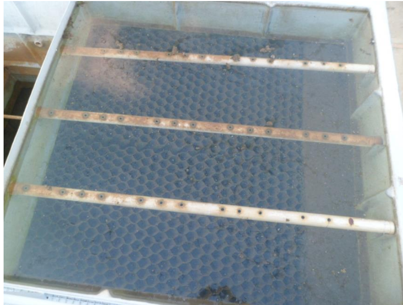
Figura 17. Vista planta cámara de sedimentación
