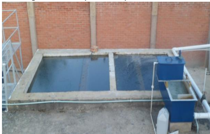
Figura 16. Vista planta tanque de floculación
