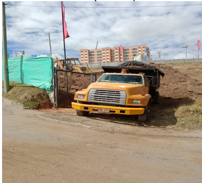
Ilustración 8. Trabajo de volquetas en obra
