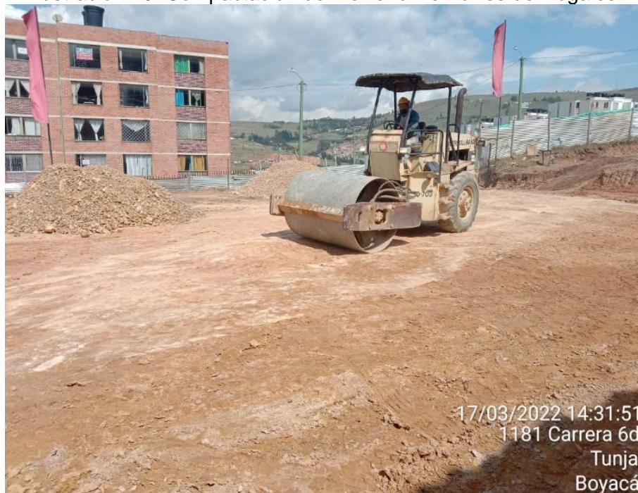
Ilustración 10. Compactación del Terreno De Torres de Nogaes
