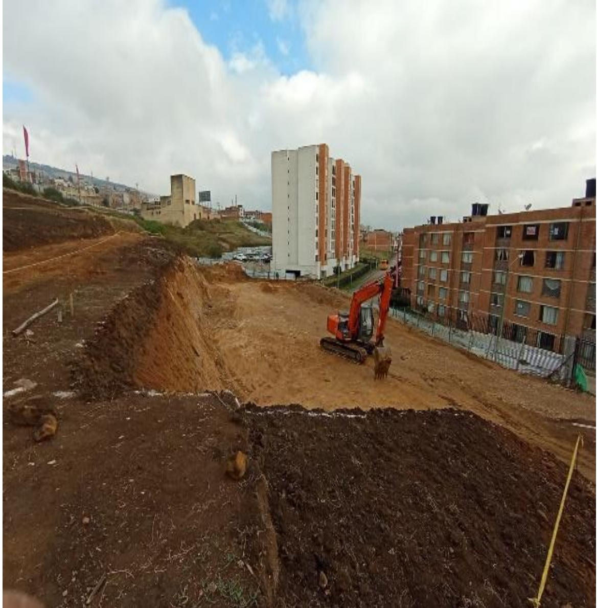
Ilustración 9. Terreno después Excavación en Torres de Nogales de la Florida
