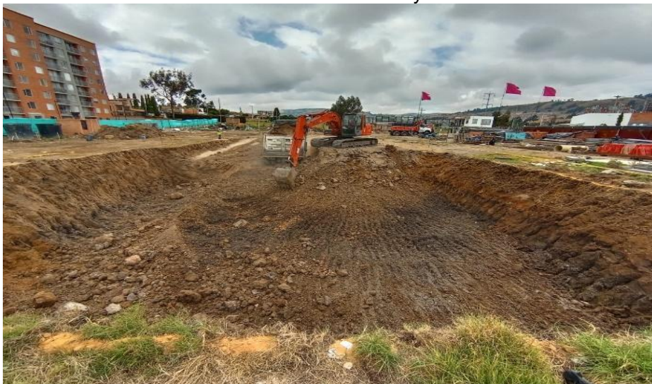
Ilustración 16. Excavación Proyecto Amalfi
