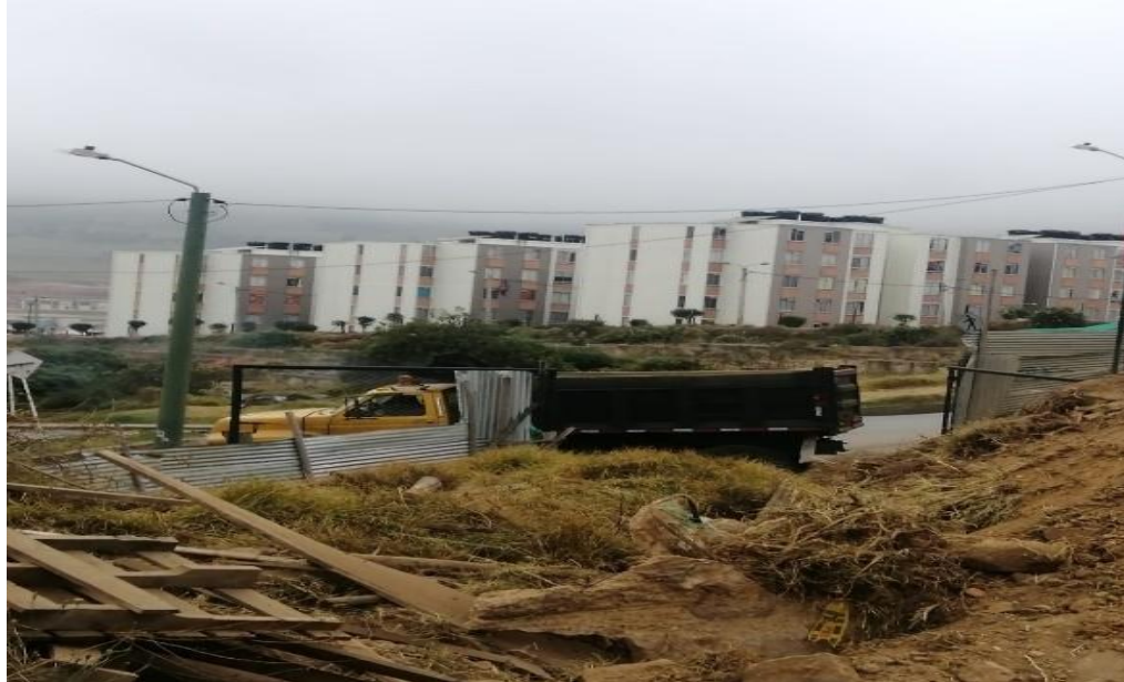
Ilustración 7. Ingreso de volquetas a Nogales
