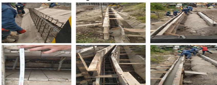
Figura 39. “Viga de confinamiento”
