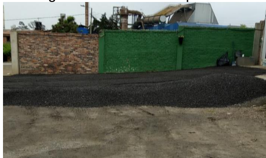
Figura 26. "Relleno de predios"
