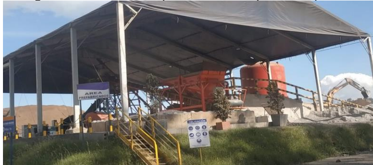
Figura 18. “Planta de prefabricados (Area de prefabricados)”
