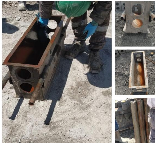
Figura 22. “Formaleta Bordillos A-85”
