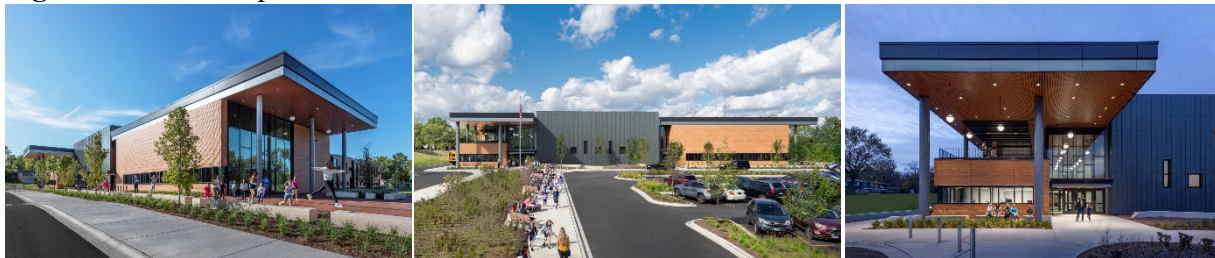
Figura 11. Escuela primaria Lisle. Vistas exteriores.
