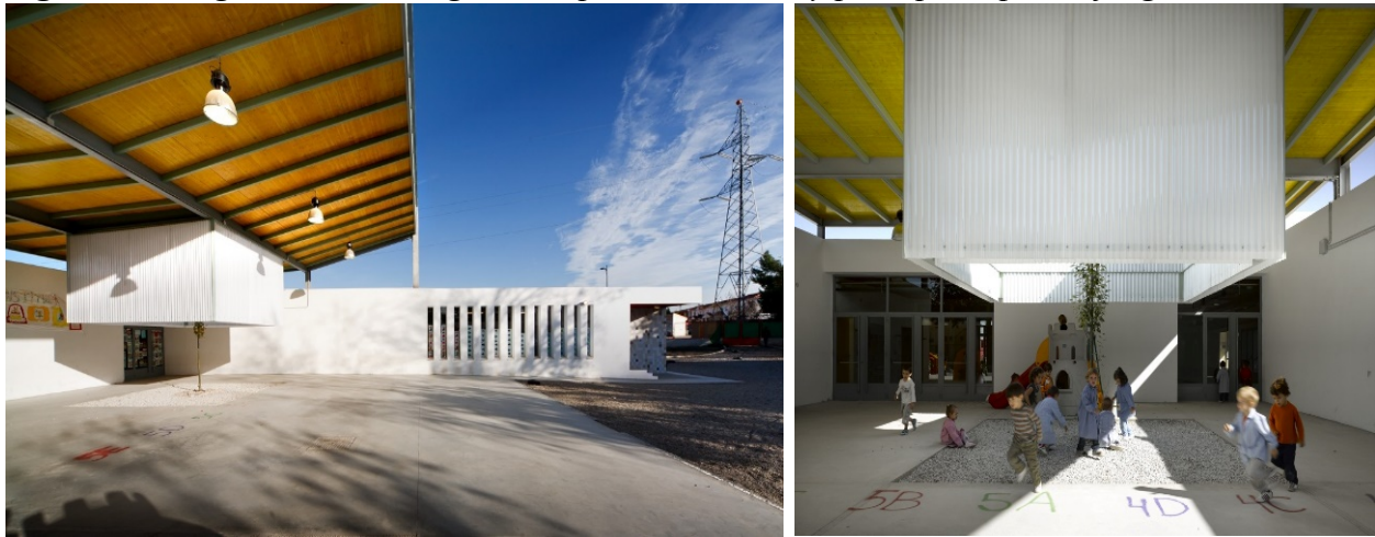
Figura 9. Colegio en Cullar Vega. Vista porche cubierto y patio principal de juegos.
