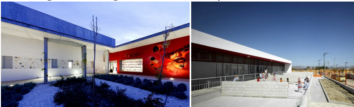
Figura 10. Colegio en Cullar Vega. Vista áreas exteriores y aulas al aire libre.
