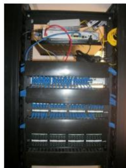
Ilustración 7. Registro fotográfico antes de la instalación. Tomado de: Documentación área Implementación CLARO S.A.
