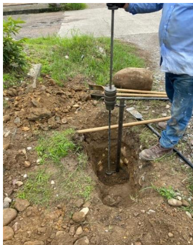
Ilustración 8.6. Ensayo de penetración de cono dinámico.
