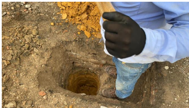
Ilustración 8.7. Excavación para el estudio de suelos en la zona de estudio.
