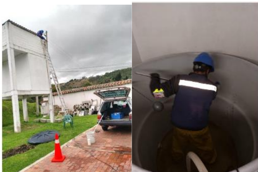
Ilustración 21: Lavado de tanques de agua potable parque cementerio
