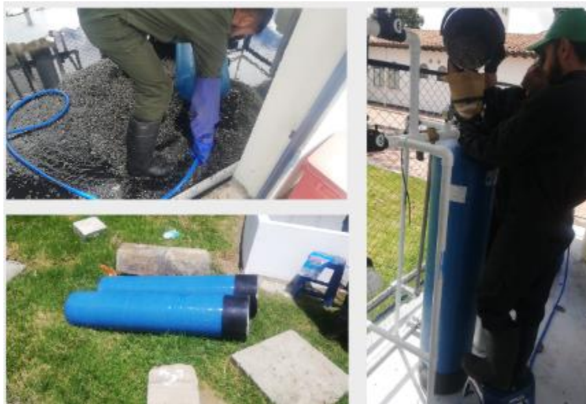
Ilustración 10: Cambio material filtrante filtros de arena y carbón activado
