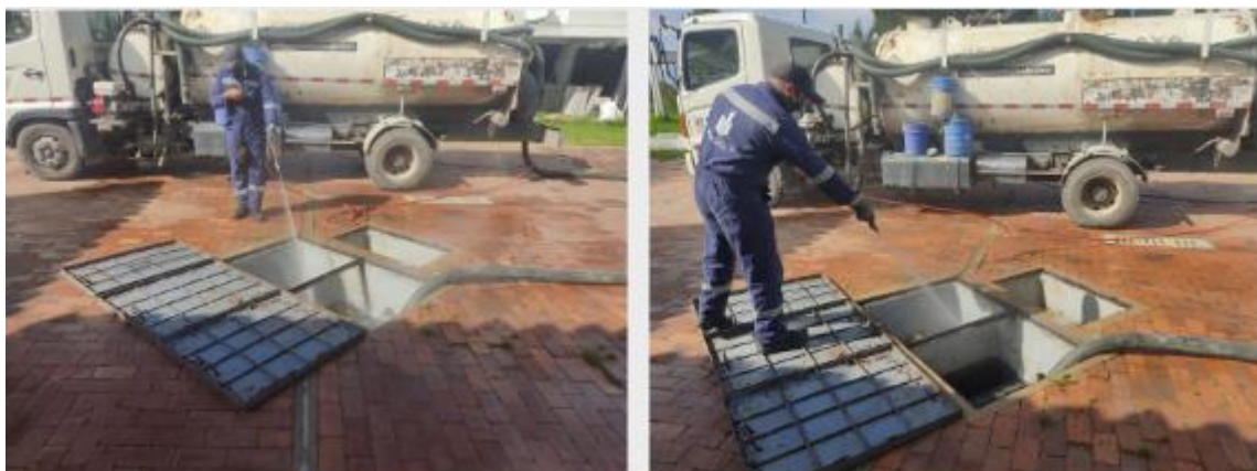
Ilustración 9: Succión y lavado de trampa de grasas
