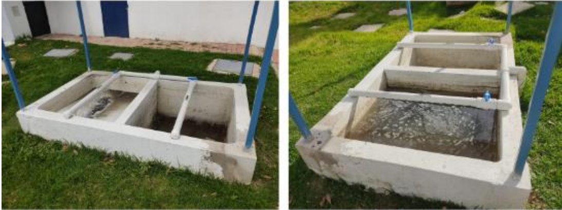
Ilustración 8: Drenaje de lodos a lechos de secado
