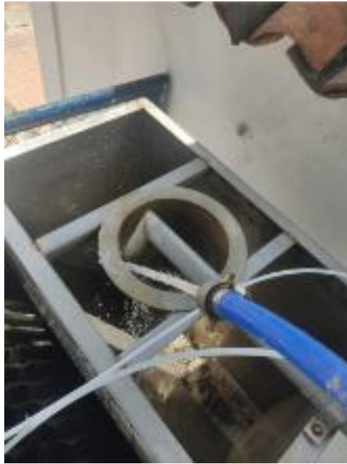
Ilustración 6: Lavado panel de sedimentación y cono de mezcla reactor de oxidación
