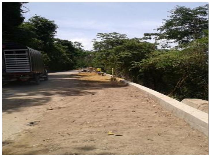
FOTO 6: CONSTRUCCIÓN BORDILLO Y RELLENO.
