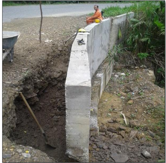
FOTO 5: K 26+950 MURO DE CONTENCIÓN
