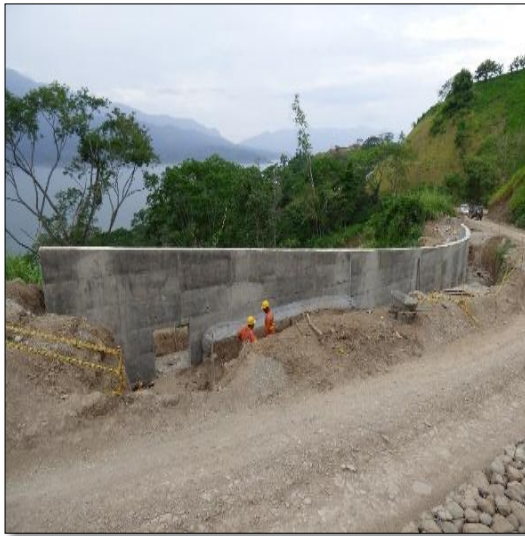
FOTO 1 Y 2: CONSTRUCCIÓN FILTRO MURO DE CONTENCIÓN, K 24+500 – K 24+650
