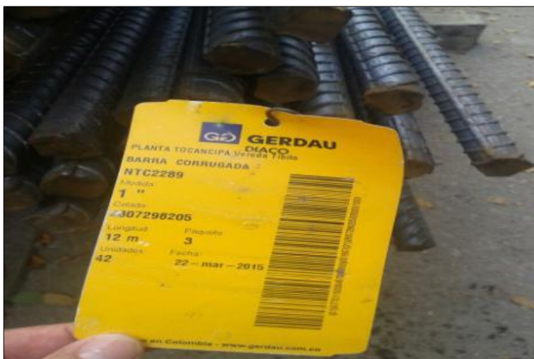
FOTO 3: REFERENCIA ACERO UTILIZADO EN LA ARMADURA
