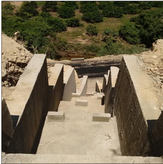
FOTO 1 Y 2: CONSTRUCCIÓN DISIPADORES DE ENEGIA K 4+380 y K 4+390
