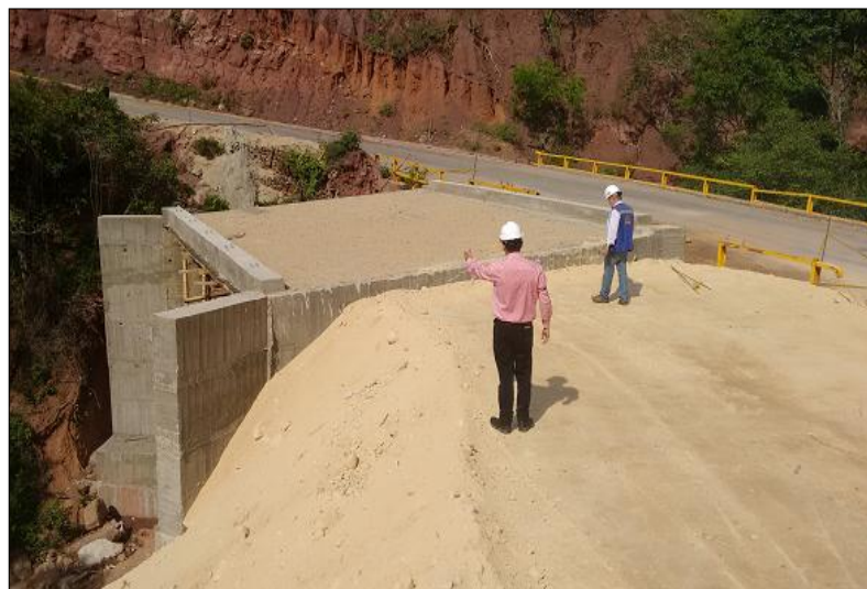
FOTO 6: CONFORMACIÓN DEL RELLENO
