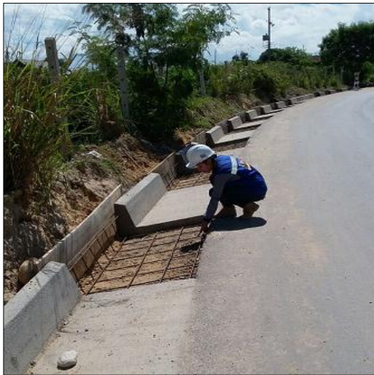
FOTO 1 Y 2: CONSTRUCCIÓN CUNETAS.
