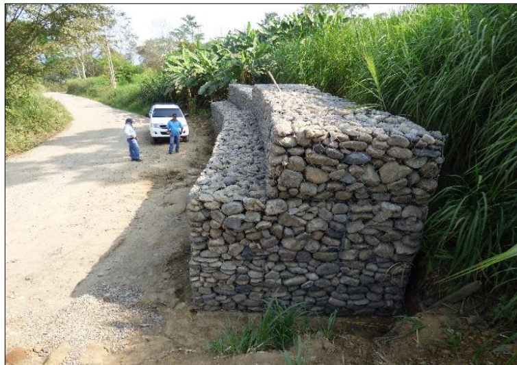
FOTO 3: MURO EN GAVIONES K 25+742
