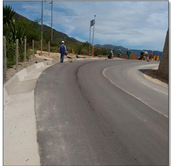
FOTO 1 Y 2: CONSTRUCCIÓN CUNETAS.
