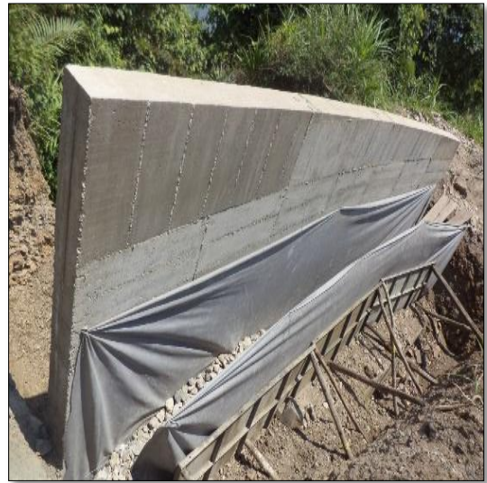
FOTO 1 Y 2: CONSTRUCCIÓN FILTRO MURO DE CONTENCIÓN, K 24+500 – K 24+650
