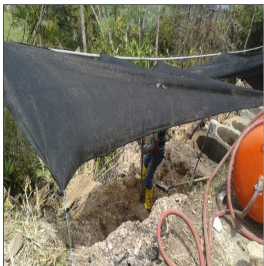
FOTO 1: EXCAVACIÓN Y FUNDIDA DE NUCLEOS DE CAISSONS, FOTO 2: AMARRE ACERO DE REFUERZO
