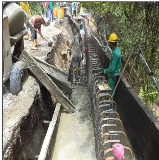
FOTO 5: FUNDICIÓN DE VIGA CABEZAL MODULO #7
