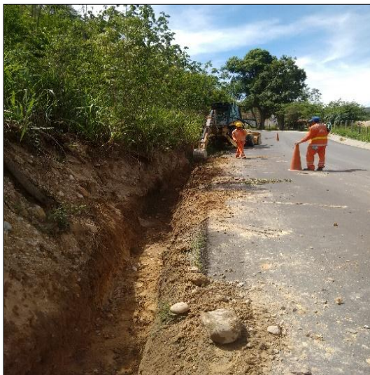
FOTO 3 Y 4: CONSTRUCCIÓN FILTROS.
