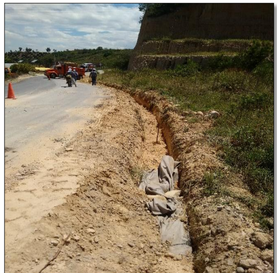
FOTO 3 Y 4: CONSTRUCCIÓN FILTROS.
