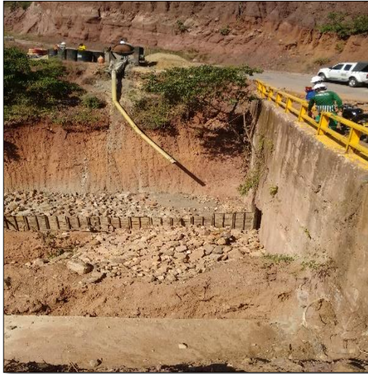
FOTO 1: RECUPERACION EN CONCRETO CICLOPEO FOTO 2: FUNDIDAD DE ZARPA PARA LOS DOS ESTRIBOS
