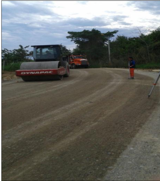
FOTO 1: COMPACTACIÓN DE SUB BASE
