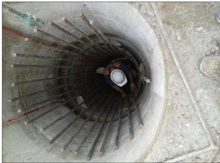
IMAGEN 5 Verificación, utilización línea de vida. Fuente. Autor
