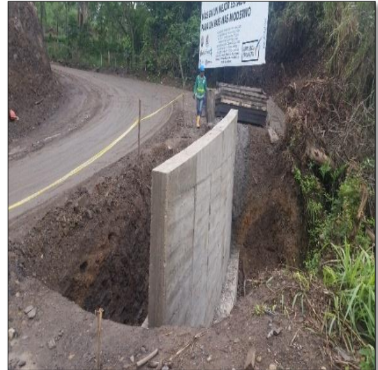
FOTO 2: K 24+650 MURO DE CONTENCIÓN
