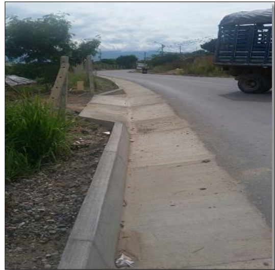
FOTO 1 Y 2: CONSTRUCCIÓN CUNETAS.
