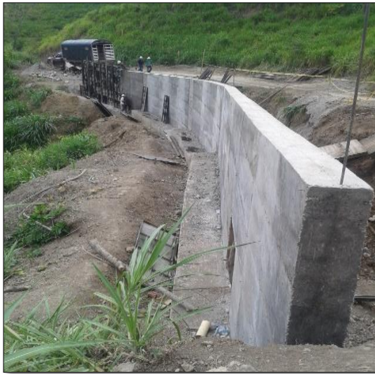
FOTO 1: K 24+500 MURO DE CONTENCIÓN
