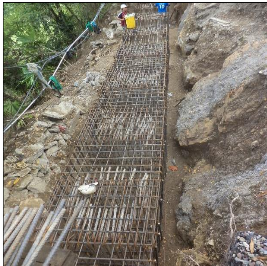
FOTO 4: ARMADO ACERO VIGA CABEZAL MODULO # 5
