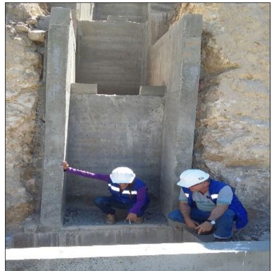
FOTO 1 Y 2: CONSTRUCCIÓN DISIPADORES DE ENEGIA K 4+380 y K 4+390
