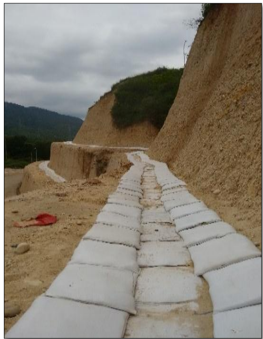
FOTO 1 Y 2: ZANJAS DE CORONACIÓN K 4+200 – K 4+450
