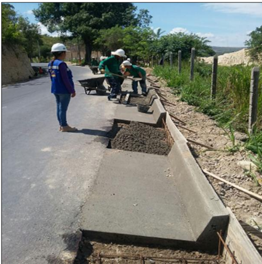
FOTO 1 Y 2: CONSTRUCCIÓN CUNETAS.
