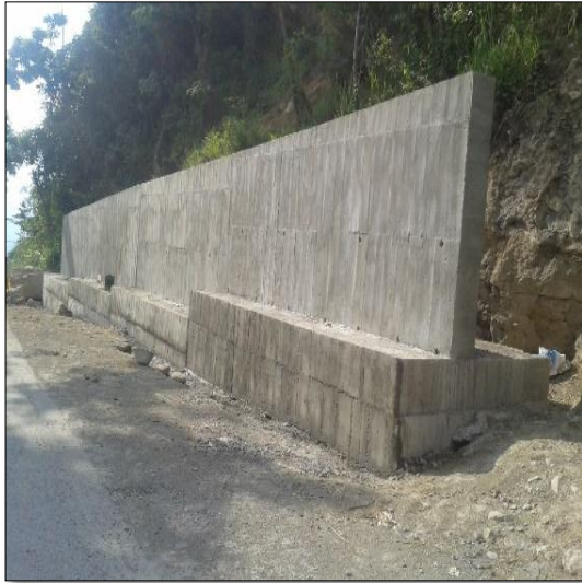
FOTO 4:K 26+600 MURO ALCANCÍA
