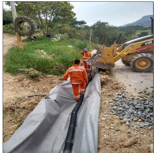
FOTO 3 Y 4: CONSTRUCCIÓN FILTROS.
