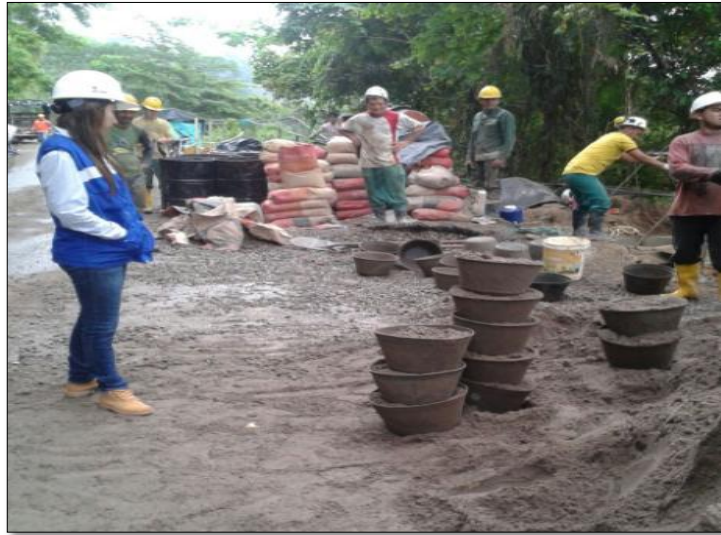
IMAGEN 3 Supervisión, dosificación de materiales.
