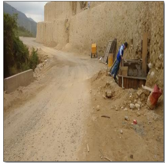
FOTO 2: CONSTRUCCIÓN CABEZOTE ALCANTARILLA K 4+380
