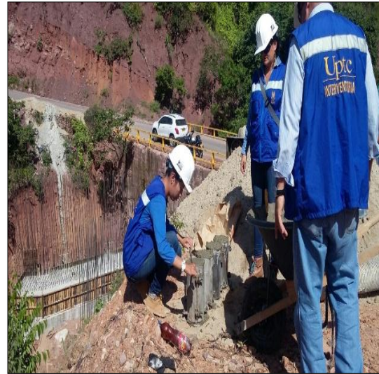
FOTO 2: TOMA DE MUESTRAS DE CILINDROS DE CONCRETO
