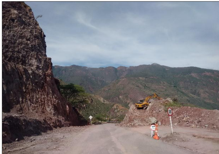
FOTO 1, 2 3: CORTE Y PERFILADO DE TALUD PARA LA CONSTRUCCIÓN DE UN MURO DE CONTENCIÓN TIPO ALCANCÍA
