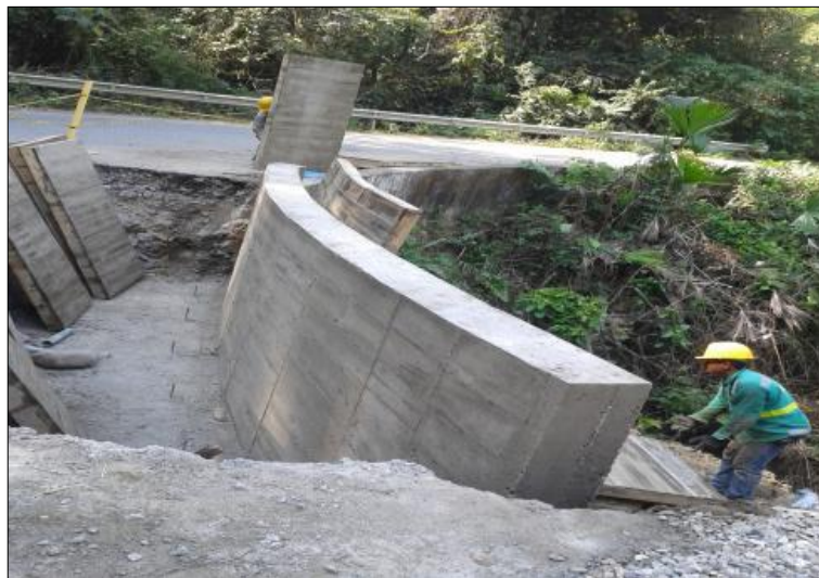
FOTO 6: K 30+100 MURO DE CONTENCIÓN
