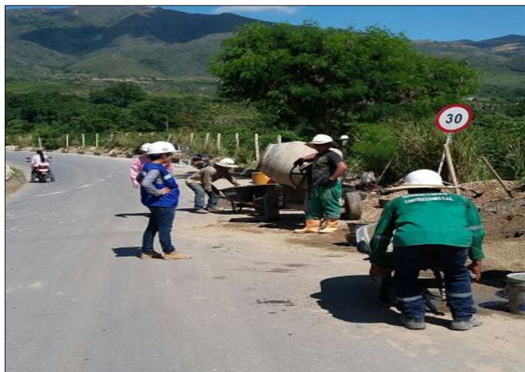
FOTO 3: SUPERVISIÓN DOSIFICACIÓN CONCRETO DE 3000 PSI.
