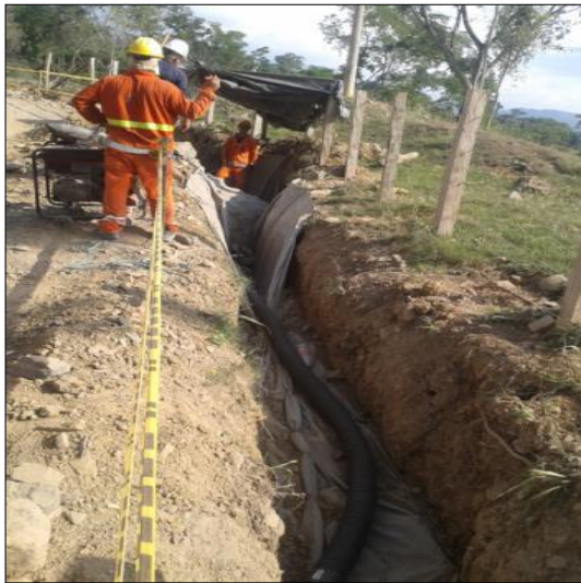
FOTO 3: CONSTRUCCIÓN FILTROS K 24+850.
