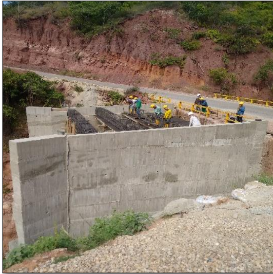
FOTO 4: ARMADO 4 VIGAS Y RIOSTRA
