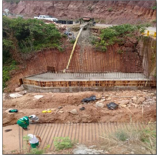
FOTO 1: RECUPERACION EN CONCRETO CICLOPEO FOTO 2: FUNDIDAD DE ZARPA PARA LOS DOS ESTRIBOS
