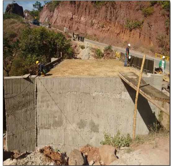
FOTO 5: CONSTRUCCION PLACA
