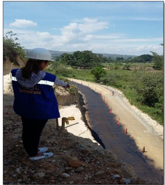
FOTO 2: IMPRIMACIÓN CON EMULSIÓN ASFÁLTICA
