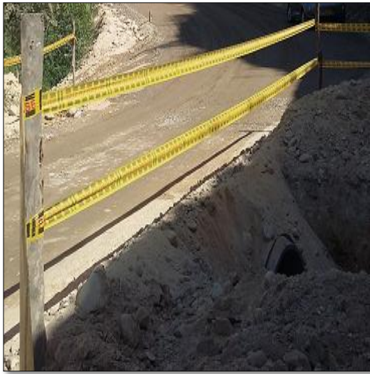
FOTO 1: INSTALACIÓN 9 TUBOS DE 36" ALCANTARILLA K 4+350
