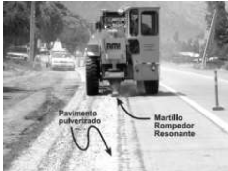
FIG. 1 EQUIPO RESONANTE PARA "RUBBLIZING" EN PAVIMENTO DE HORMIGÓN
